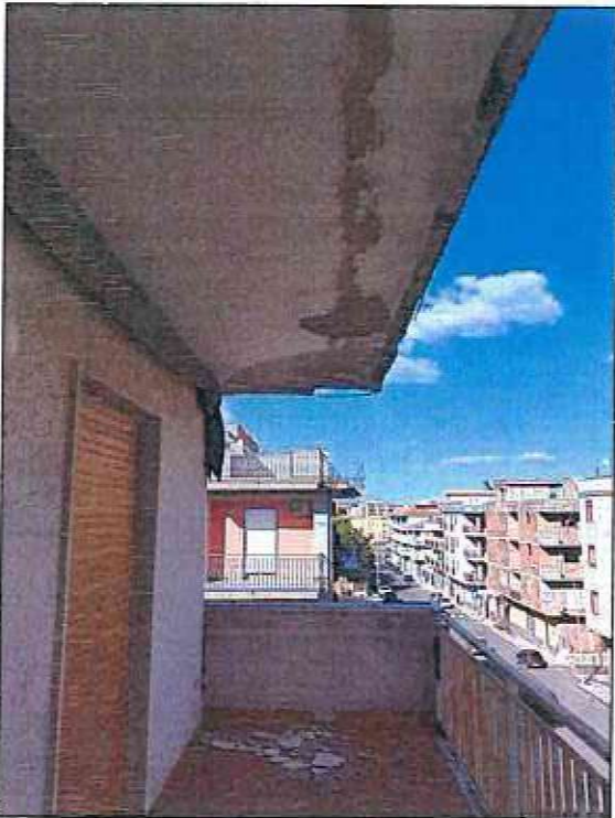
Foto 42-43 - Foto del balcone (sul quale si affaccia la camera 1) in mediocre stato conservativo e con cornicione a rischio di crollo di intonaco e parti strutturali. Vista della camera 2 con macchie di sporco nelle pareti e non in buono stato conservativo. Sono necessari lavori di manutenzione.
