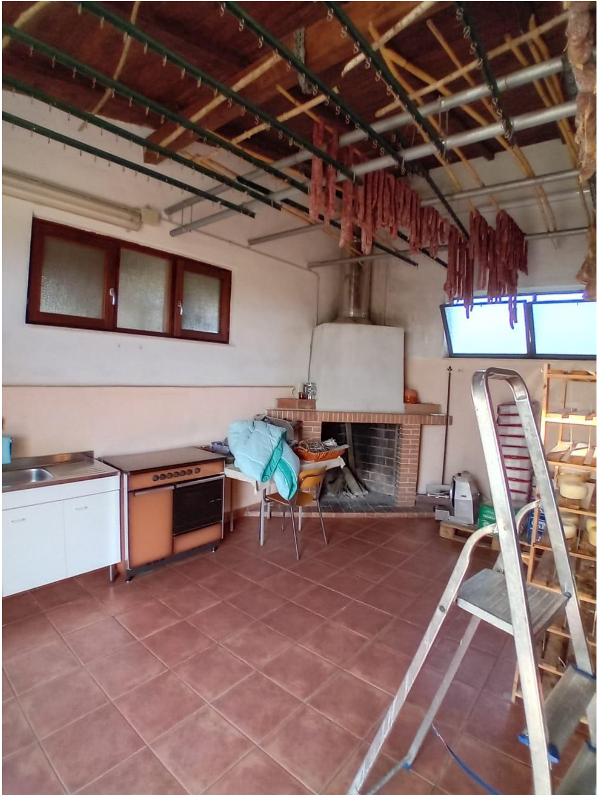
Foto n. 6 Essiccatoio (Foglio 17 p.lla 2176 sub 3)
