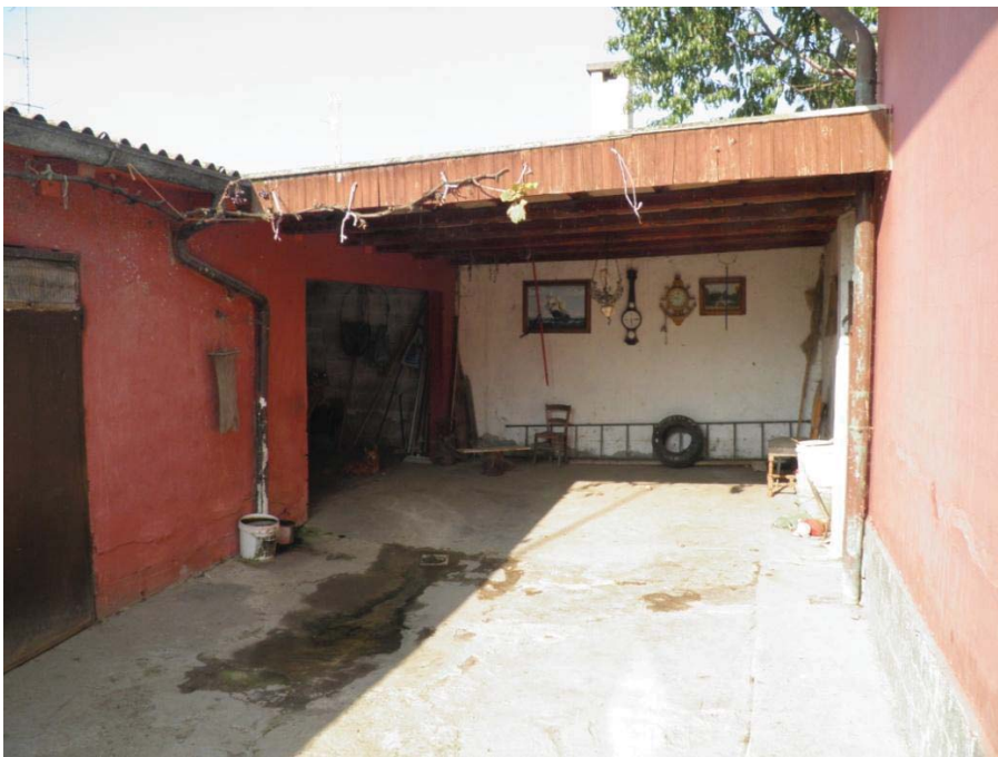
FOTOGRAFIA 18: Vista del portico prospiciente alla legnaia.
