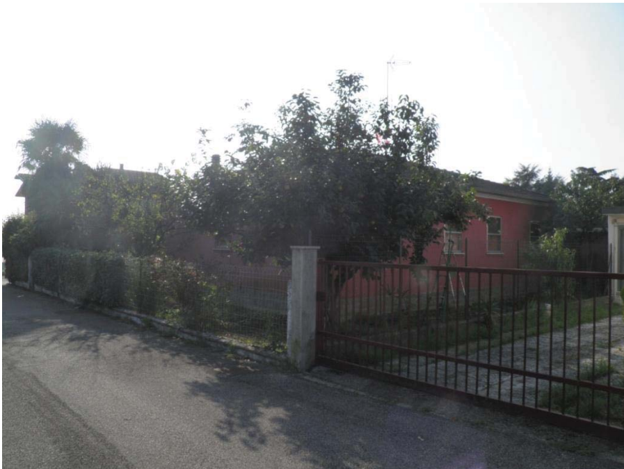
FOTOGRAFIA 2: Altra vista d'insieme del fabbricato.
