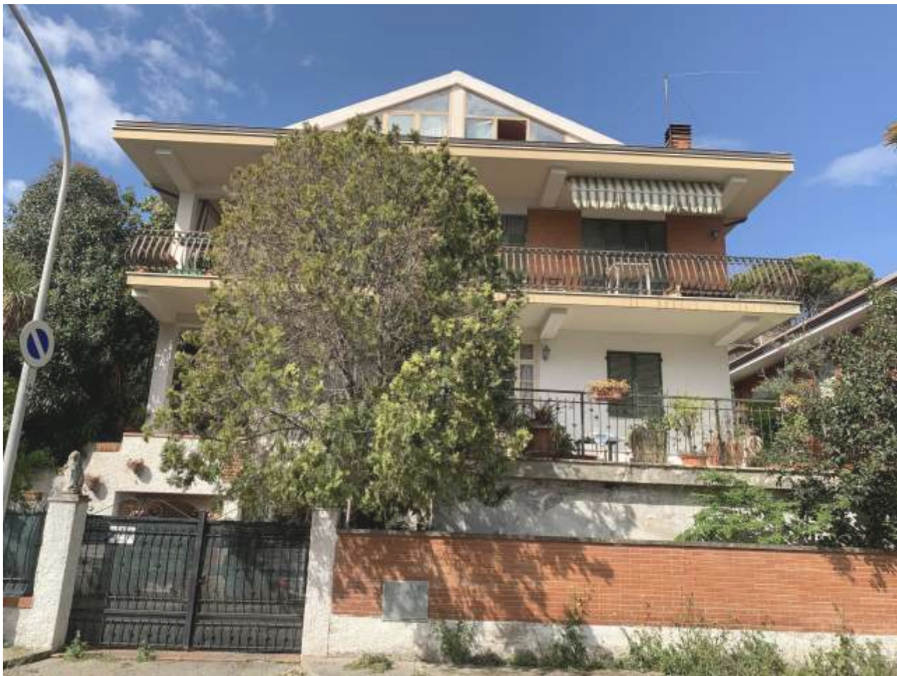
FOTO 1 – FRONTE SU VIA VECELLIO
