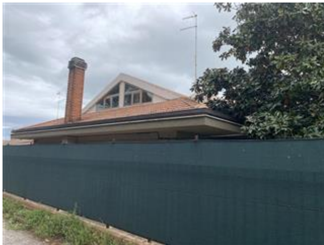
Fronte Ovest su Via Correggio
