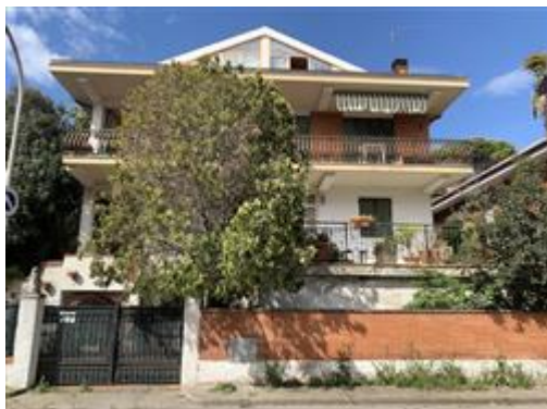
Fronte Est su Via Vecellio
