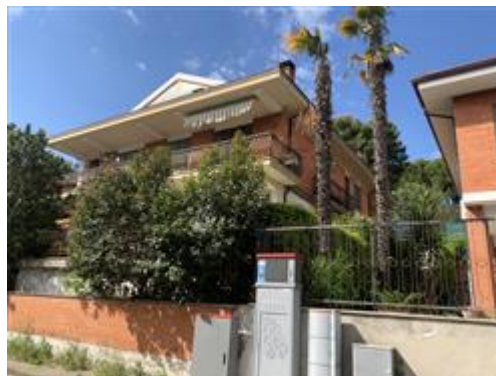
Fronte Est su Via Vecellio
