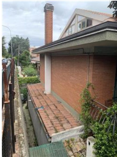
Fronte Ovest su Via Correggio
