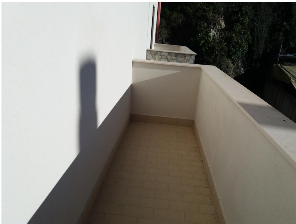
Foto n. 21: prospettiva balcone “b2” e balcone “b3” – piano primo
