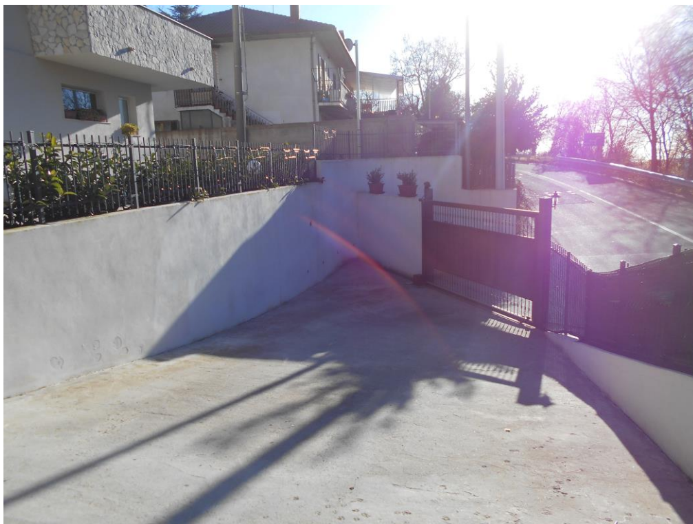
Foto n. 0: prospettiva ingresso unità oggetto di accertamento
