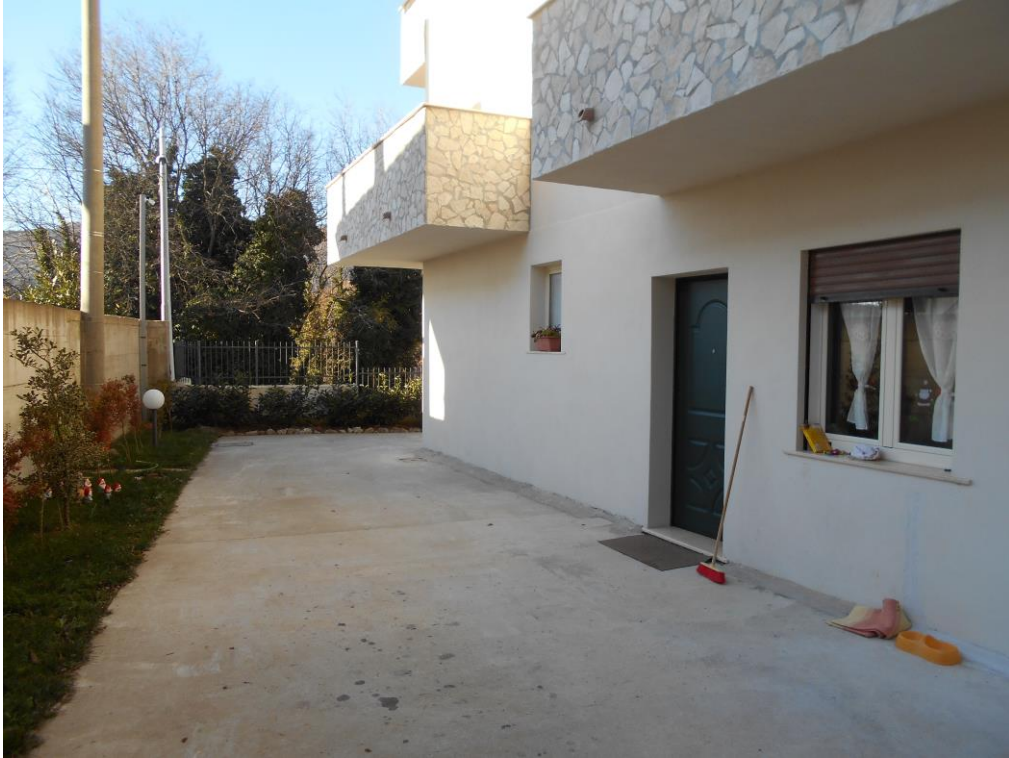
Foto n. 3: prospettiva unità oggetto di accertamento
