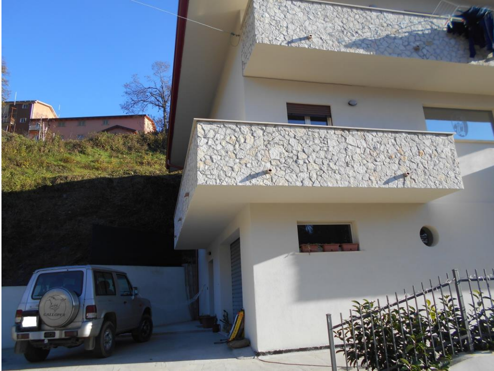
Foto n. 1: prospettiva unità oggetto di accertamento
