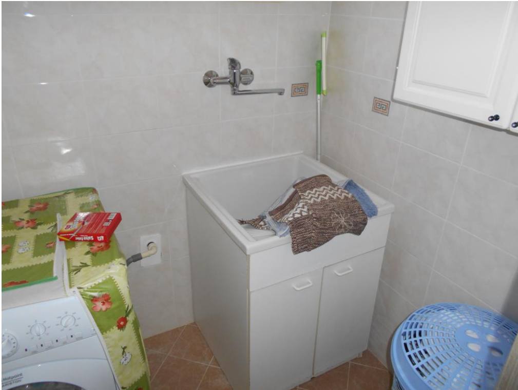
Foto n. 15: prospettiva vano “lav” – piano terra
