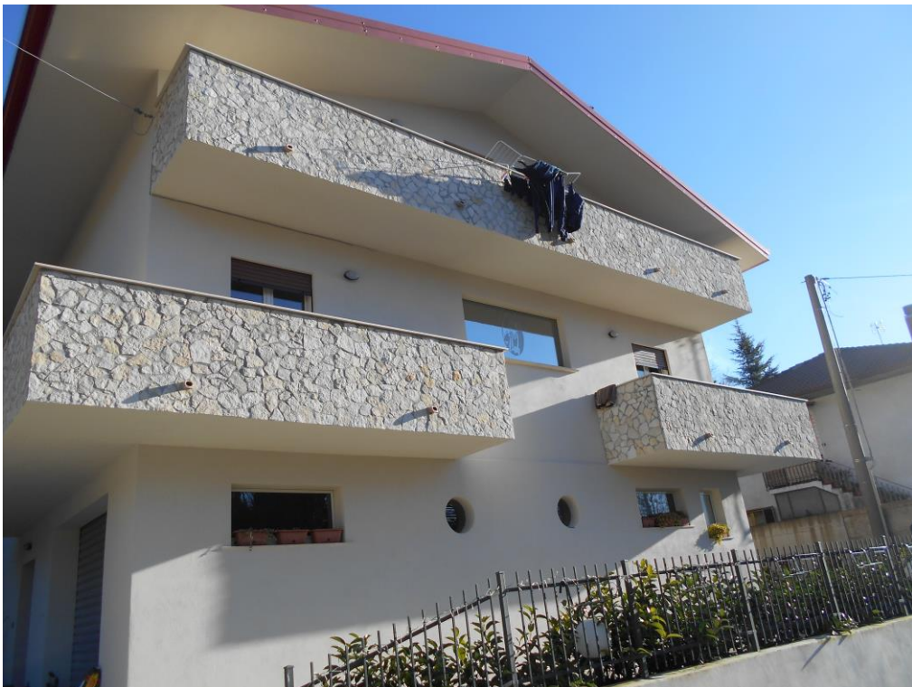
Foto n. 2: prospettiva unità oggetto di accertamento
