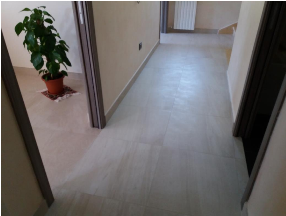
Foto n. 24: prospettiva corridoio “corr1” – piano primo
