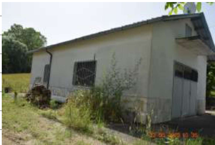
Vista d'insieme dell'Immobile di cui alla Part. 715
