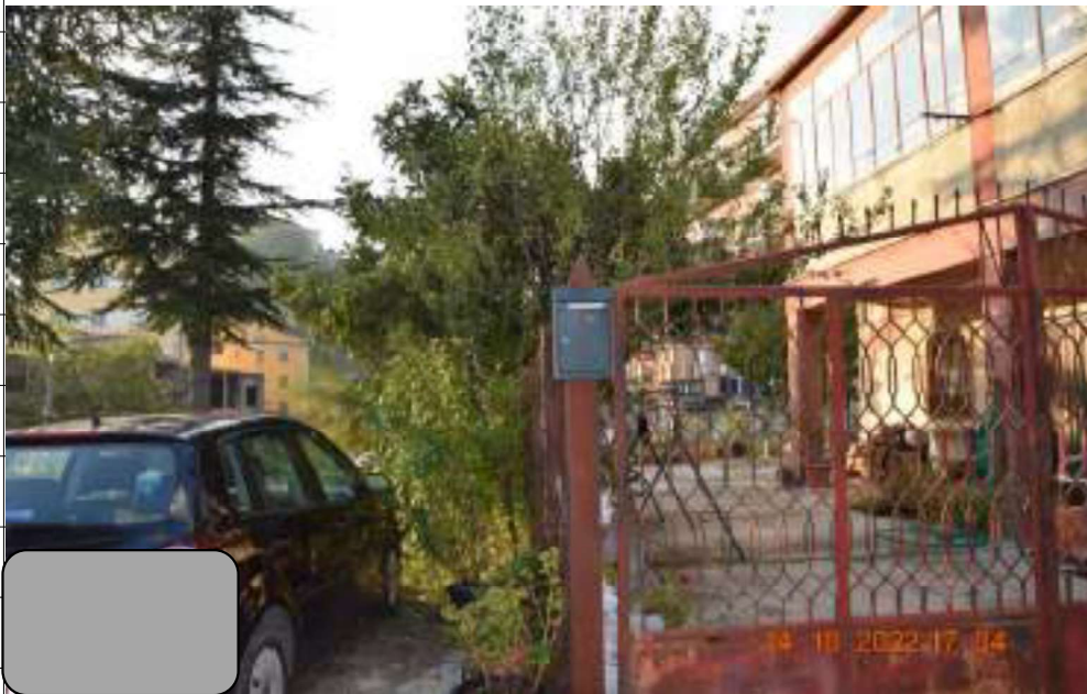
Ingresso Particella 266'' area adibita a corte del fabbricato di altra proprietà
