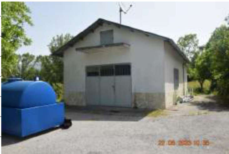
Vista d'insieme dell'Immobile di cui alla Part. 715
