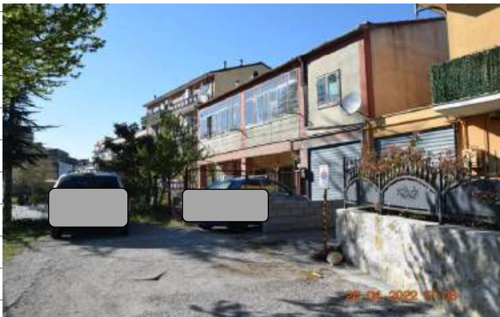
Ingresso Particella 266'' area adibita a corte fabbricato foglio 11 particella 197
