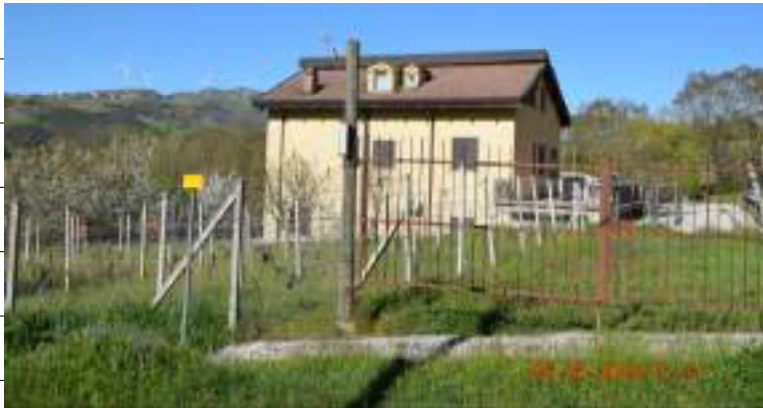
Vista d'insieme dell'Immobile di cui alla Part. 711
