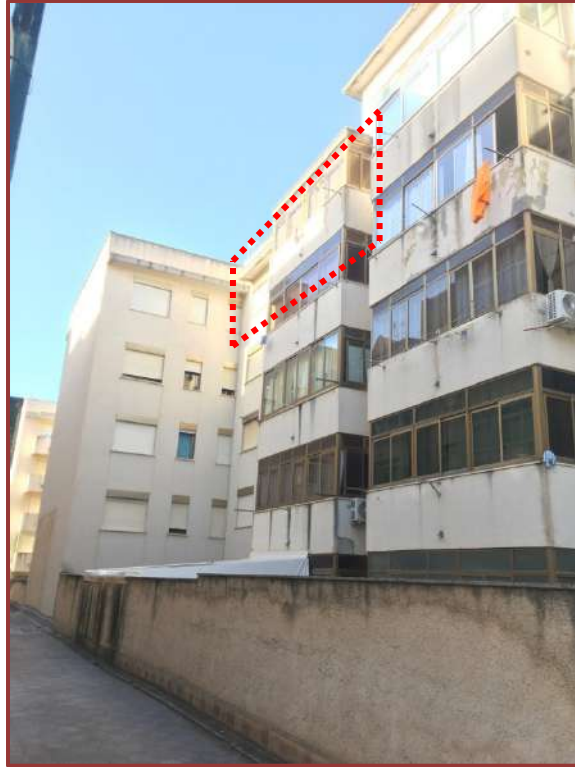
Foto 7 – Ingresso Fabbricato (n. B5) Accessi all'appartamento
