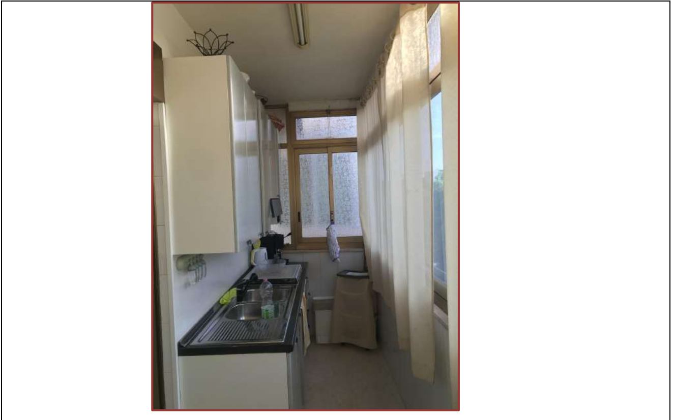
Foto 28 – Vista Balcone Cucina (Uso cucina – Abuso balcone chiuso con finestre)
