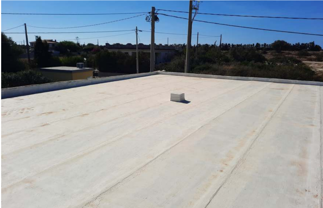
11 _il terrazzo di copertura
