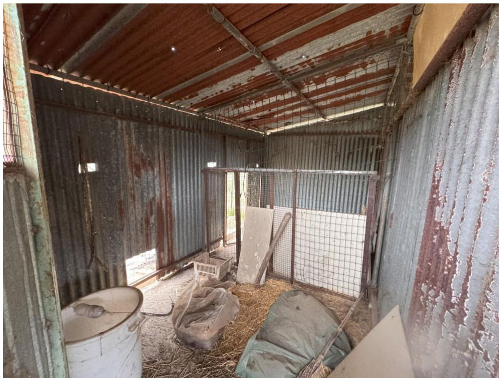
43. Vista di parte della rimessa
