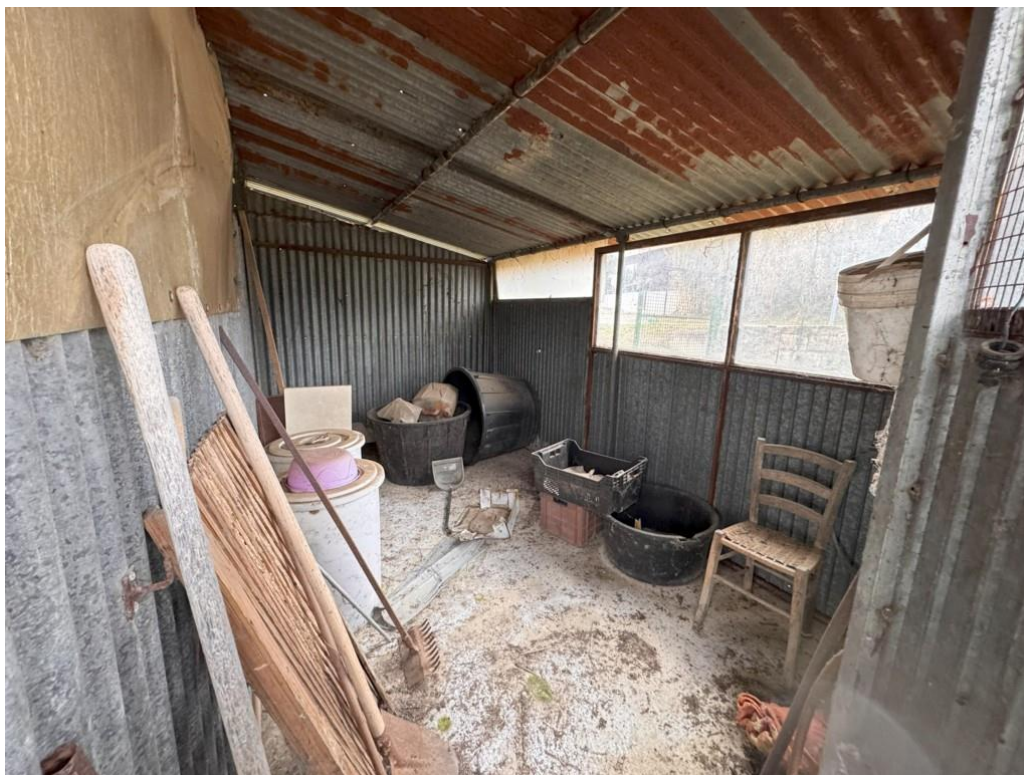
42. Vista di parte della rimessa
