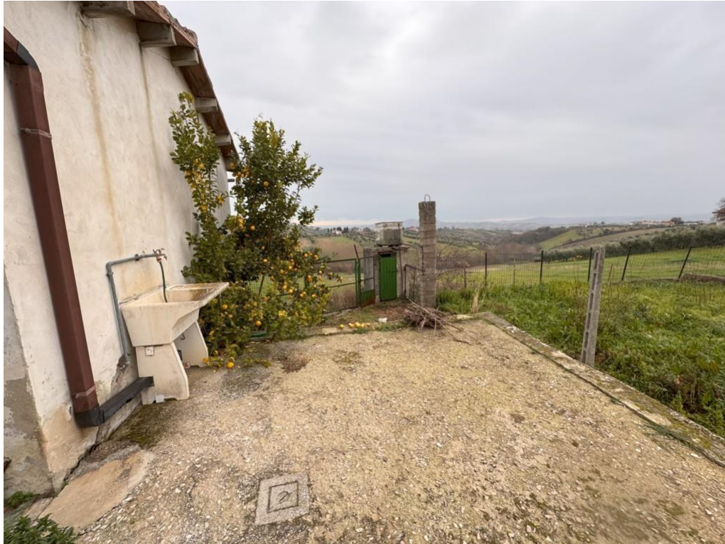
49. Vista del vecchio w.c. esterno
