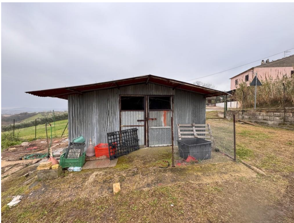
41. Vista del manufatto ad uso rimessa
