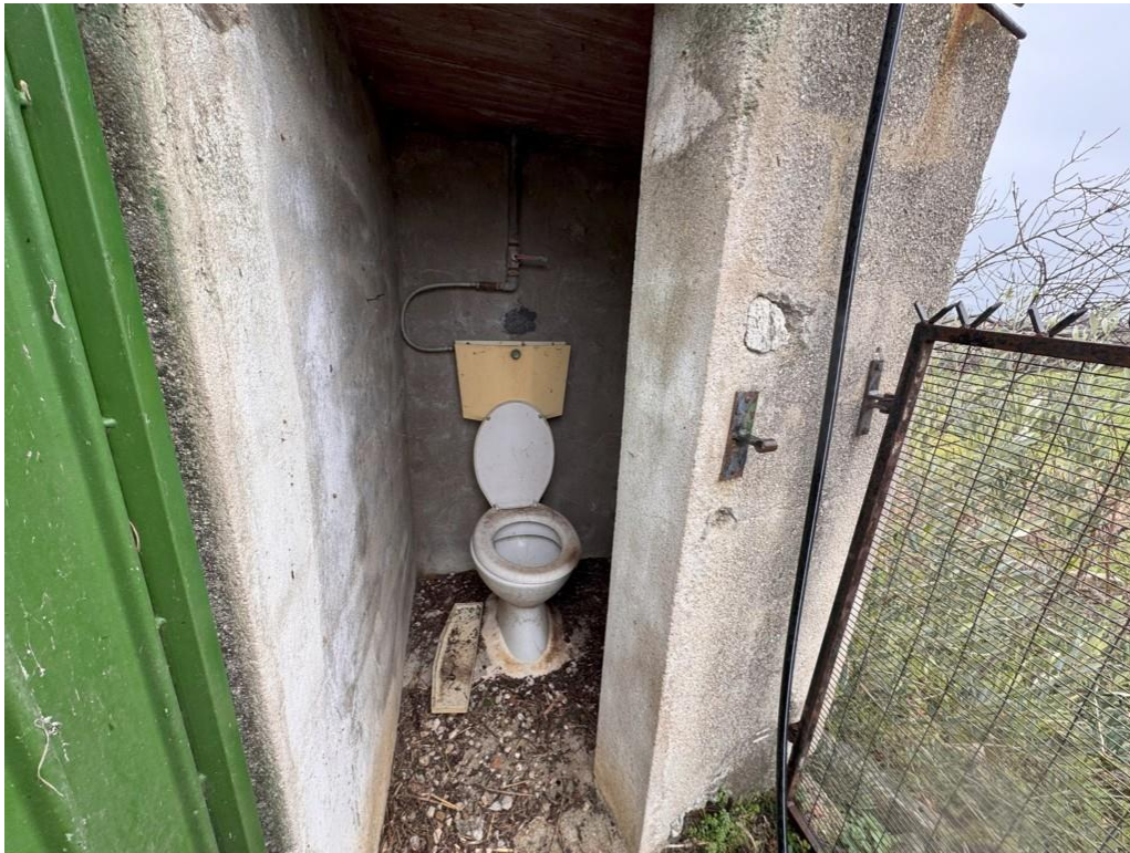
50. Vista del vecchio w.c. esterno
