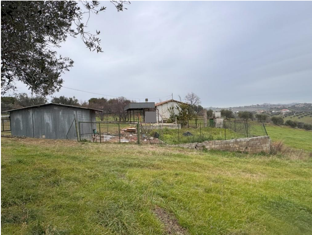
36. Vista degli immobili siti in Via San Savino di Nereto, oggetto di procedura
