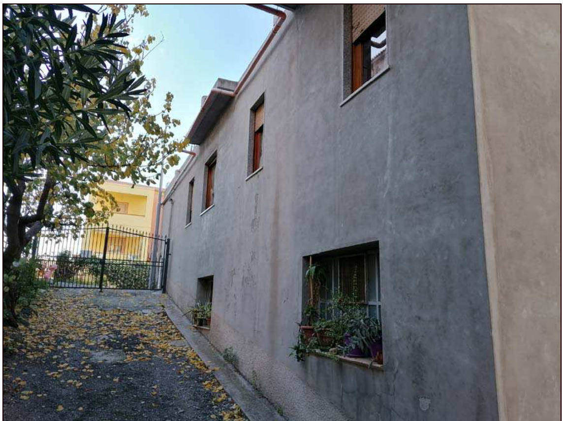
Foto 2 - Prospetto lato Sud-Est
