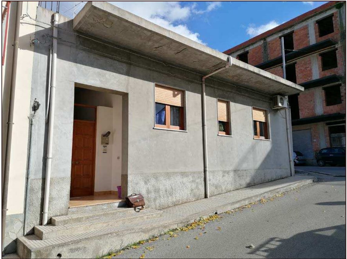
Foto 1 - Prospetto lato Sud-Ovest
