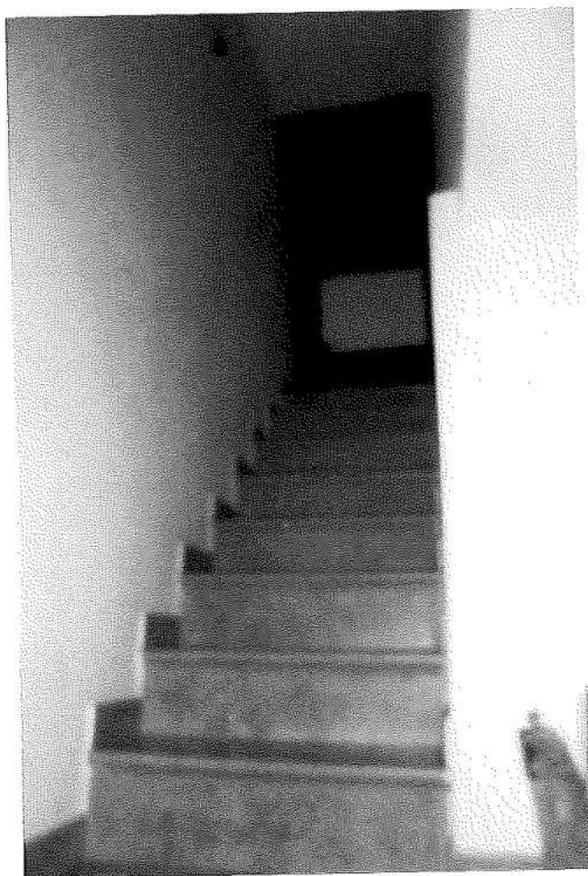
Foto n° 13 - scale di accesso al terrazzo e soffitta
