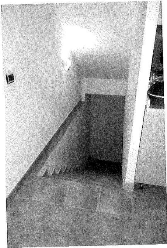
Foto n° 8 - scale di accesso al piano terra
