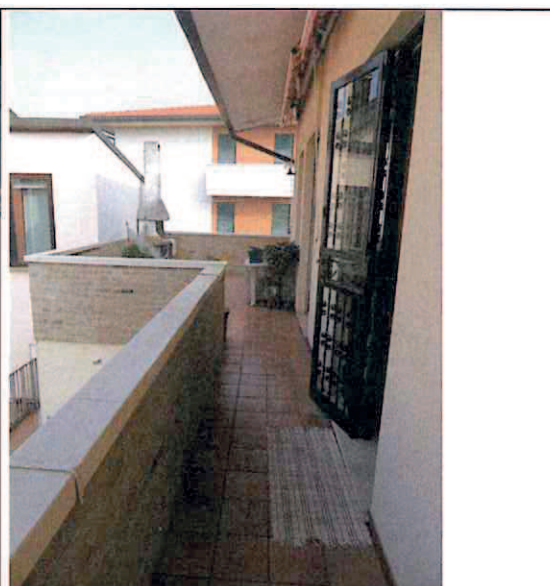
Foto n°8: Poggiolo di accesso all'immobile ed alla terrazza
