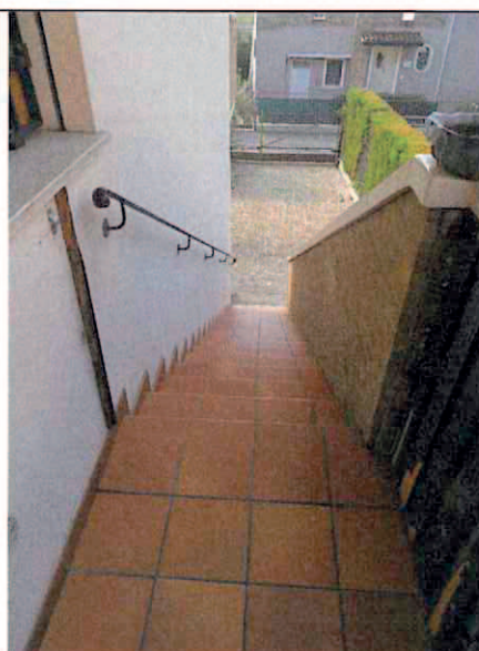
Foto n°7: Scala di accesso al P1°
