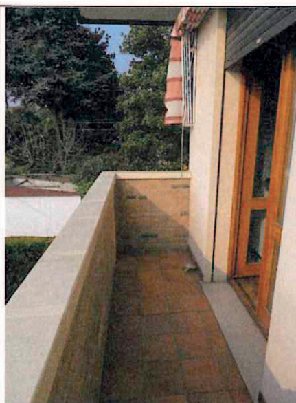
Foto n°23: Altra vista poggiolo a sud
