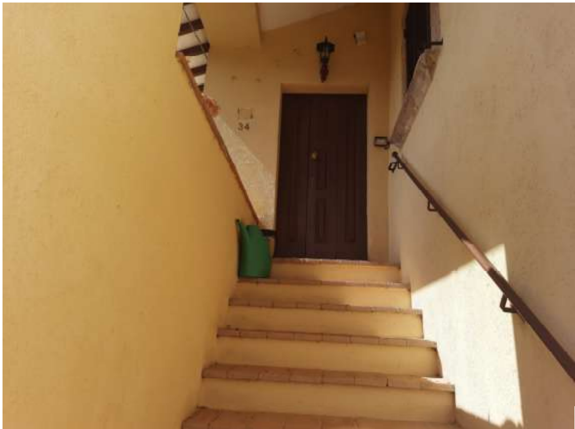
Foto n.2: Particolare delle scale di ingresso appartamento al primo e secondo piano
