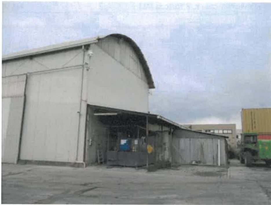
Corpo ripostiglio e tettoia
