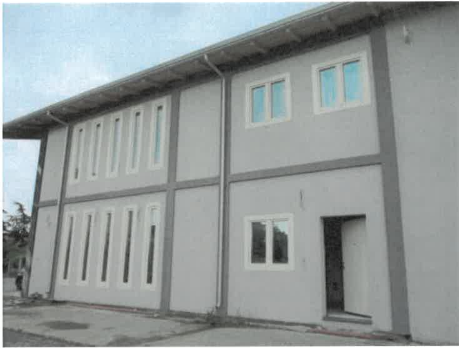
Corpo uffici – spogliatoi e archivio
