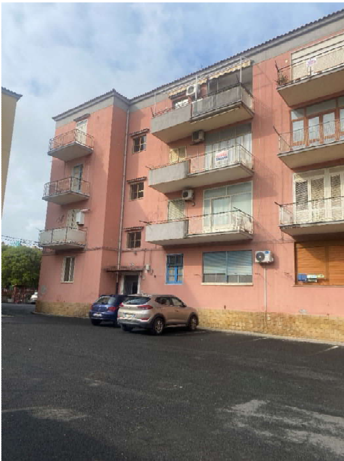
Foto 2: Vista prospetto principale
