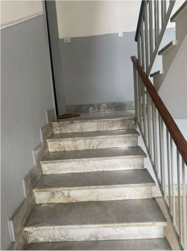
Foto 5: Vista porzione di scala condominiale
