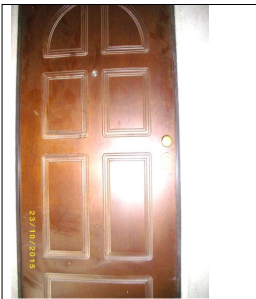
particolare del piano mansardato ( portone)
