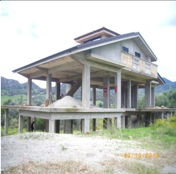
spigolo lato sud-est /nord-est visto da quota + 2.0 mt.
