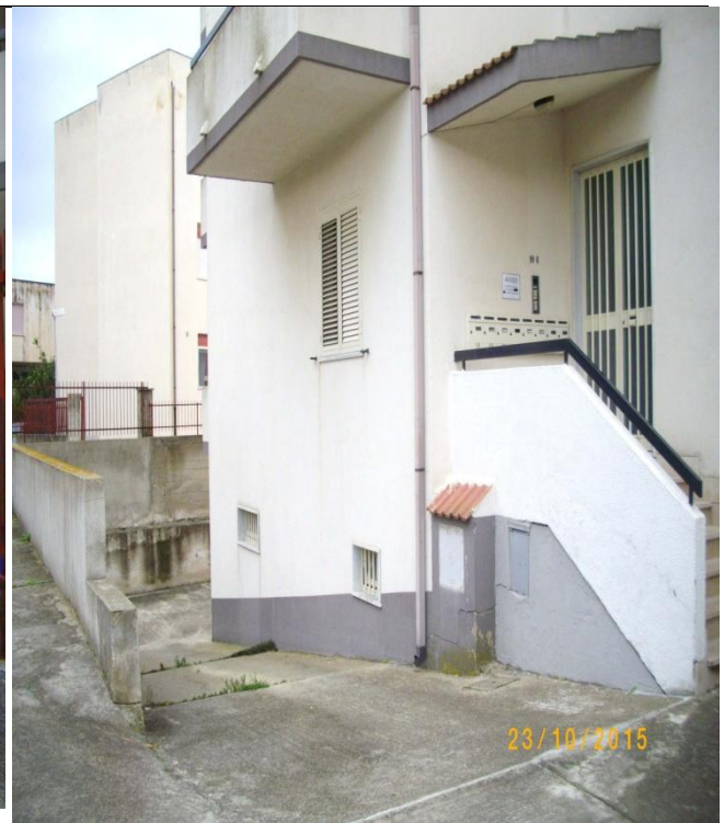
Rampa di accesso al piano seminterrato nel quale è collocato uno degli immobili esegutati – Box Auto
