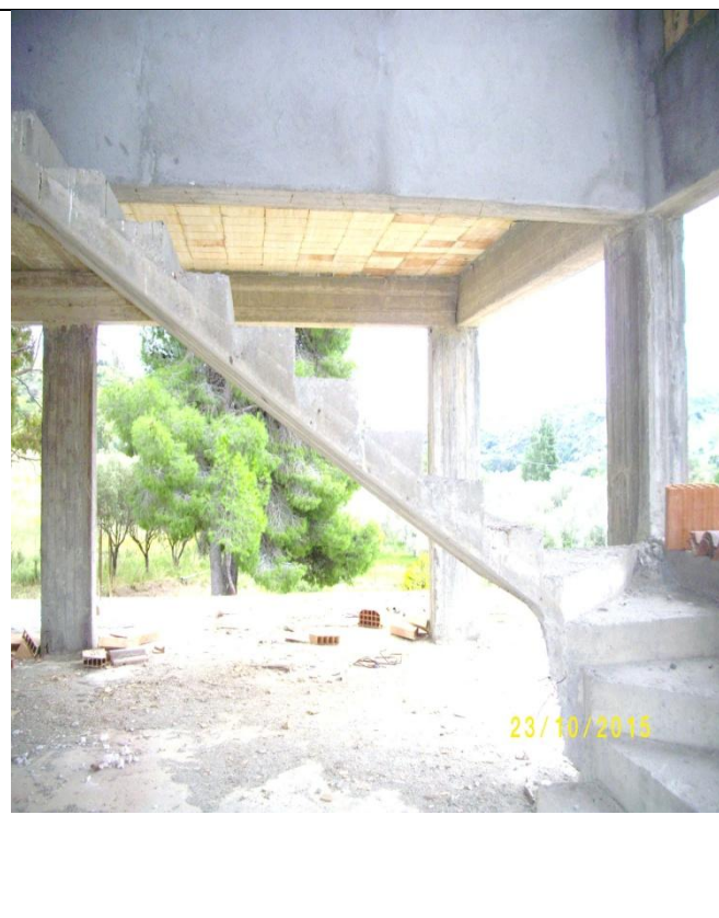
particolare del piano Primo ( pilastri e soletta) con veduta del secondo corpo scala che porta alla mansarda ( spigolo sud- ovest )
