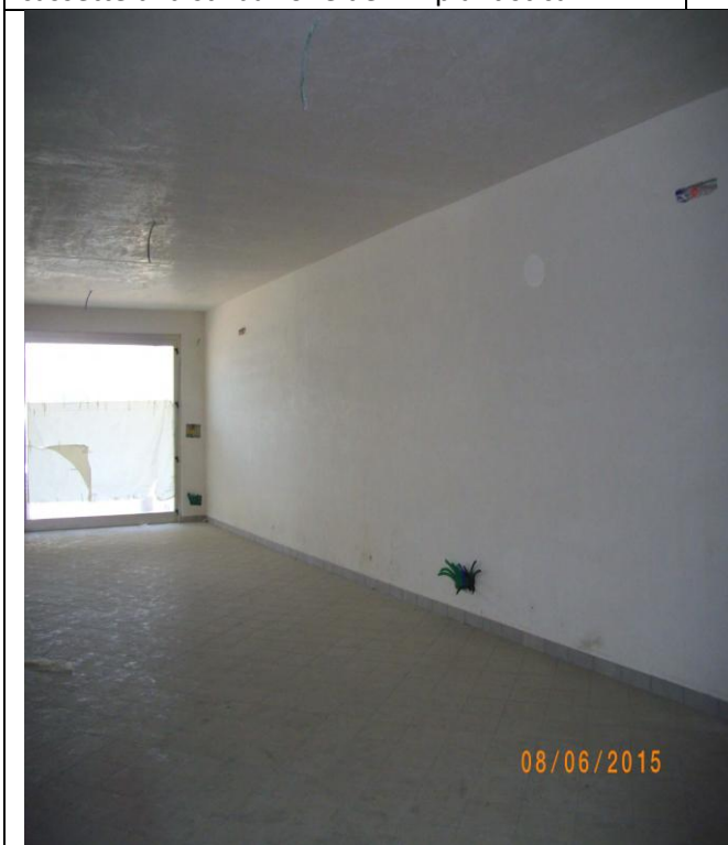
Veduta Interna del bene eseguito con dettagli dello stato di finitura e dell'impiantistica
