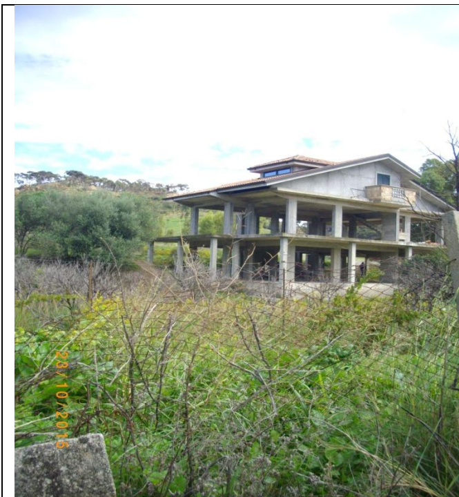
vista dalla strada provinciale dello spigolo tra fronte sud- ovest / nord ovest
