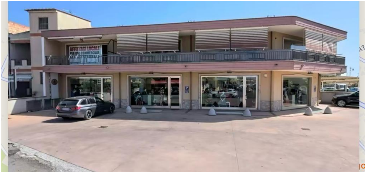
Veduta esterna edificio dove, al piano terra, è collocato il bene esecutato adibito a negozio di abbigliamento
