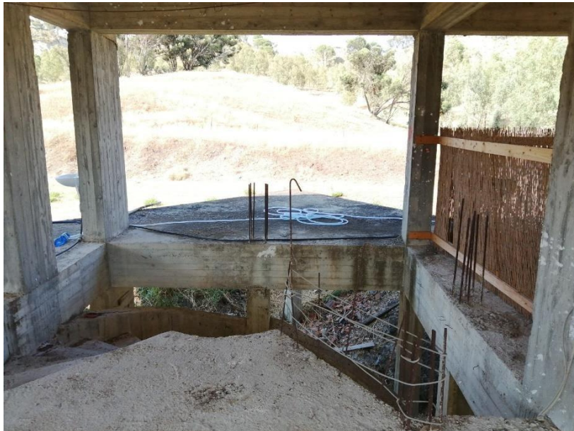
Particolare accesso al piano primo
