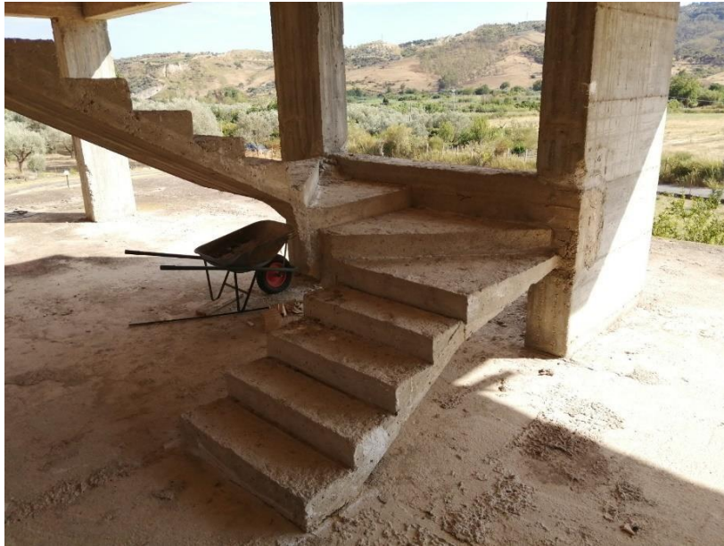
Particolare scala collegamento tra piano primo e mansarda
