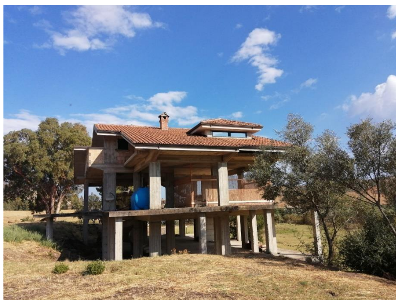
Vista dall'interno della corte fronte nord-ovest
