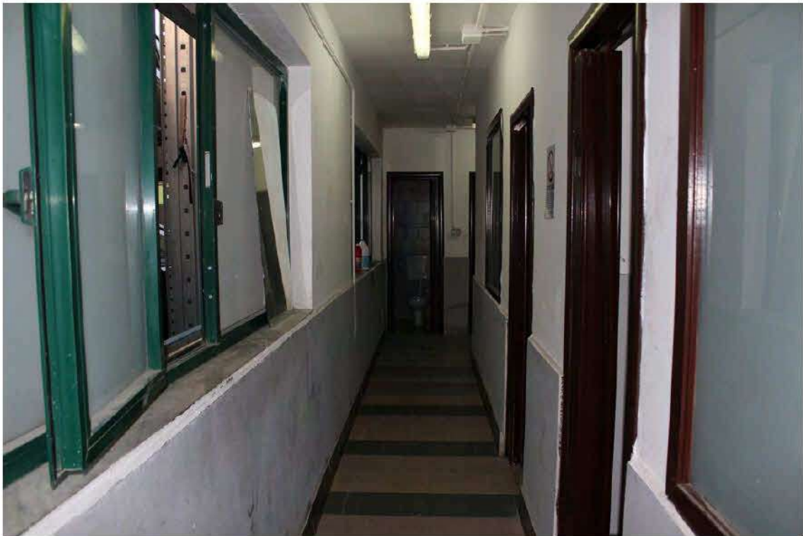
Foto 25: corridoio pavimentato in grés, con due spogliatoi sulla dx e bagni in fondo.
