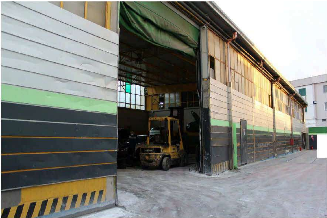
Foto 20: ampio accesso al locale di lavorazione, dotato di uscita di sicurezza.
