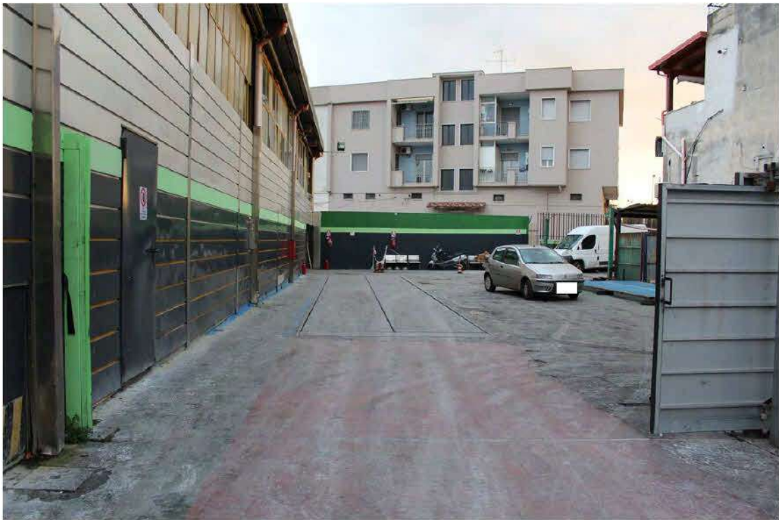
Foto 18: area esterna e facciata principale del capannone con rivestimento in alluminio.
