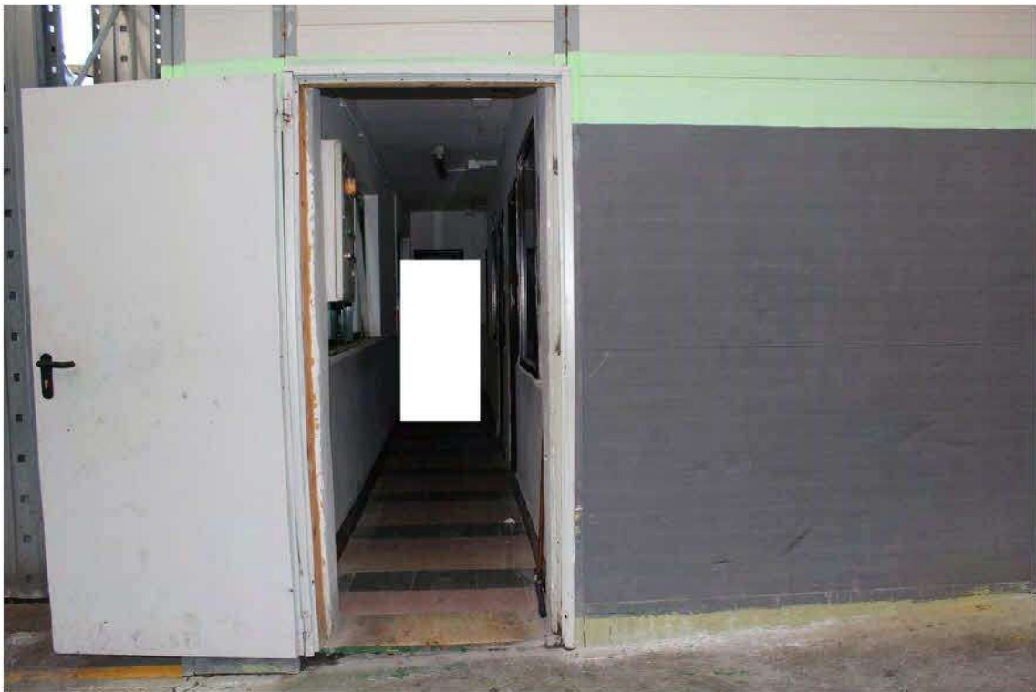
Foto 24: porta di accesso ai locali di servizio: spogliatoi, depositi e bagni.
