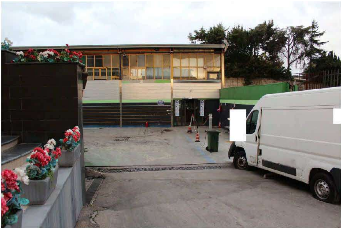
Foto 6: accesso al capannone industriale, identificato catastalmente col sub 20.
