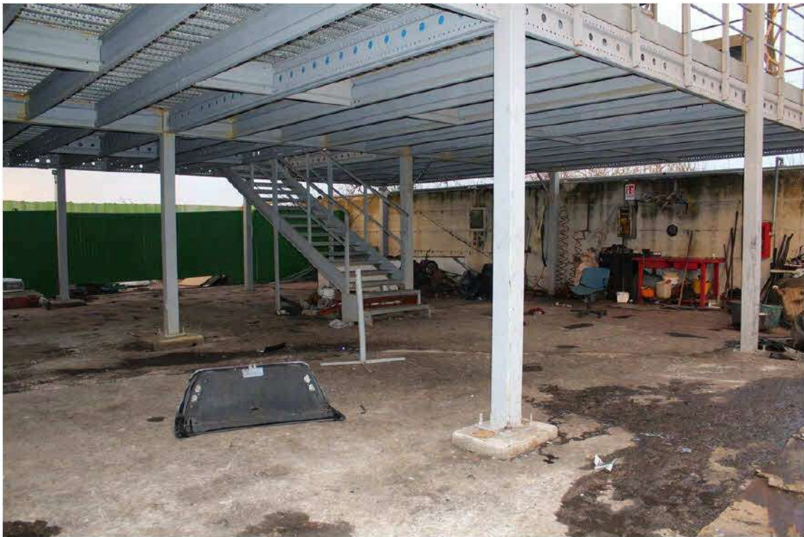
Foto 32: scala in ferro della scaffalatura Sigma di altezza di circa 6 m.
