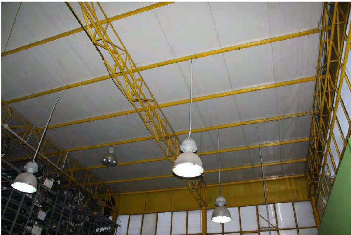
Foto 10: area uffici: copertura con travi reticolari sormontate da onduline zincate.
