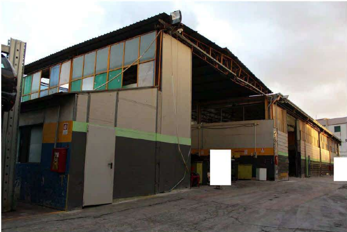
Foto 23: struttura addossata al capannone, destinata ai servizi (altezza min. 3,2 m).
