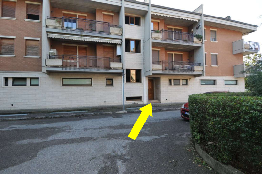
LOTTO 3 – Foto 2 – Esterno lato Nord. La freccia indica il portone d'ingresso.
