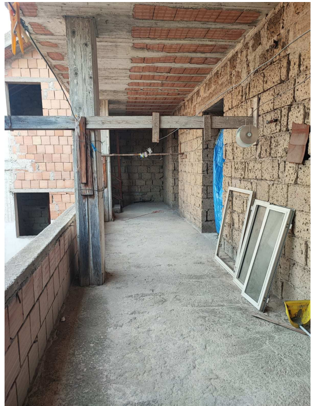
Ballatoio del 1° piano (altra vista)
