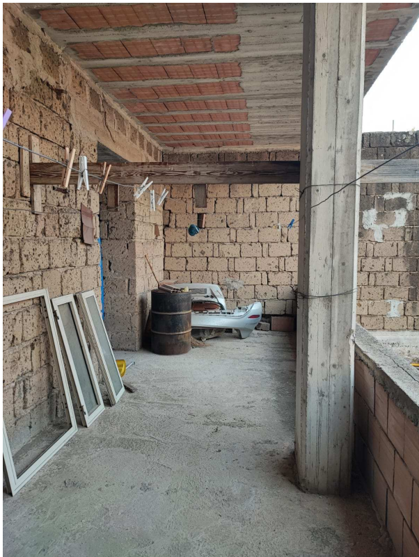
Ballatoio del 1° piano
