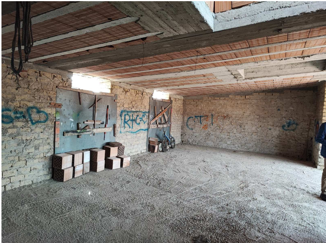
Vano 4 (altra vista)
