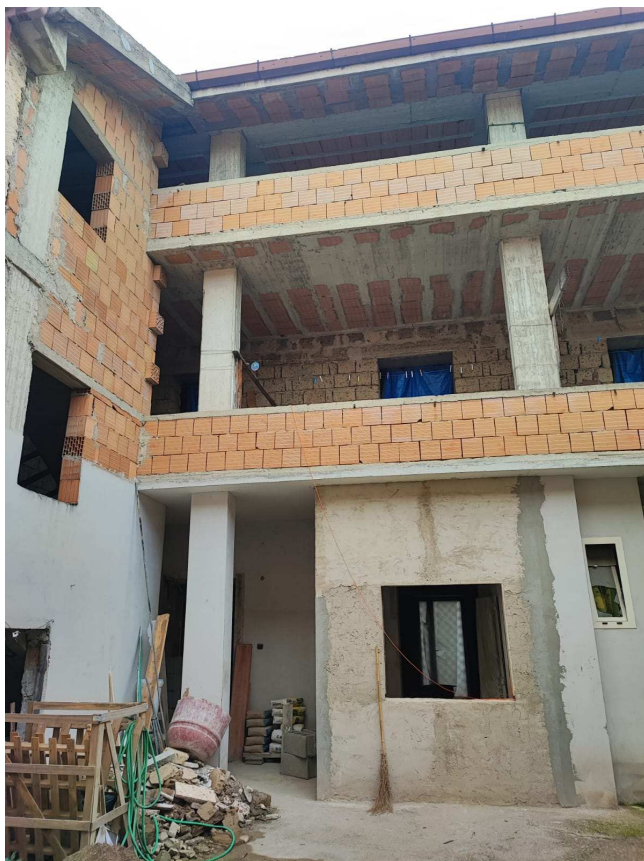
Prospetto del fabbricato visto dall'area cortilizia
