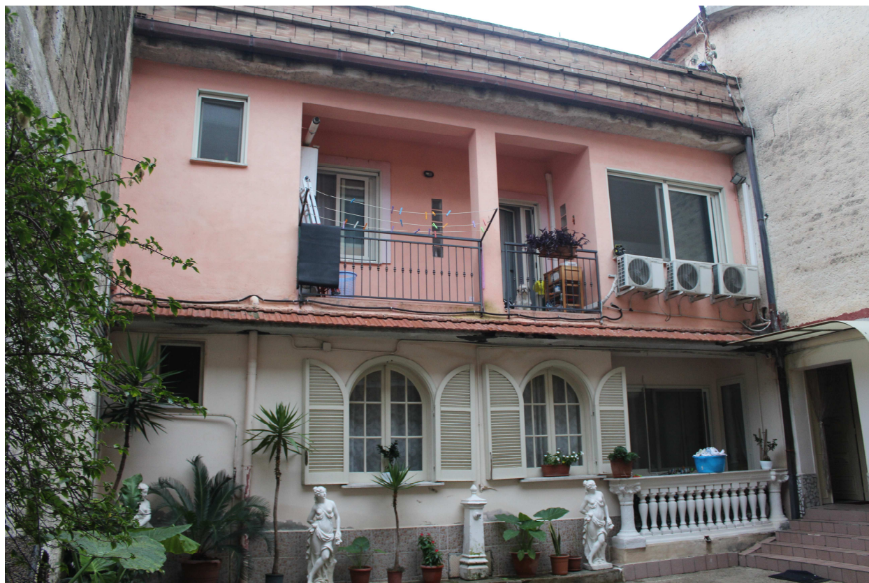
Prospetto del fabbricato
