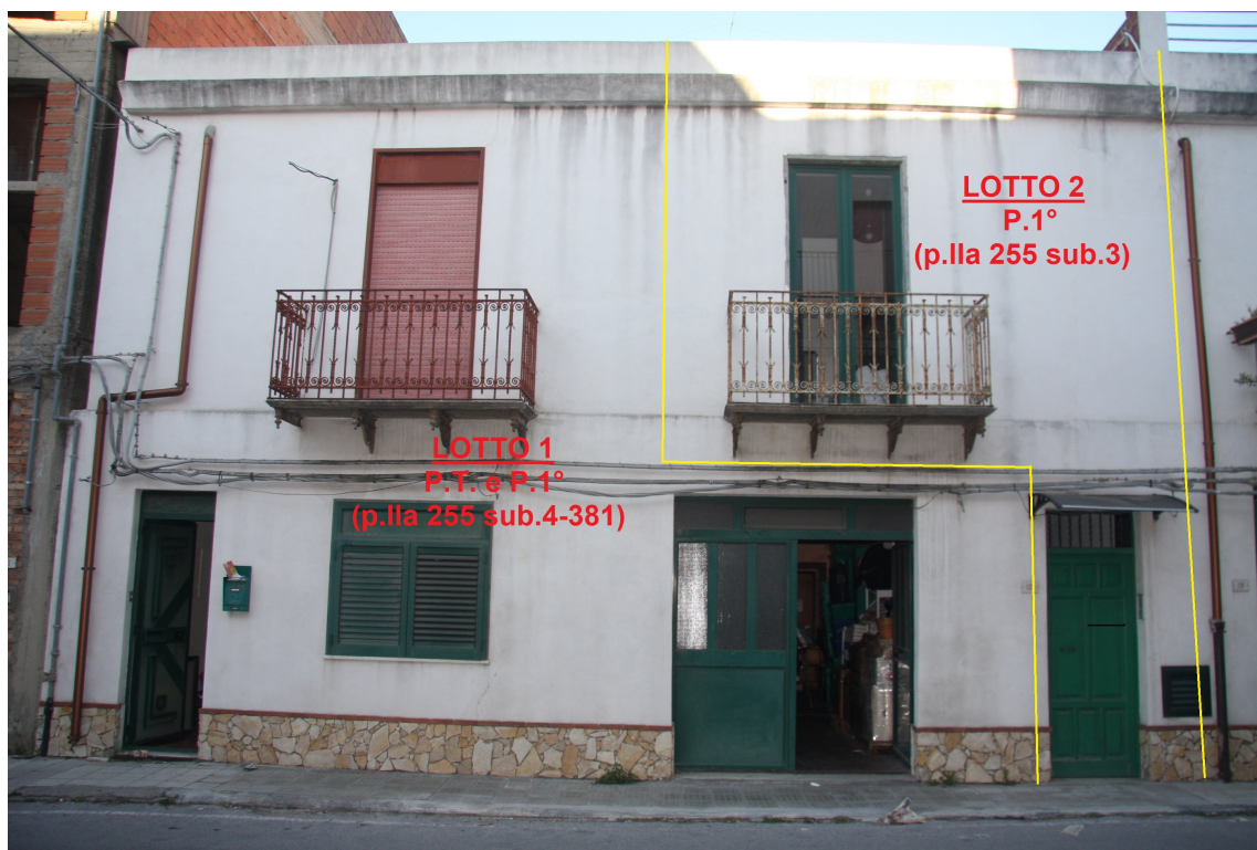
Foto n.1: Vista prospettica del fabbricato con individuazione dei 2 lotti.
