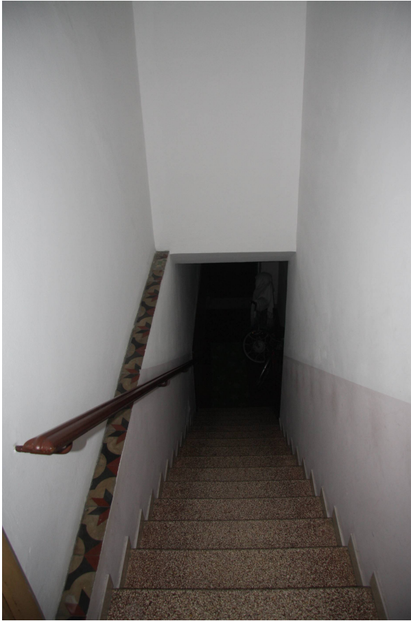
Foto n. 6: Rampa di scale di accesso all'abitazione.
