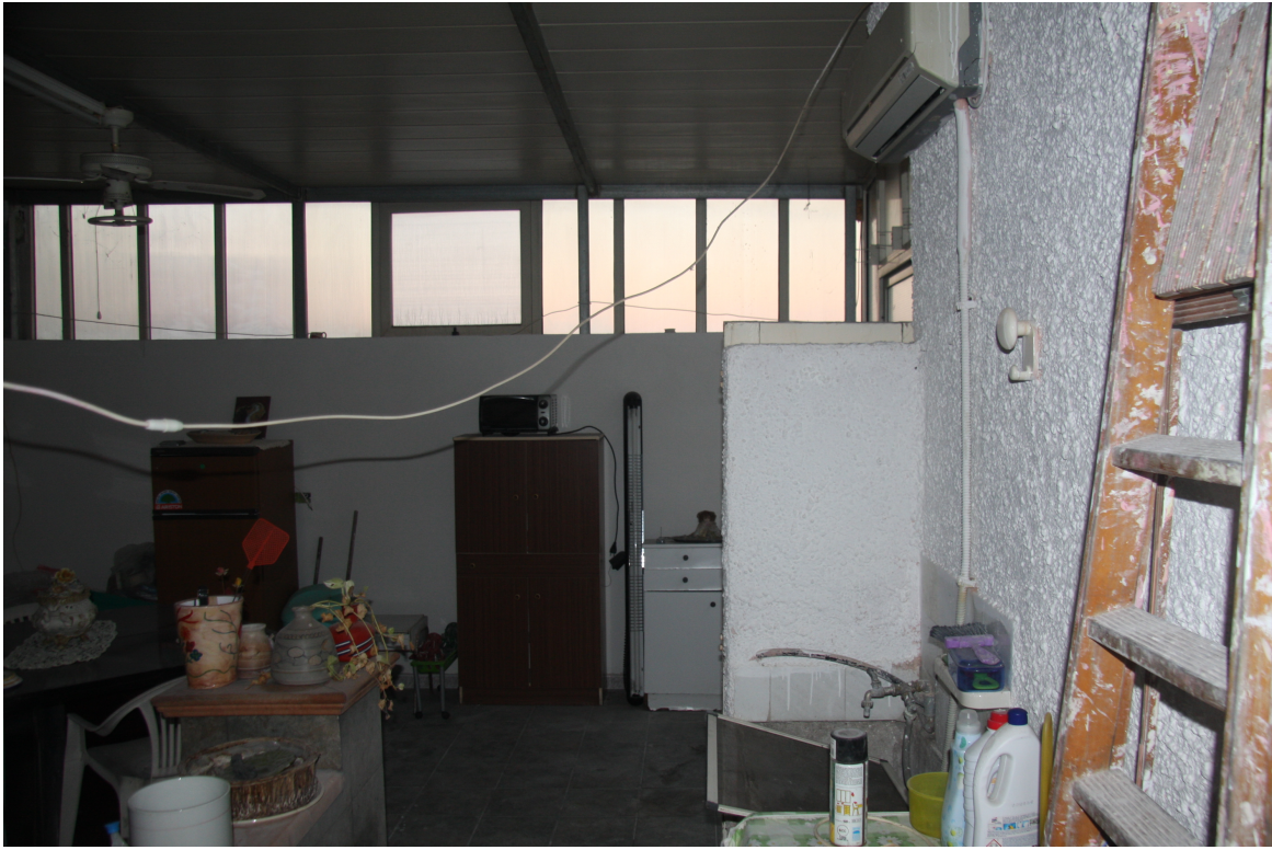
Foto n. 16: Vista interna al terrazzo. Particolare copertura.
