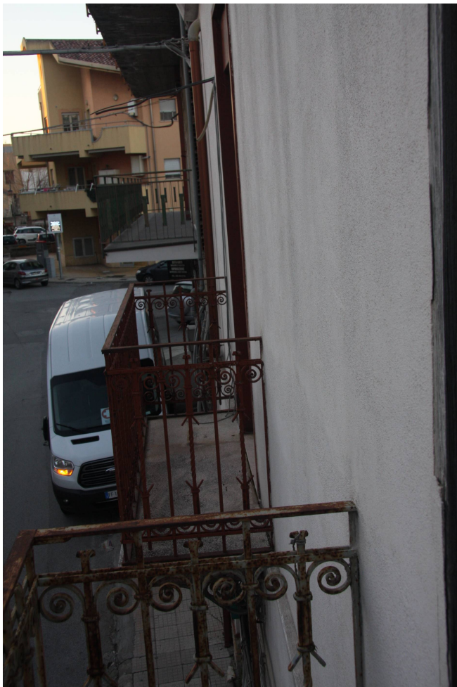
Foto n. 11: Vista esterna al balcone.
