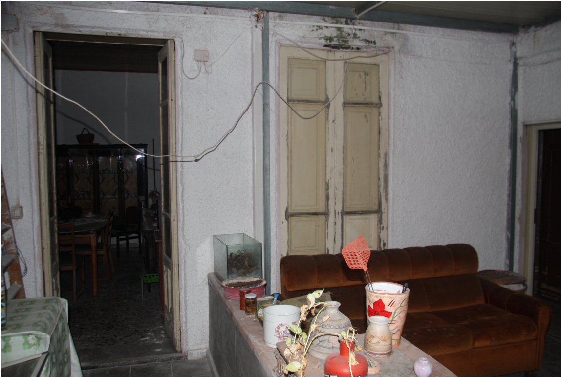
Foto n.2: Vista dal terrazzo coperto, con particolare muretto divisorio i due lotti 1-2
