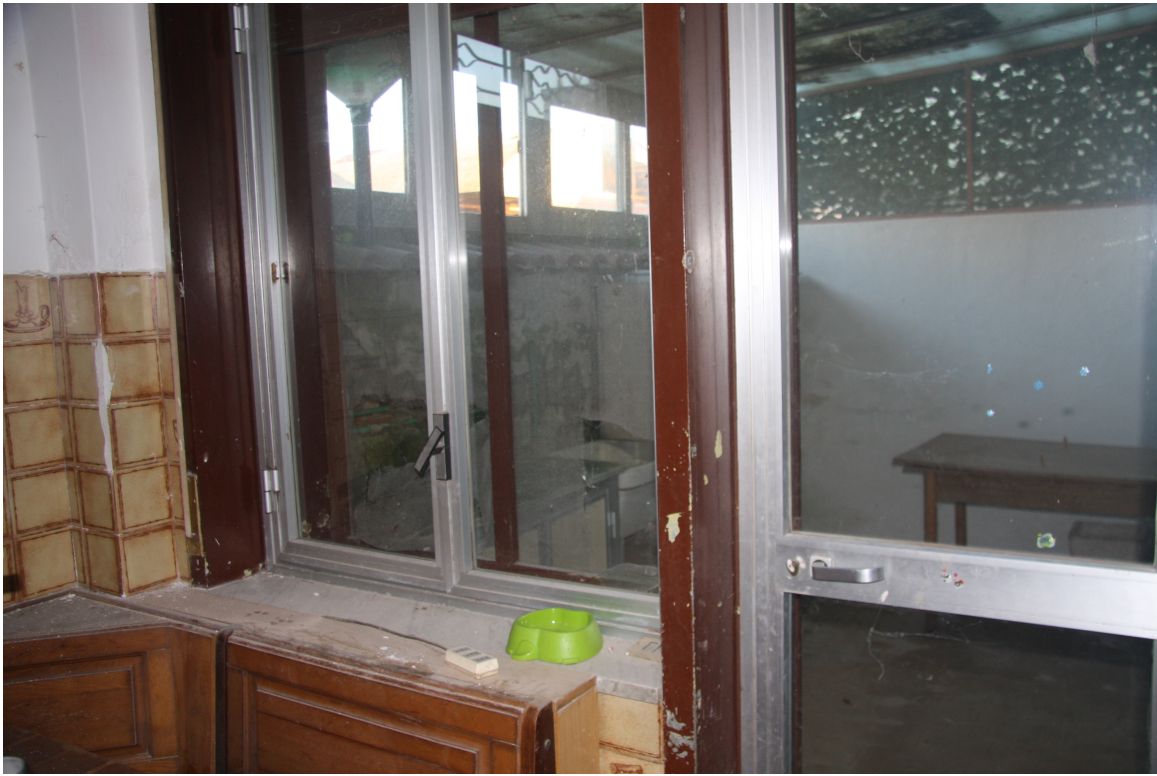
Foto n. 14: Particolare infissi in alluminio.
