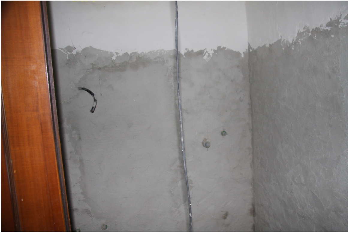
Foto n. 8: Particolare interno vano Wc (in fase di ristrutturazione).
