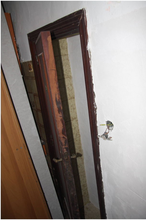
Foto n. 10: Particolare chiusura porta con muratura.
