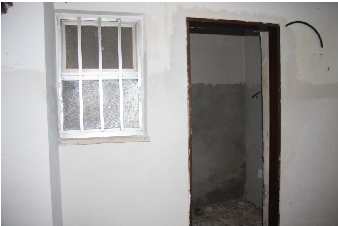
Foto n. 9: Vista prospettica esterna vano Wc.
