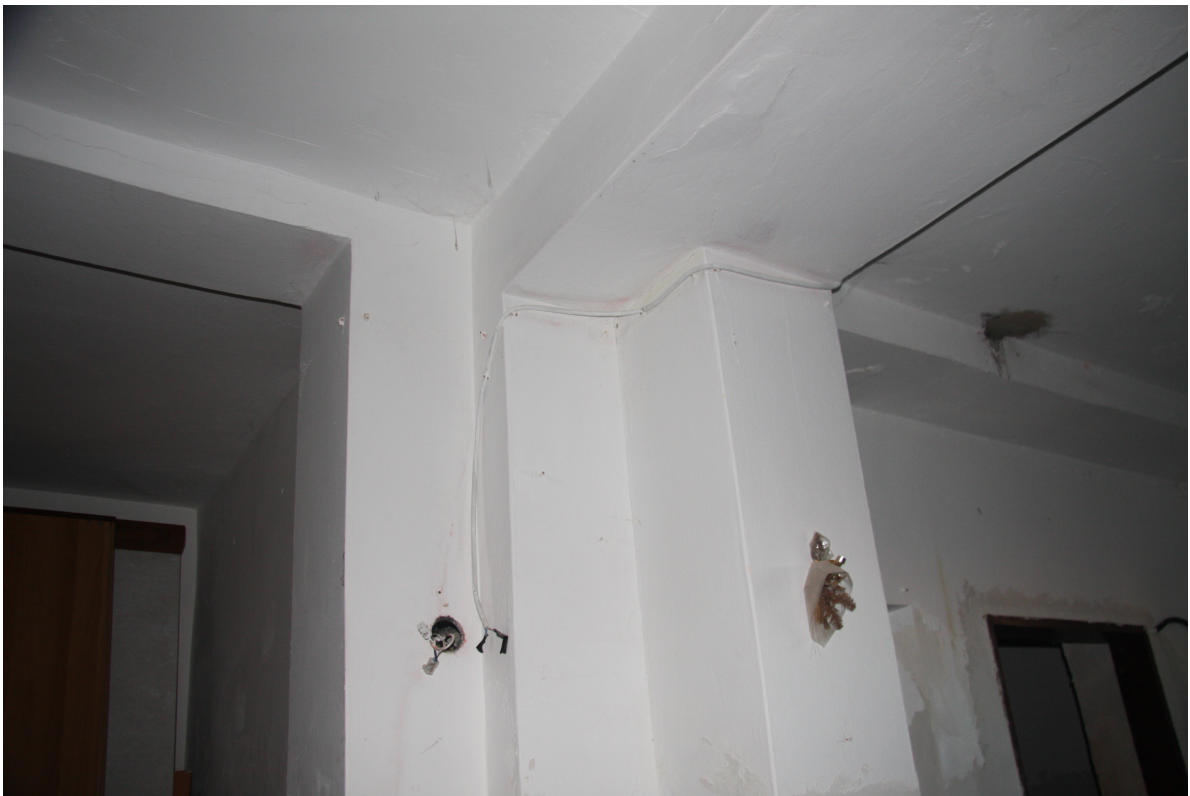
Foto n. 15: Particolare strutturale del fabbricato. Nodo trave-pilastro.
