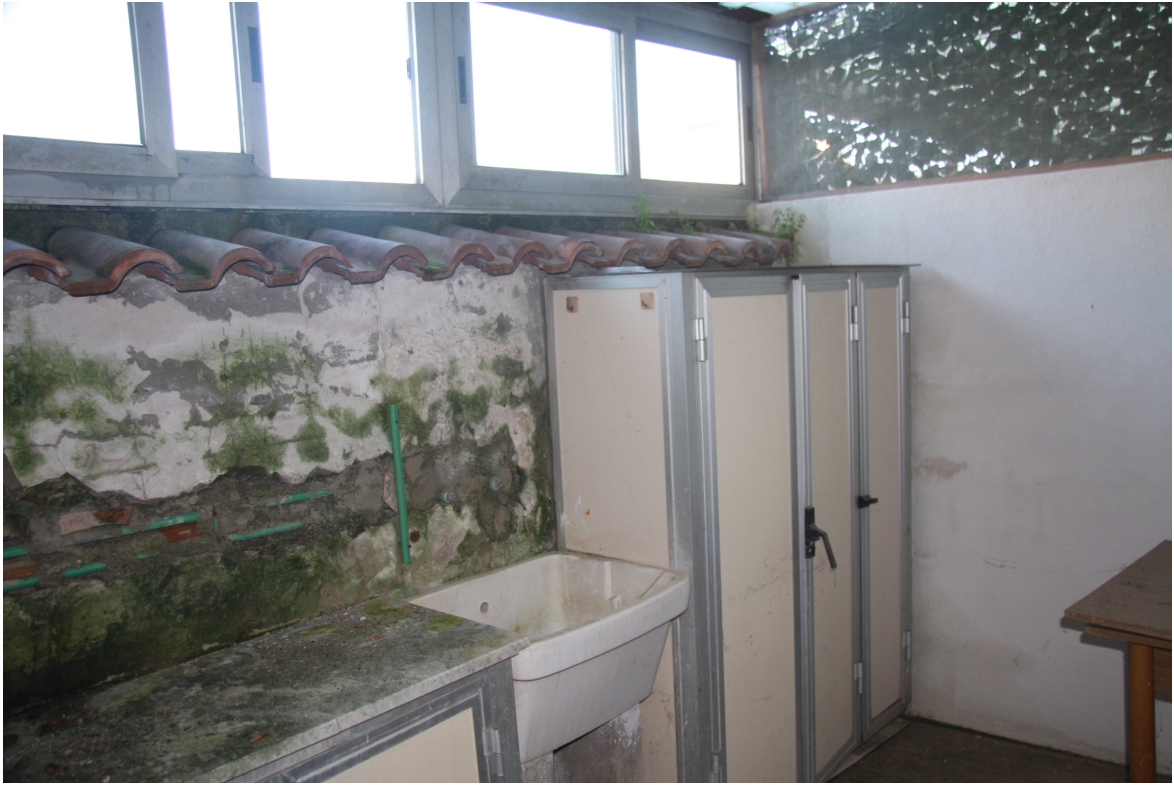
Foto n. 12: Vista interna. Particolare cortiletto con copertura
