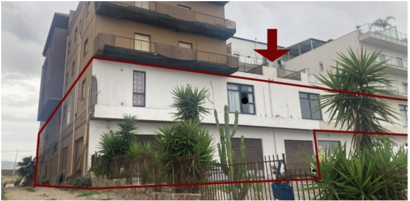
Ingresso su Strada Provinciale 15C
