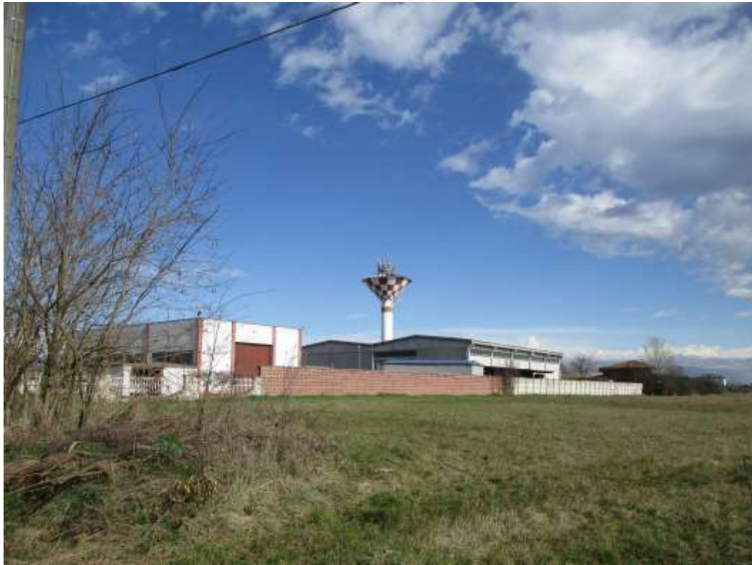
Vista da Str. Vecchia di Novi verso Nord
