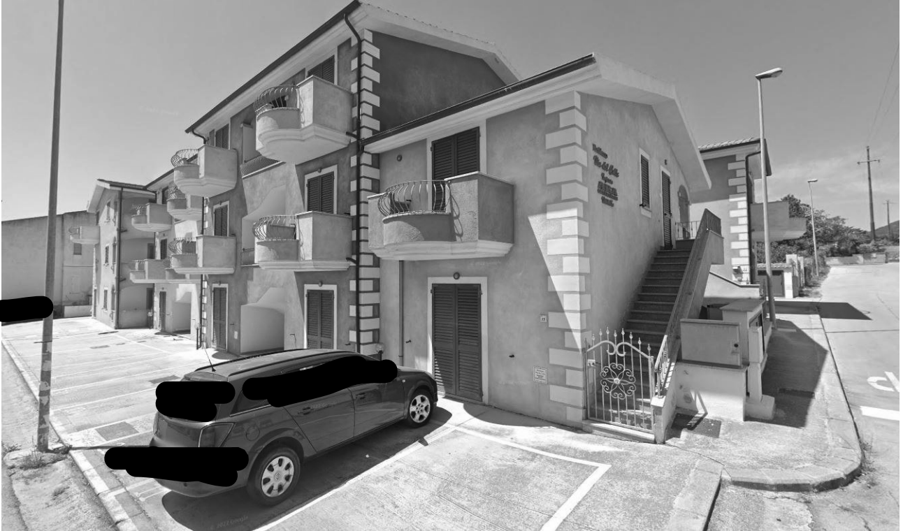
Foto n° 1 – Vista d'insieme prospetto principale –
