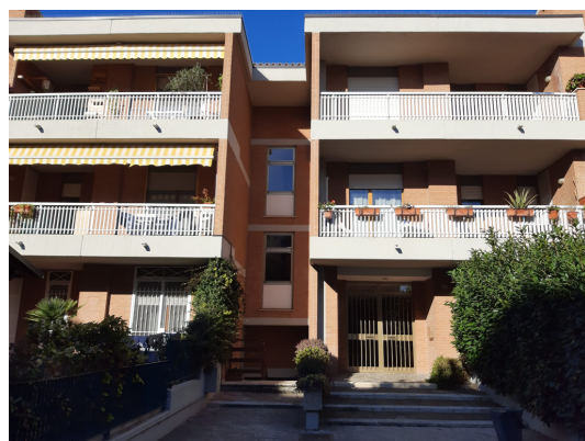
Ingresso Palazzina A3-P 1 a sinistra
