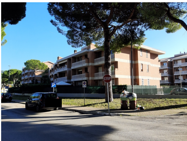
Foto 1: palazzina A3 capofila dello steccone di edifici a schiera.
