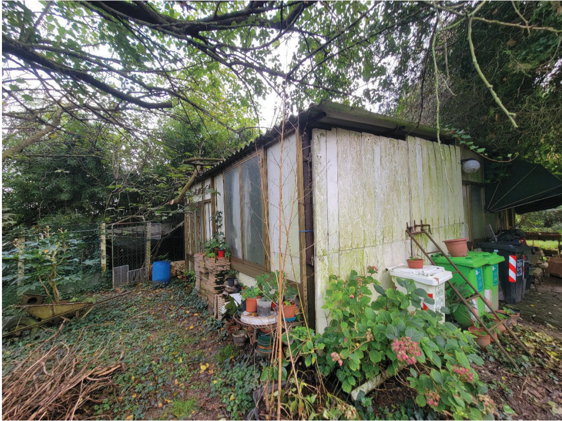
47 Pertinenza parte del mappale 91/2 situata al confine est da rimuovere
