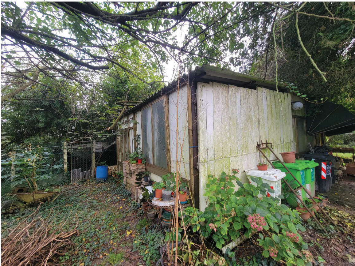
48 Pertinenza parte del mappale 91/2 situata al confine est da rimuovere
