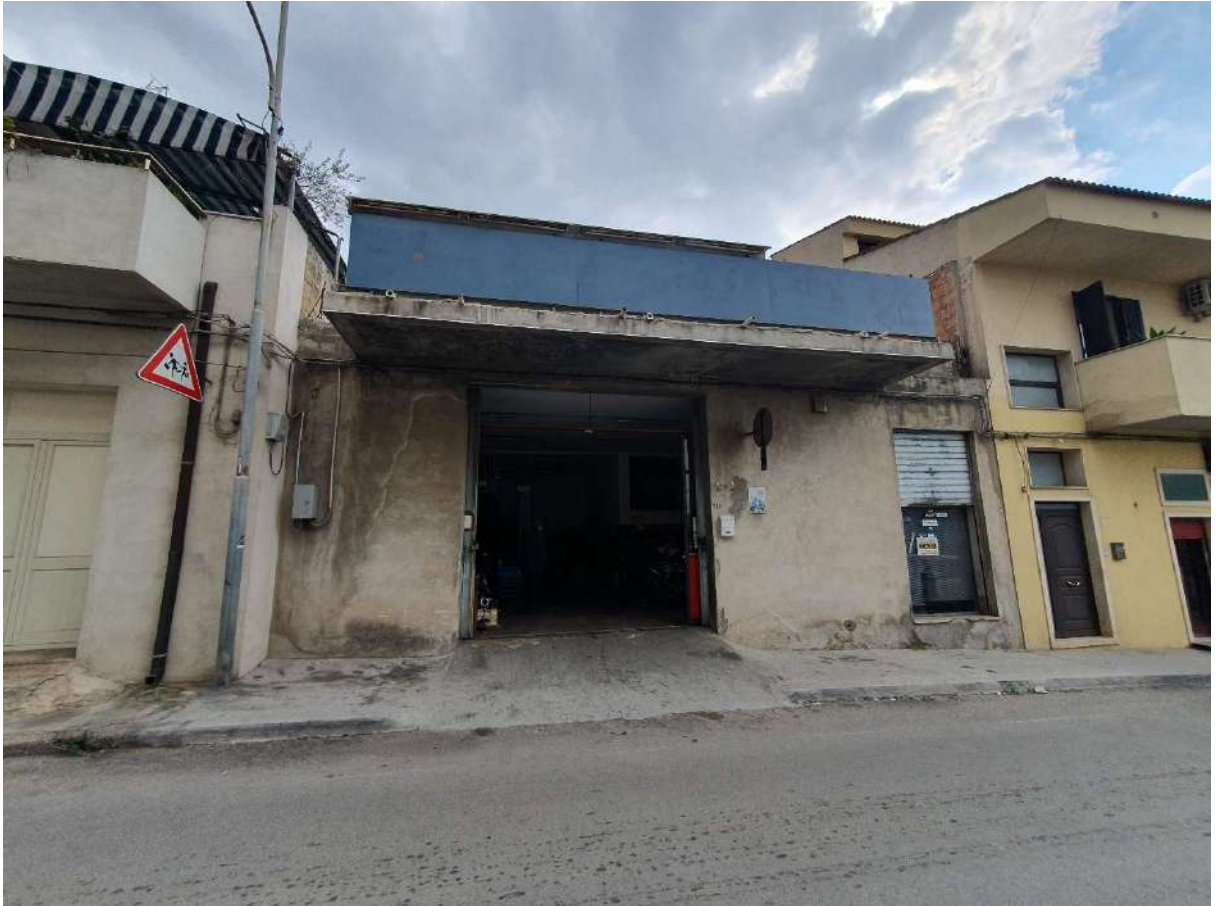
Prospetto su via Manzoni
