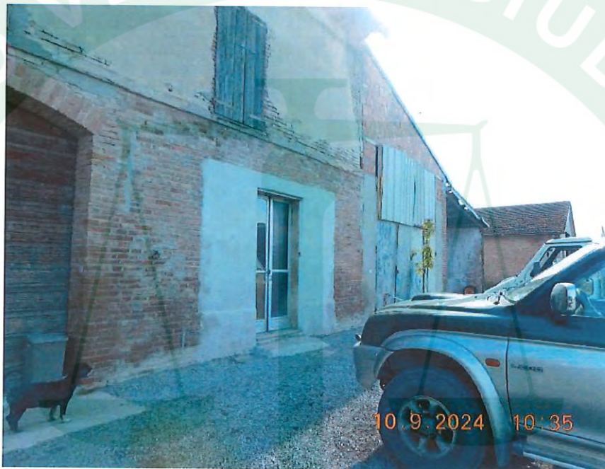
Vista accessi sub 2
