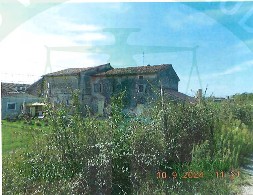
Vista della porzione sub 1 da Strada Argine Rigosa Vecchia
