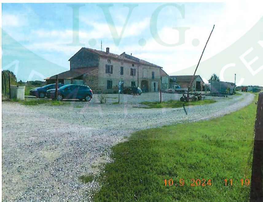
Veduta di insieme del complesso immobiliare da nord ovest (strada Argine Rigosa Vecchia)
