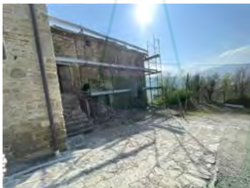
vista laterale fronte sud-ovest
