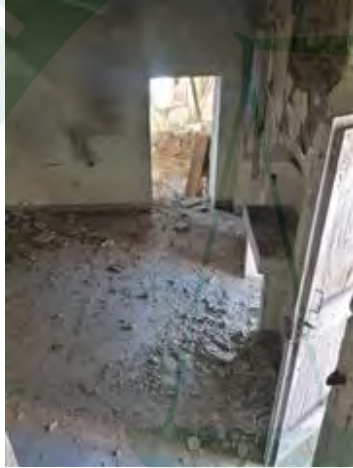
piano primo - ingresso cucina vista verso porta soggiorno
