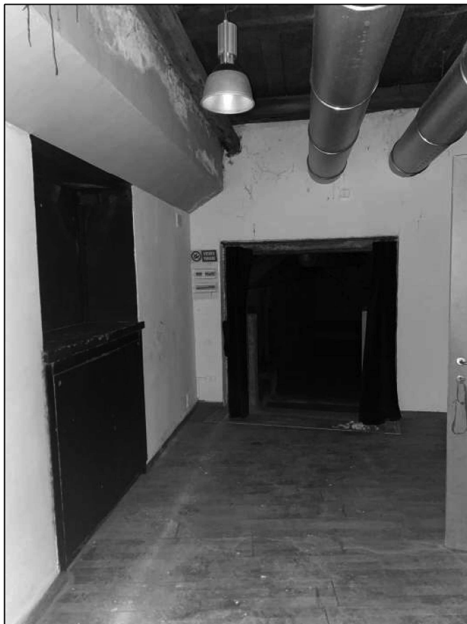
Foto 9 - Lotto unico - Sopralluogo del 03/11/2022
