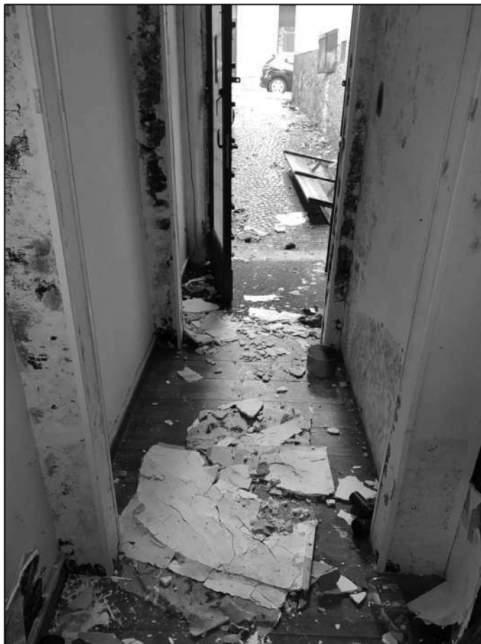
Foto 11 - Lotto unico - Sopralluogo del 03/11/2022
