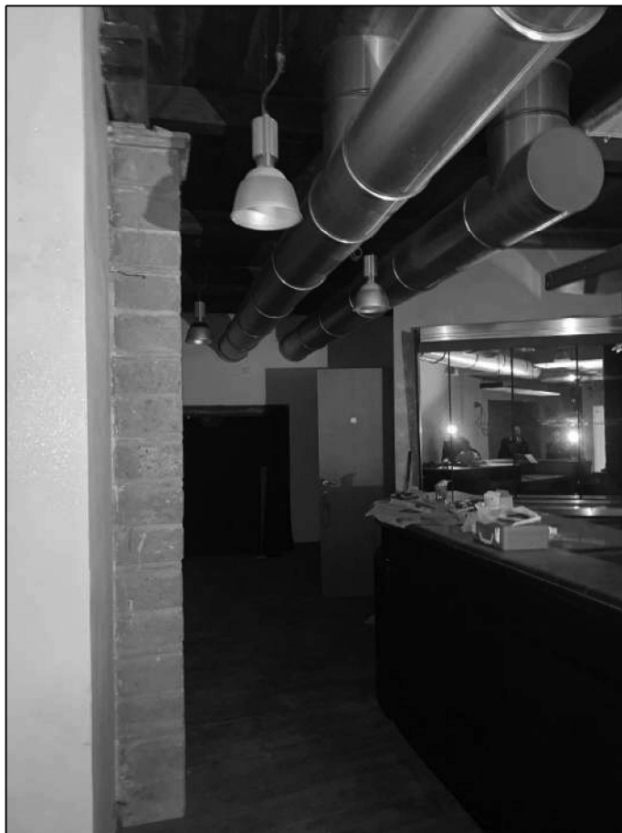
Foto 5 - Lotto unico - Sopralluogo del 03/11/2022
