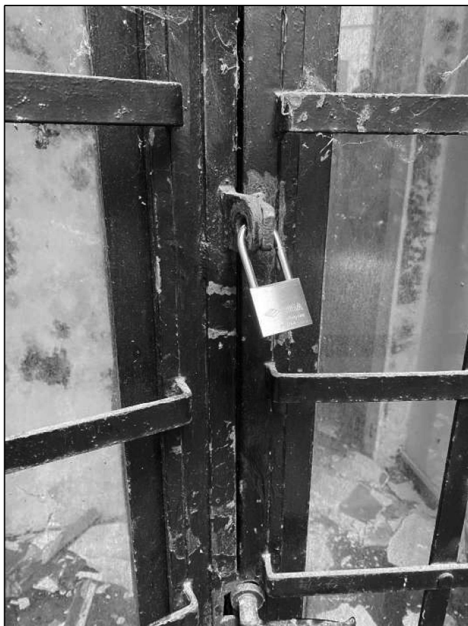
Foto 14 - Lotto unico - Sopralluogo del 03/11/2022
