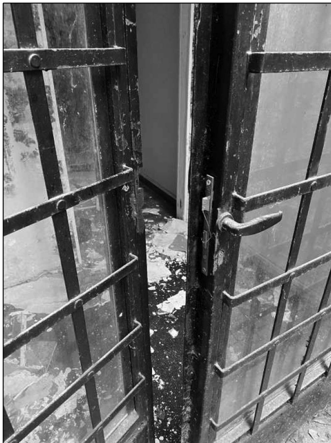
Foto 3 - Lotto unico - Sopralluogo del 03/11/2022
