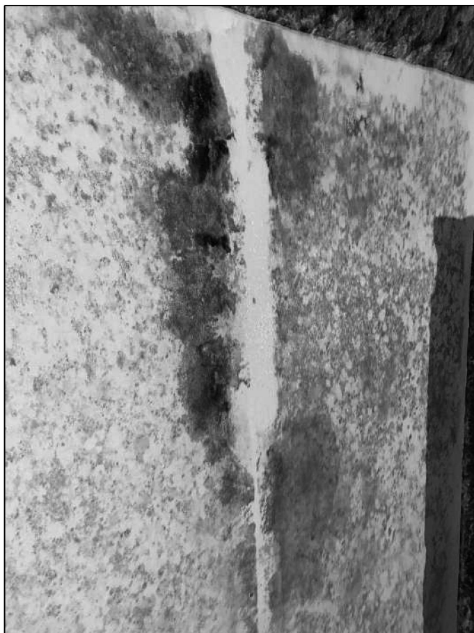
Foto 8 - Lotto unico - Sopralluogo del 03/11/2022
