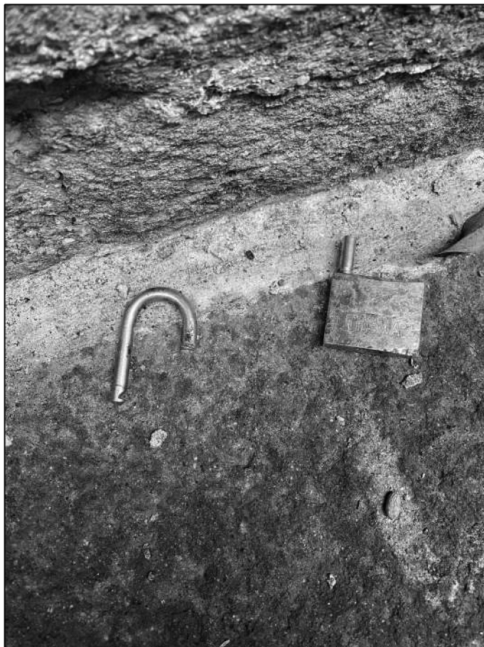
Foto 13 - Lotto unico - Sopralluogo del 03/11/2022
