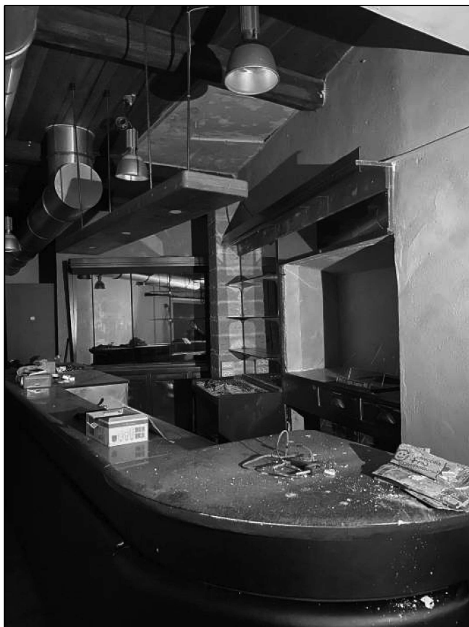
Foto 4 - Lotto unico - Sopralluogo del 03/11/2022
