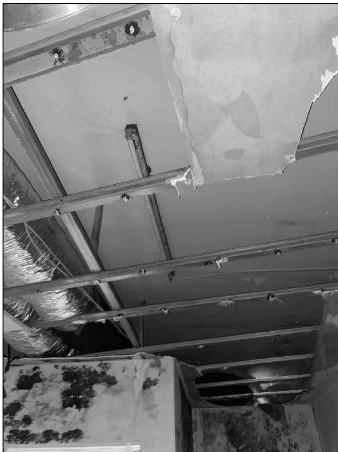
Foto 12 - Lotto unico - Sopralluogo del 03/11/2022
