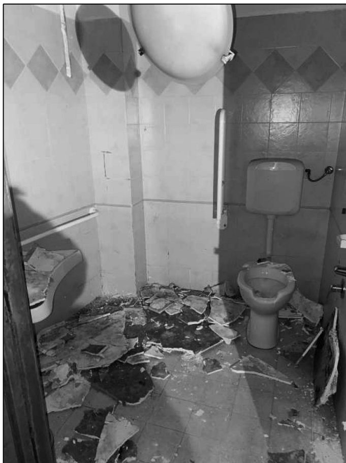
Foto 6 - Lotto unico - Sopralluogo del 03/11/2022
