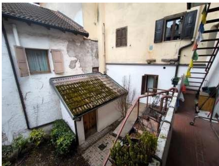
Vista su corte con ripostiglio al P.T.
