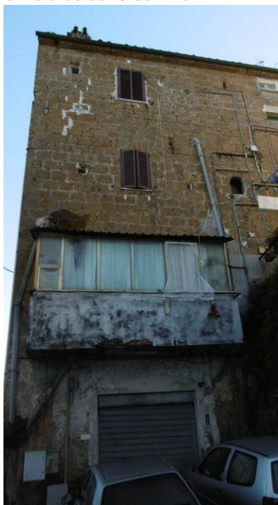
Accesso garage e vista balcone con wc
