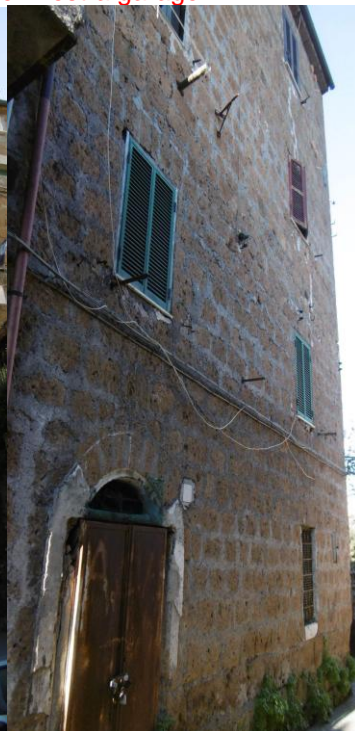
Accesso magazzino e finestra garage
