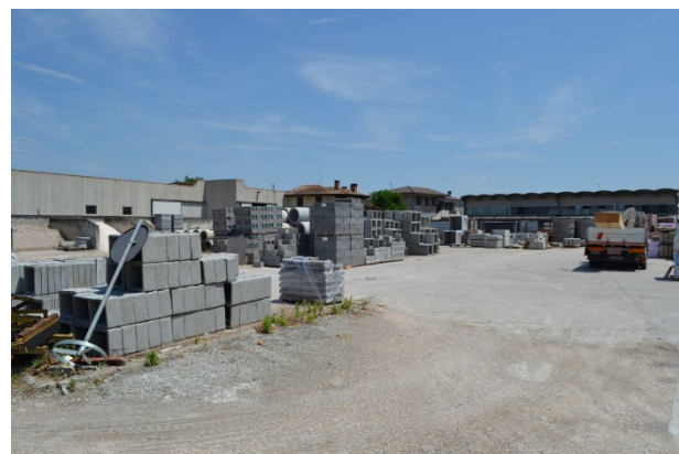
foto 11 – m.n. 428 (area urbana) - L'ente urbano pignorato, a nord del lotto, si presenta adoperato per lo stoccaggio di tipici materiali d'uso edili.
