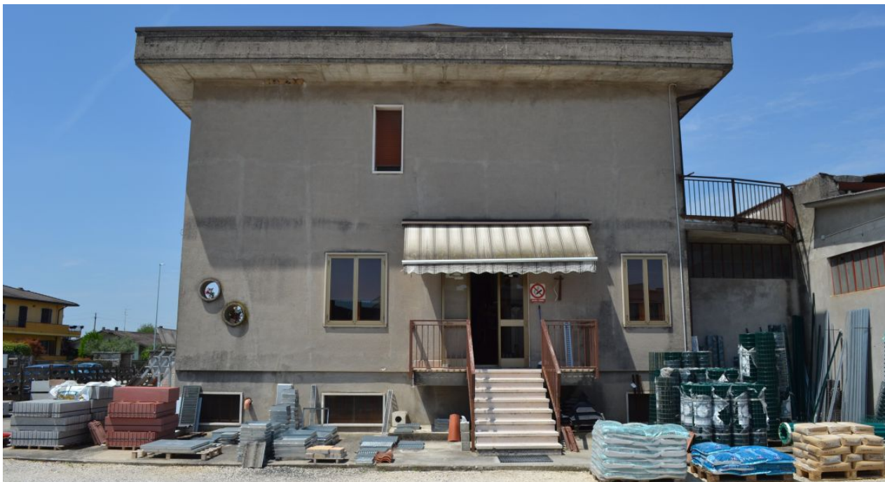
foto 3 – m.n. 93 (visto da est dalla corte interna sub 9) – Il fabbricato non è tinteggiato, se non in minima parte (vedi successiva foto n. 9). Agli uffici si accede da due ingressi diretti, uno rivolto verso la pubblica via e l'altro – praticamente al centro di questa foto – praticabile dalle pertinenze esterne. Alla taverna, oltre che dal vano scale interno, si accede da un cavedio in comune con la C.T. (vedi successiva foto n. 6).
