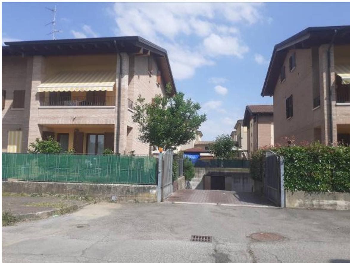
19. Esterno: accesso alla rampa di discesa verso l'autorimessa e agli spazi di manovra comuni
