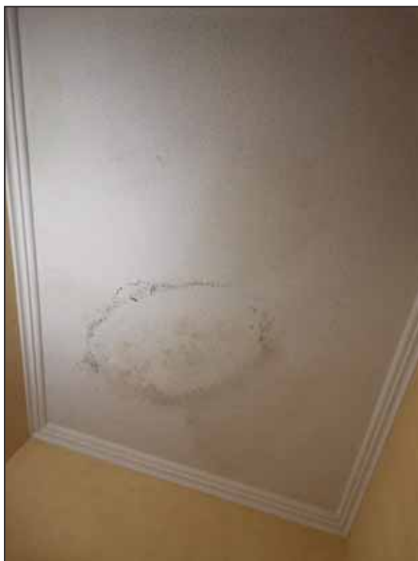
FOTO 54 - Piano primo – Ripostiglio 2.
