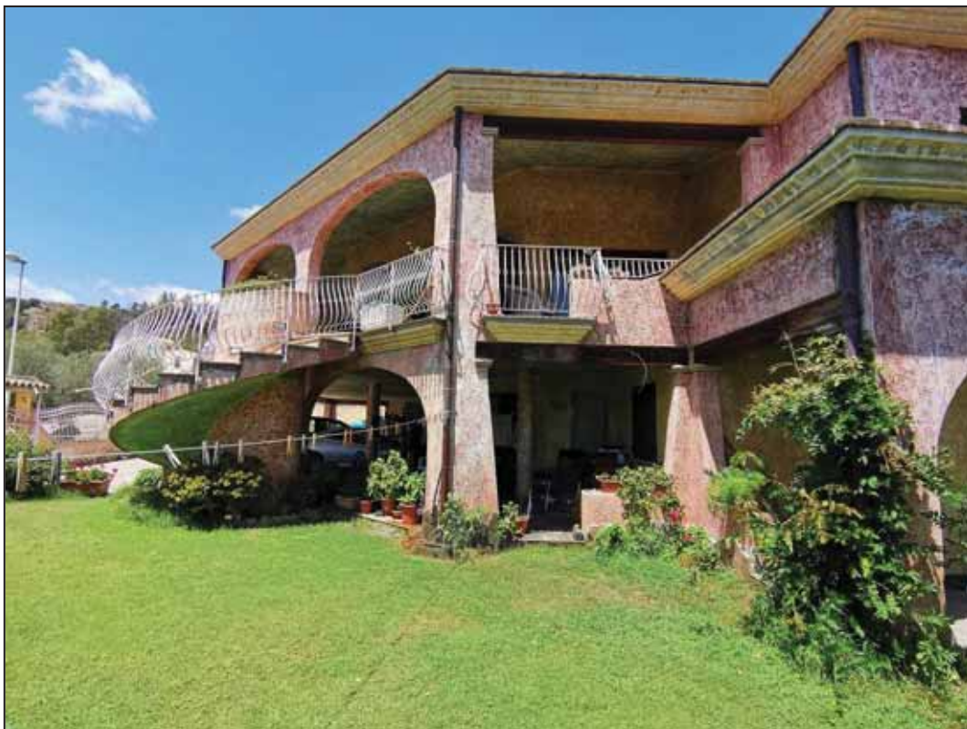
FOTO 3 - Vista dal cortile.
