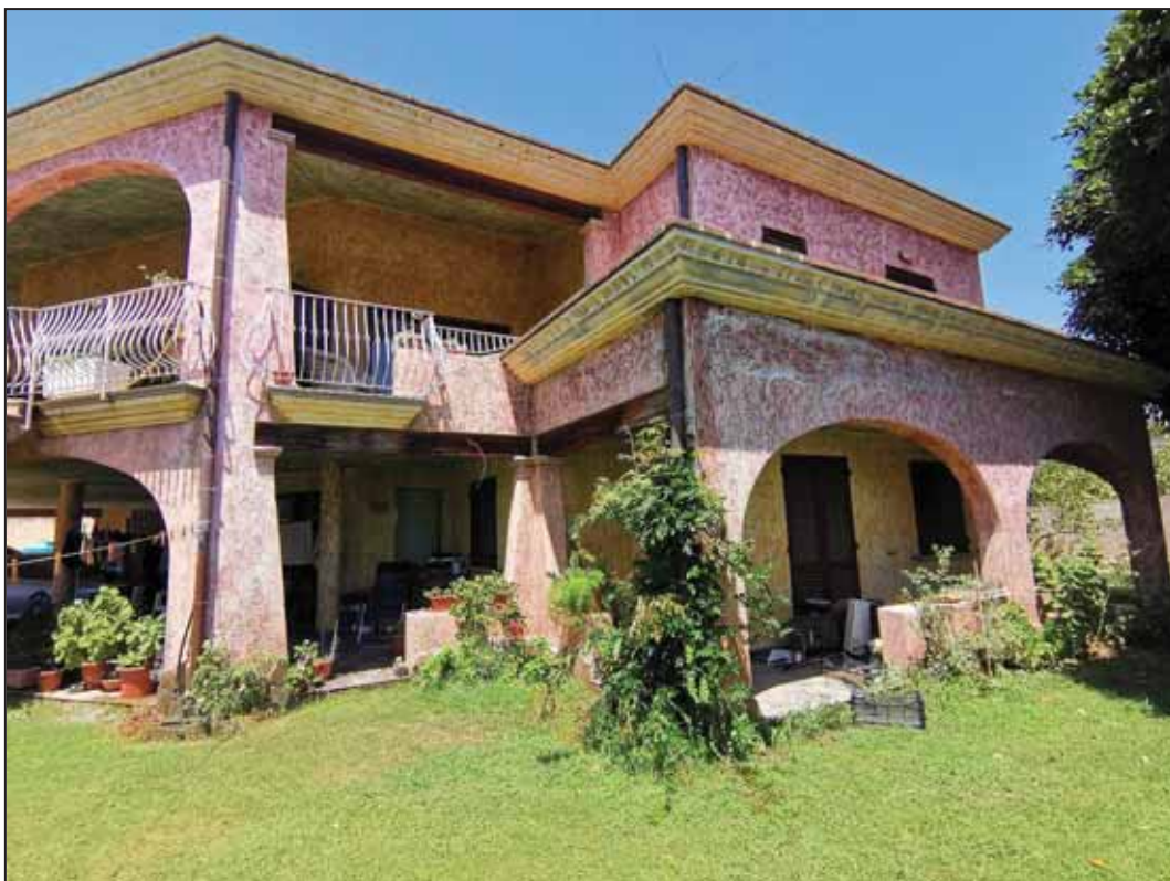
FOTO 4 - Vista dal cortile.
