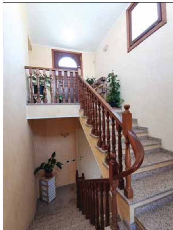
FOTO 14 – Piano secondo/primo – Vano scala.
