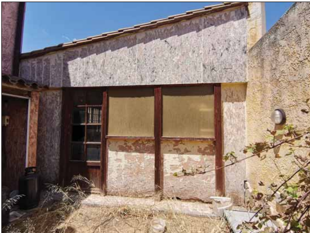
FOTO 6 – Piano Terra - Sgombero.
