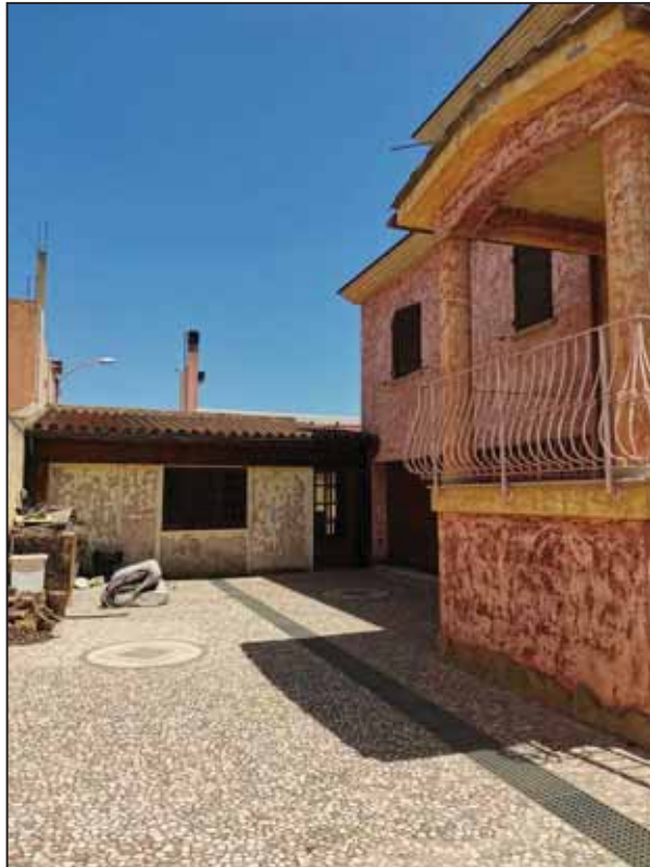
FOTO 7 - Vista dal cortile.
