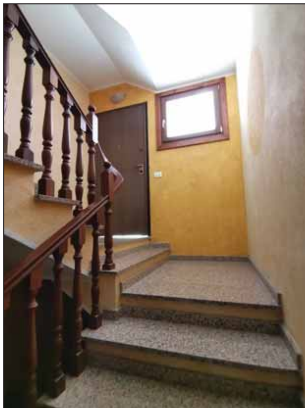
FOTO 16 – Piano terra – Vano scala.
