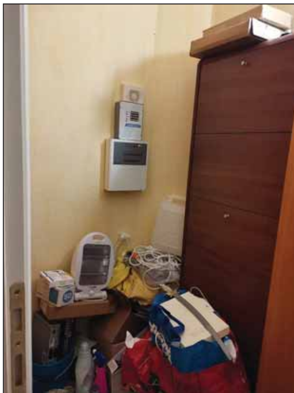
FOTO 53 – Piano primo – Ripostiglio 2.
