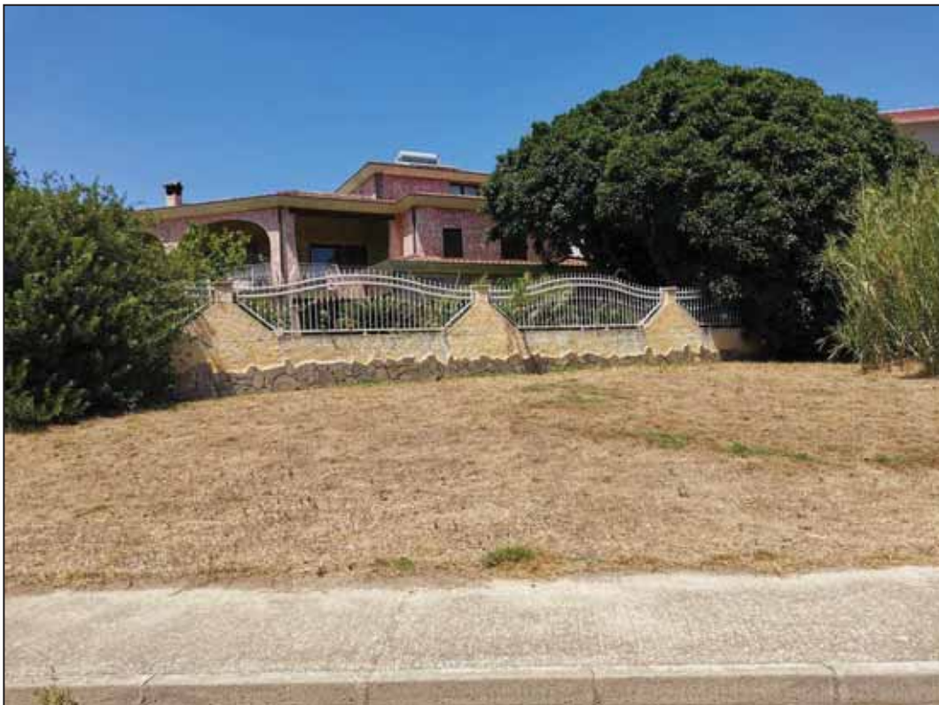
FOTO 2 - Vista da Via Ariosto.
