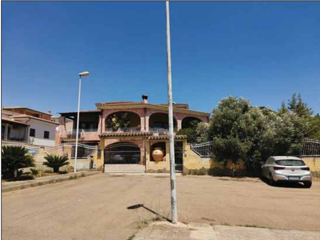
FOTO 1 - Vista da Via Ariosto.
