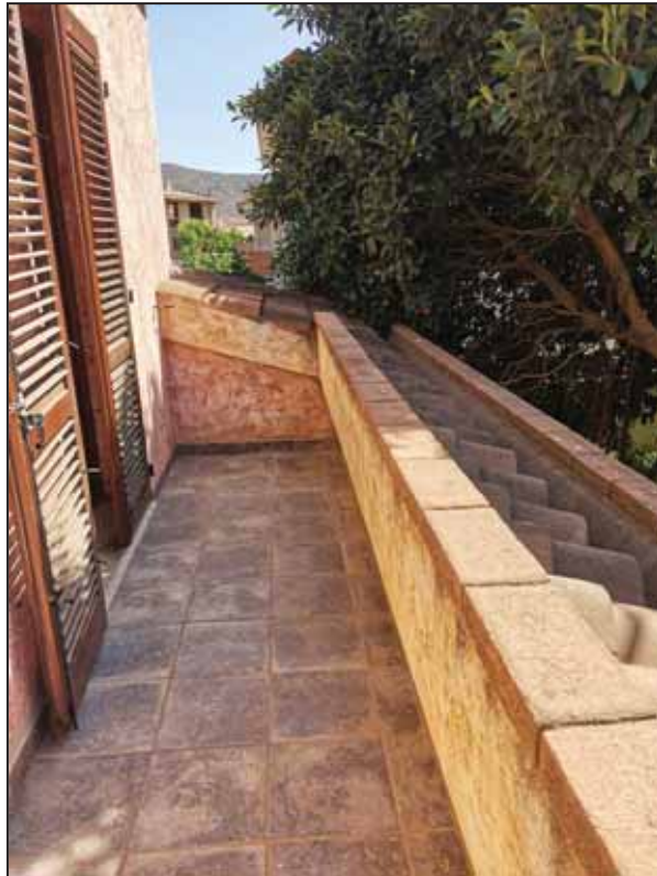
FOTO 43 – Piano primo – Balcone.
