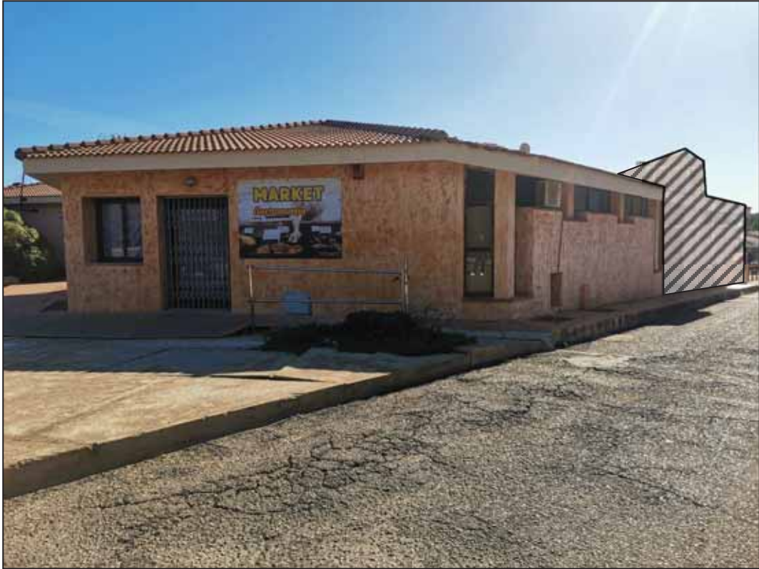
FOTO 1 - Vista da Via degli Anemoni.
