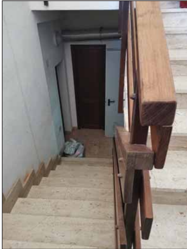
FOTO 13 - Vano scala comune.
