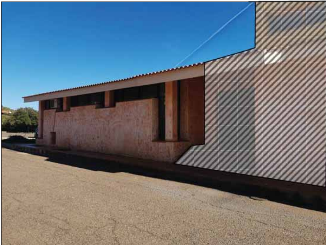
FOTO 2 - Vista da Via degli Anemoni.
