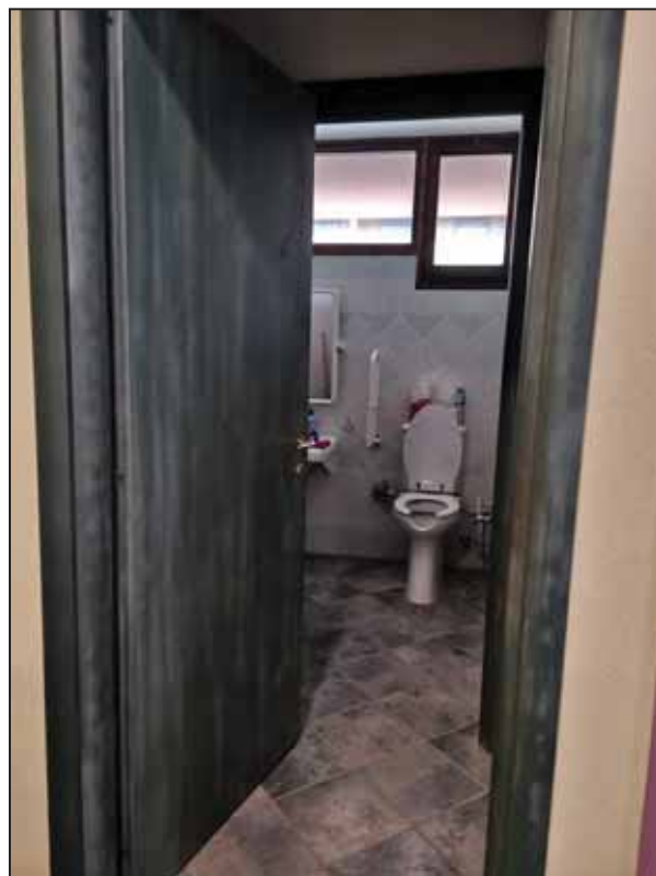
FOTO 10 – Anti bagno e WC.
