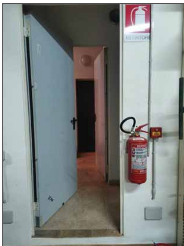
FOTO 12 - Vano scala comune.
