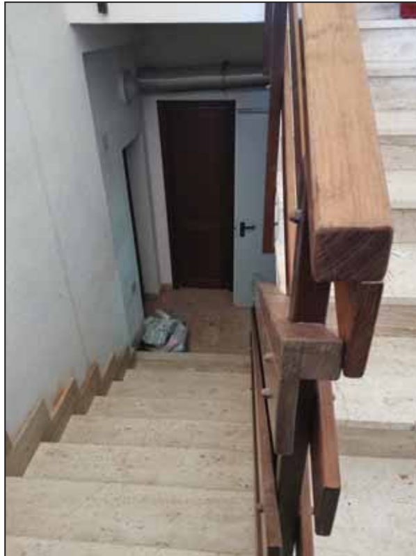
FOTO 17 - Vano scala comune.
