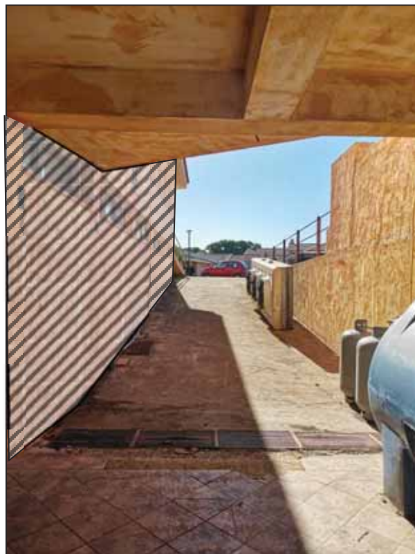
FOTO 2 – Accesso al piano interrato.
