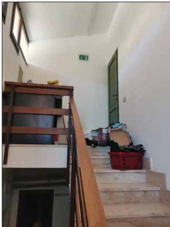
FOTO 18 – Vano scala comune.
