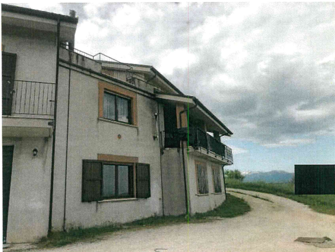
Figura 5: Retro ed accesso ai garage seminterrati
