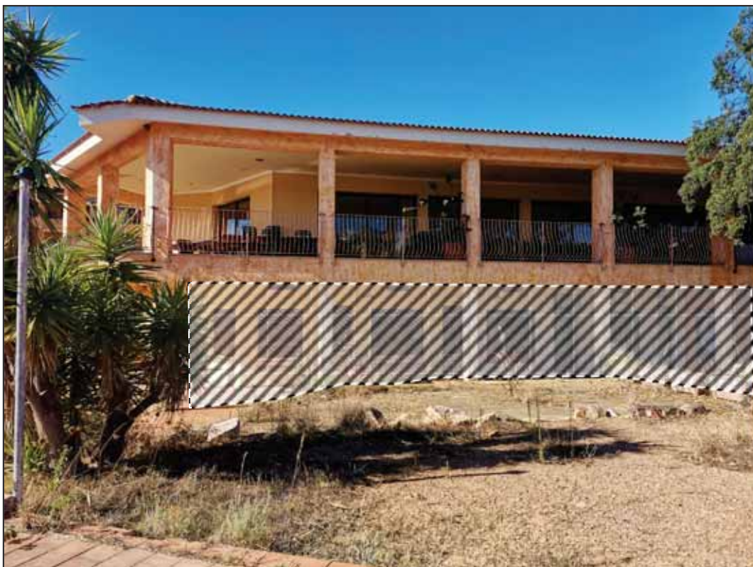
FOTO 6 - Vista dal cortile interno.
