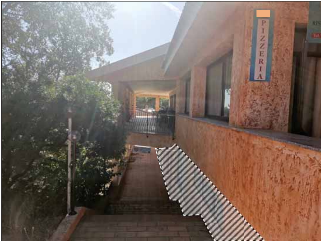
FOTO 5 - Vista dal cortile interno.
