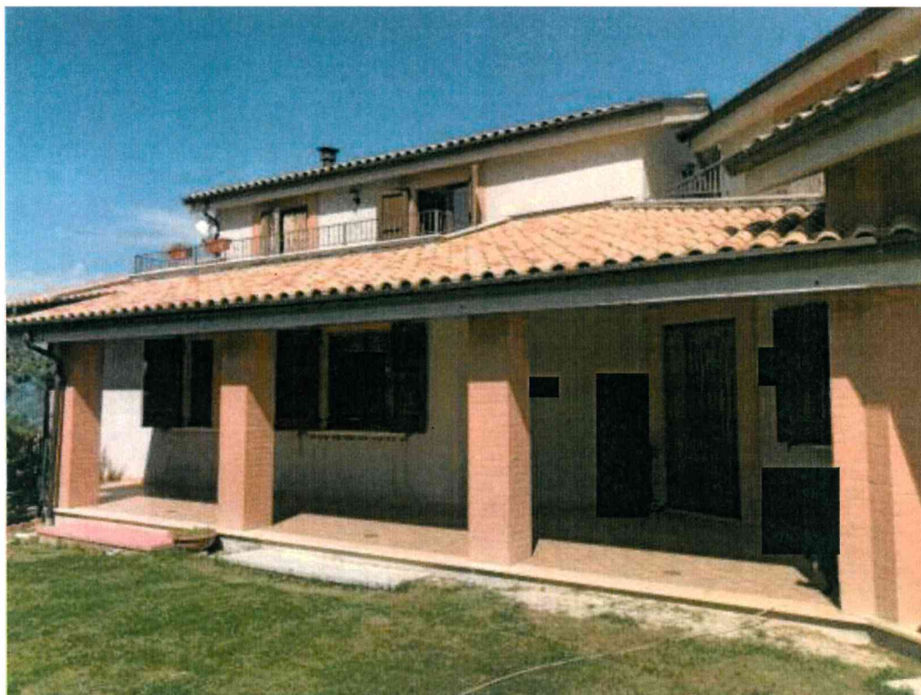
Figura 7: Ingresso al lotto 1 dalla corte comune
