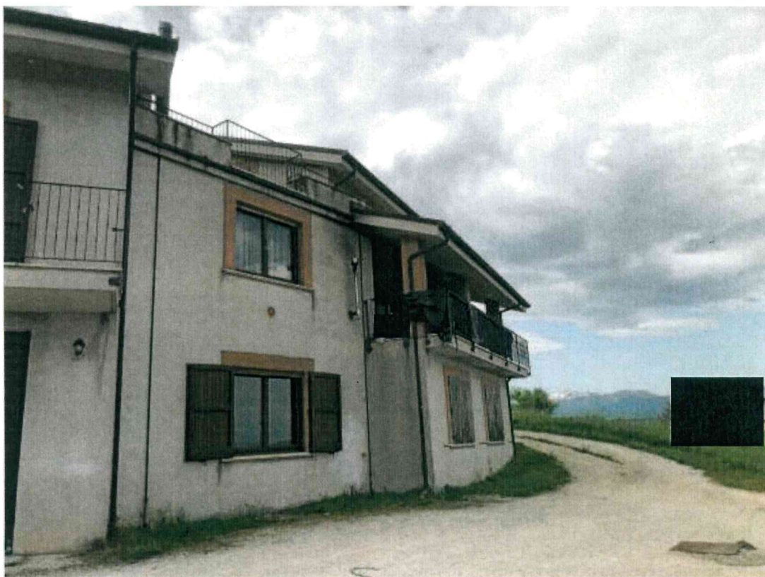
Figura 5: Retro ed accesso ai garage seminterrati
