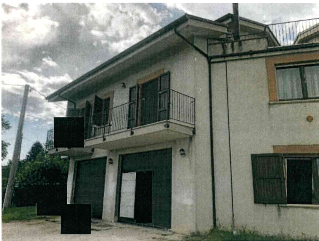
Figura 21: Ingresso al deposito lotto 1
