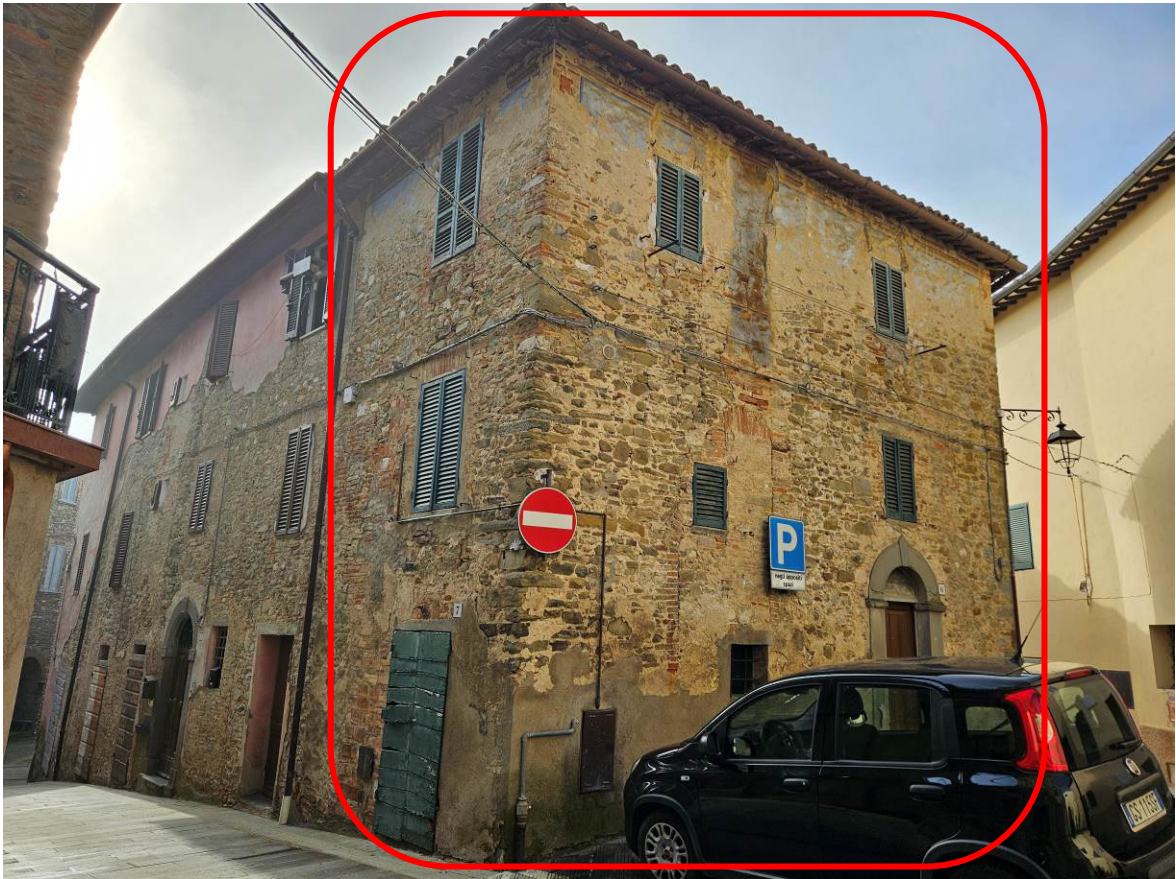
Foto n.3 – Prospetto sinistro (lato est)
