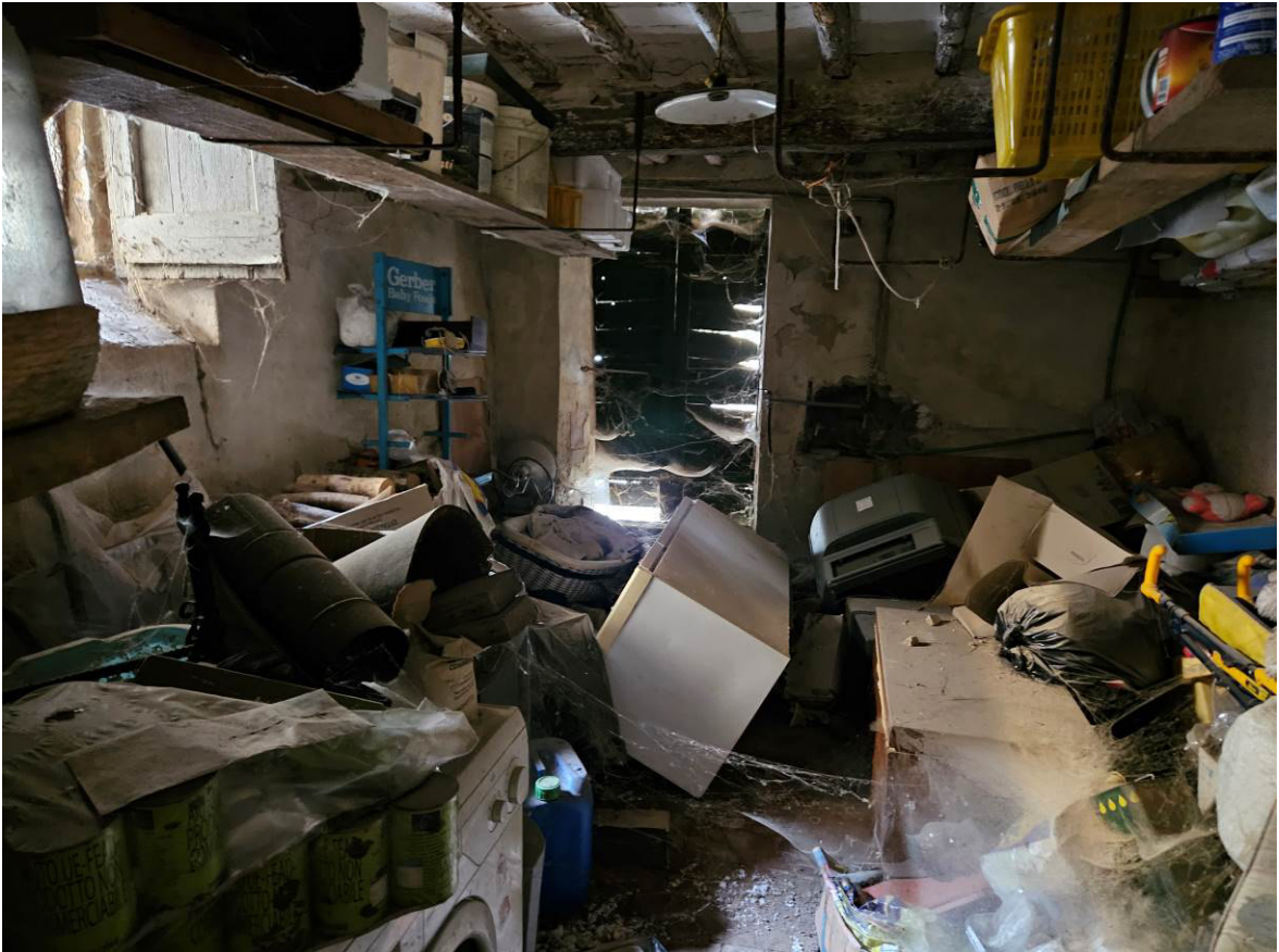
Foto n.6 – Piano terra - Magazzino (sub 11)
