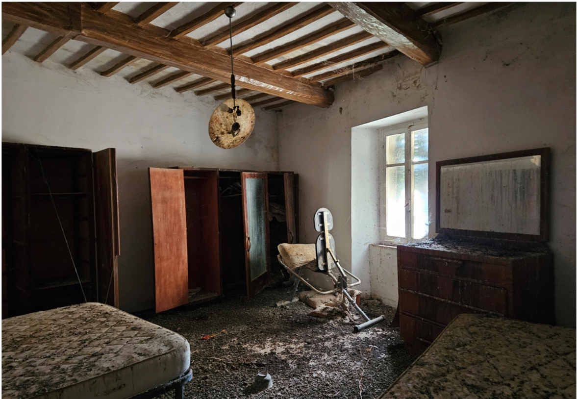
Foto n.11 – Piano secondo - Camera (sub 12)
