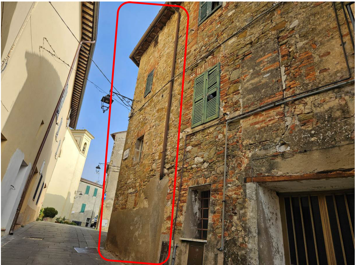
Foto n.4 – Prospetto destro (lato ovest)
