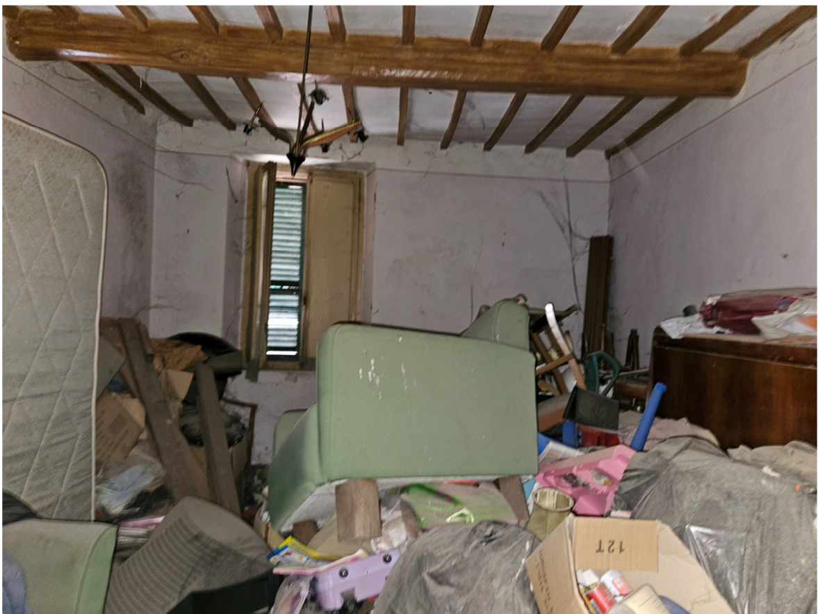
Foto n.12 – Piano secondo - Camera (sub 12)
