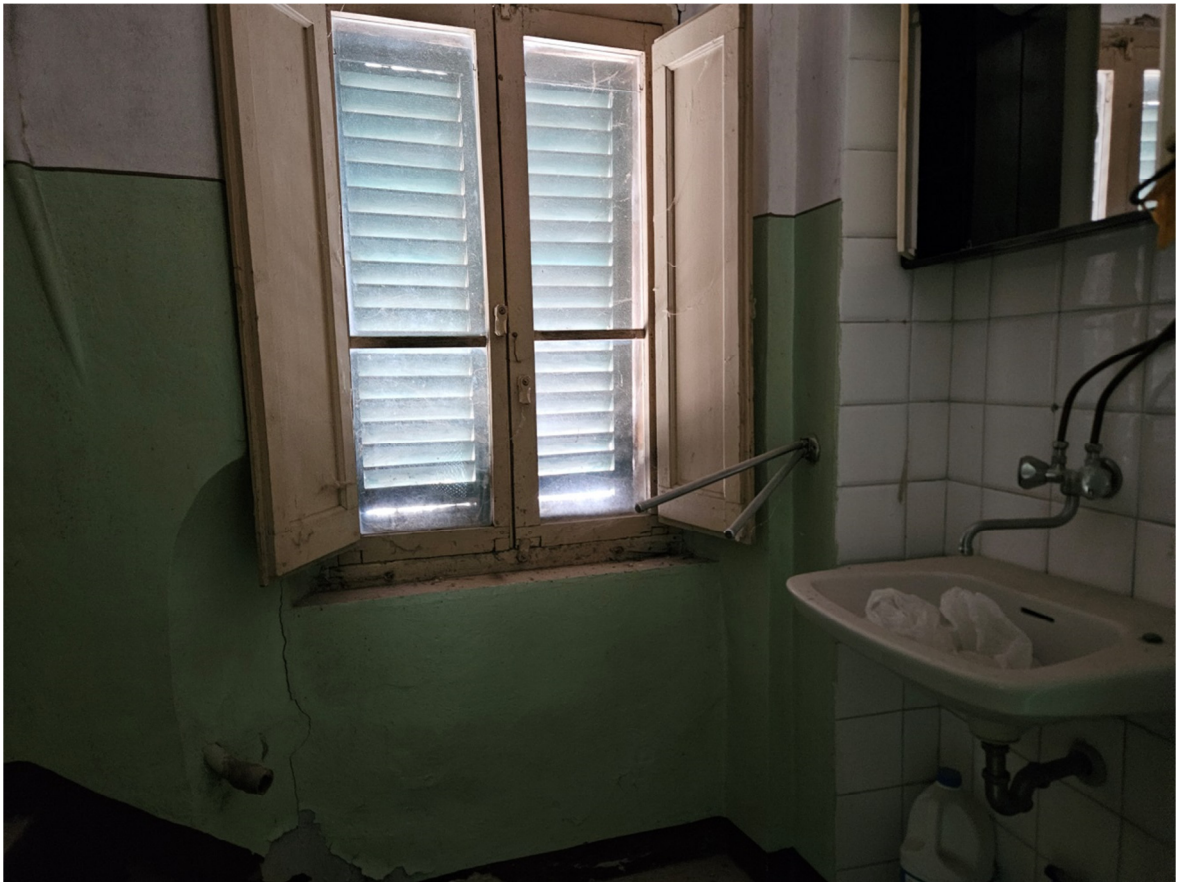
Foto n.13 – Piano secondo - Wc (sub 12)
