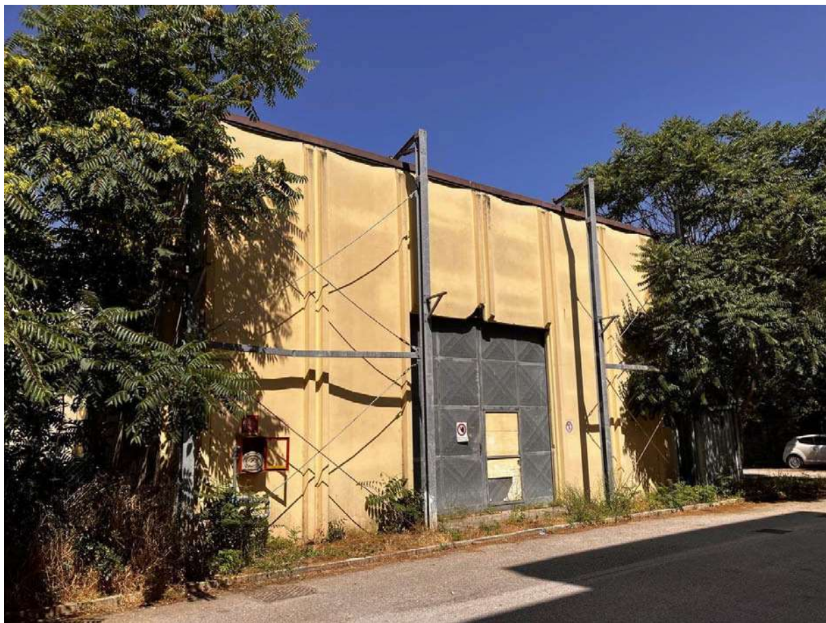
FOTO 04 - RETRO PROSPETTO RIPRESO DALL'ESTERNO DELLA PROPRIETA'
