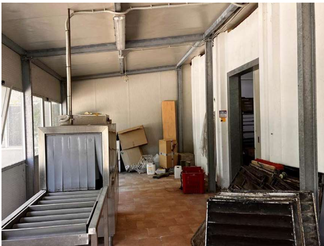
FOTO 12 - PIANO TERRA - CORPO AGGIUNTO ESTERNO IN STRUTTURA METALLICA - REPARTO LAVAGGIO CONT.
