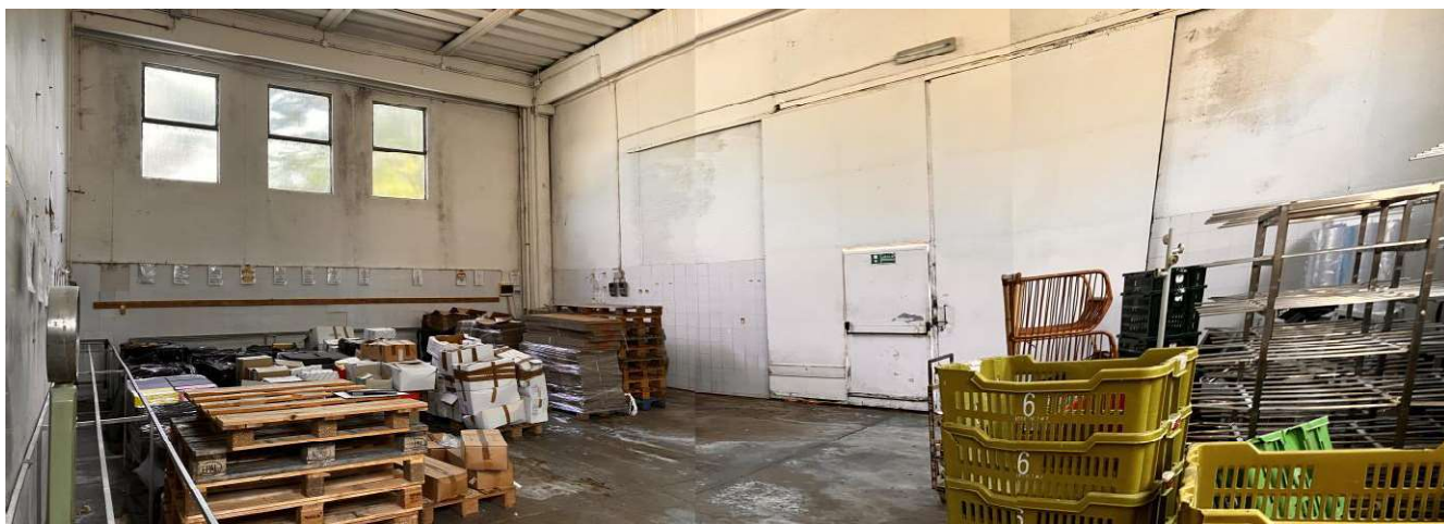
FOTO 11 - OPIFICIO PIANO TERRA - REPARTO CONFEZIONAMENTO E INGRESSO CARRABILE (V. FOTO RETRO PROSPETTO)
