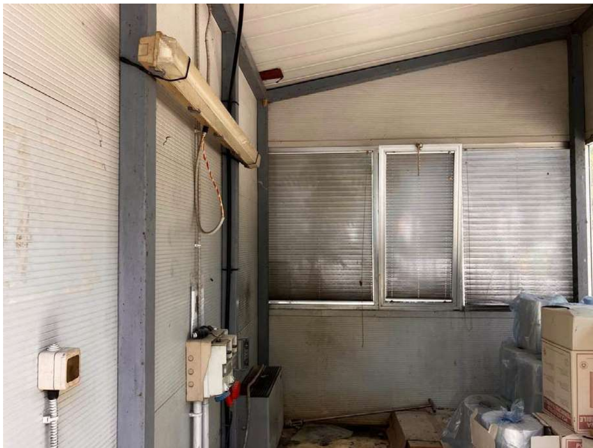
FOTO 13 - PIANO TERRA - CORPO AGGIUNTO ESTERNO IN STRUTTURA METALLICA – LOCALE PESA
