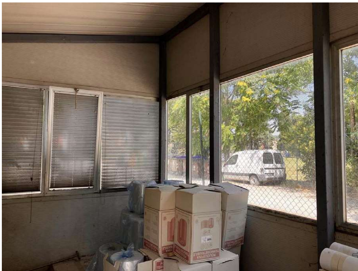
FOTO 14 - PIANO TERRA - CORPO AGGIUNTO ESTERNO IN STRUTTURA METALLICA – LOCALE PESA
