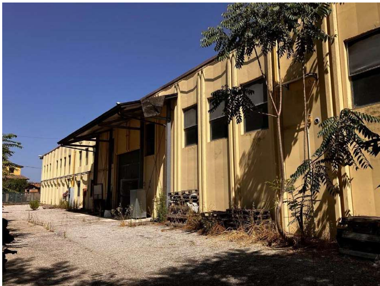
FOTO 05 - PROSPETTO PRINCIPALE RIPRESO DALLA CORTE ANNESSA
