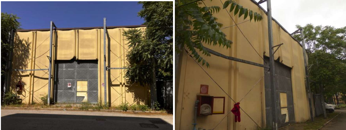
Foto 1 e 2 - Il retro del capannone con la struttura in acciaio sopra menzionata;
