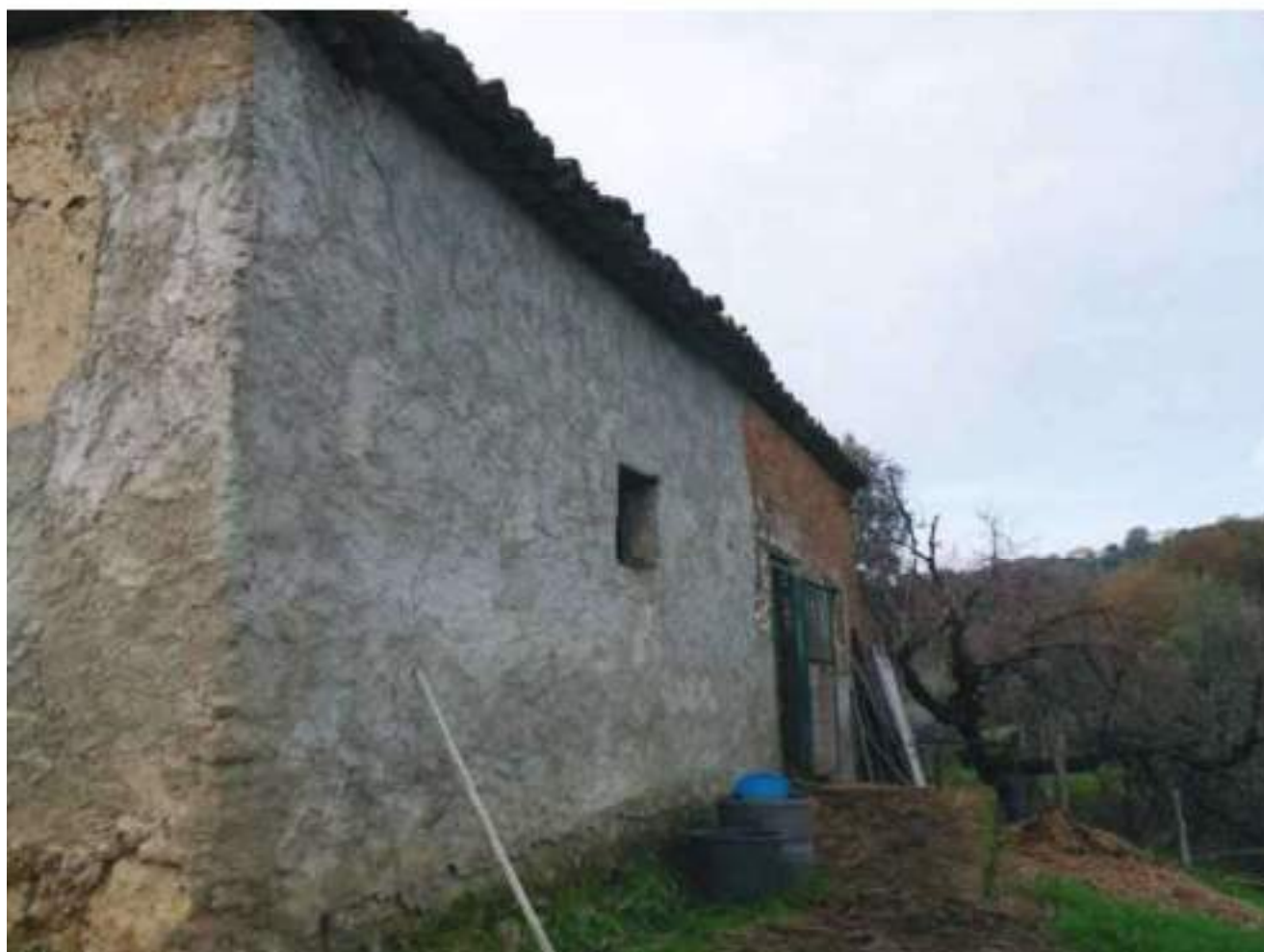
FOTO N. 148: Esterni Bene N. 3
