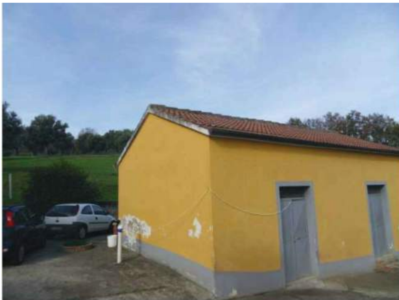
FOTO N. 119: Prospetto SUD - EST Bene N. 2
