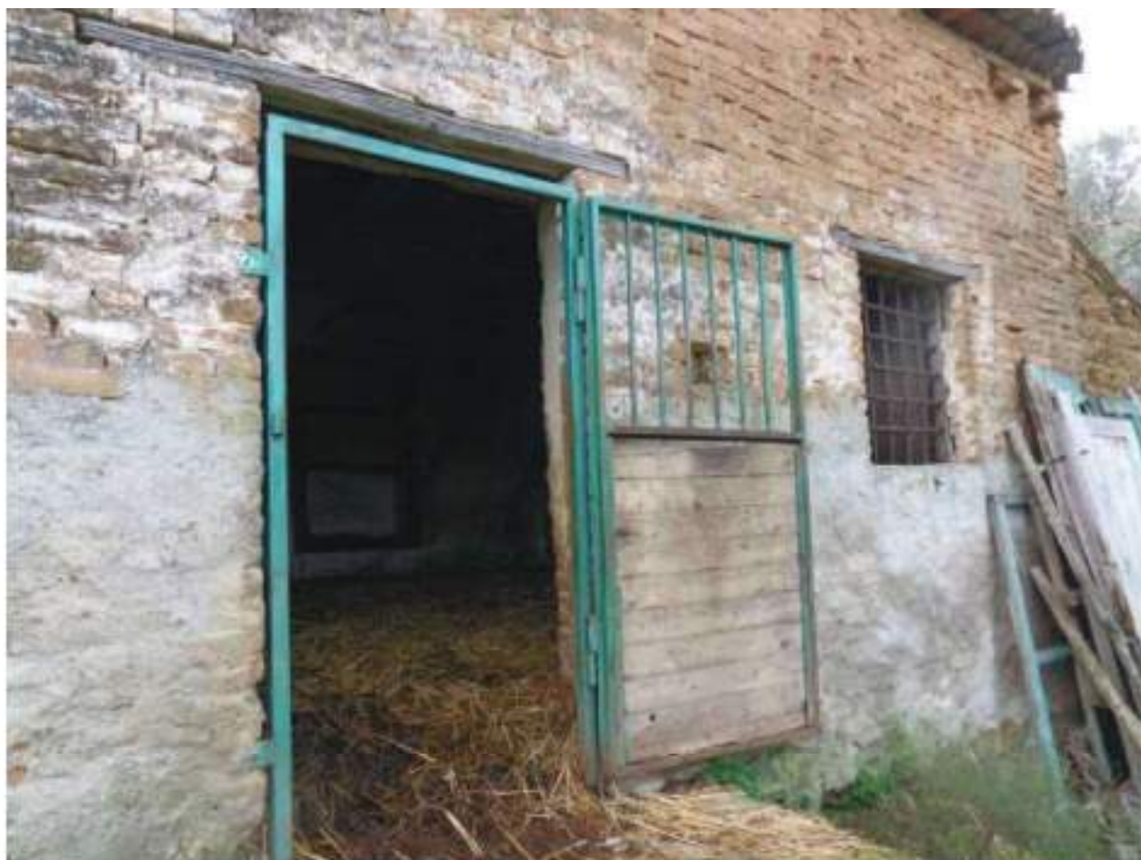
FOTO N. 143: Esterni Bene N. 3
