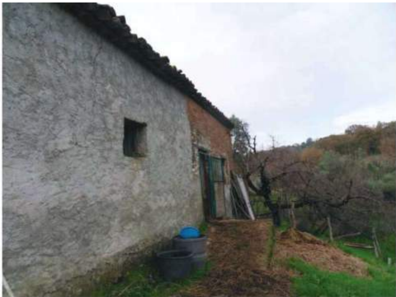
FOTO N. 139: Prospetto NORD – EST Bene N. 3
