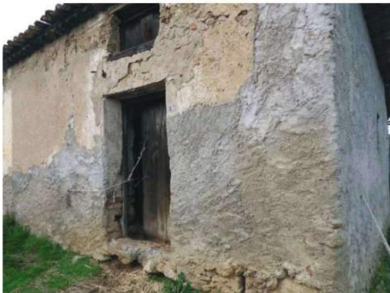
FOTO N. 138: Prospetto SUD – EST Bene N. 3
