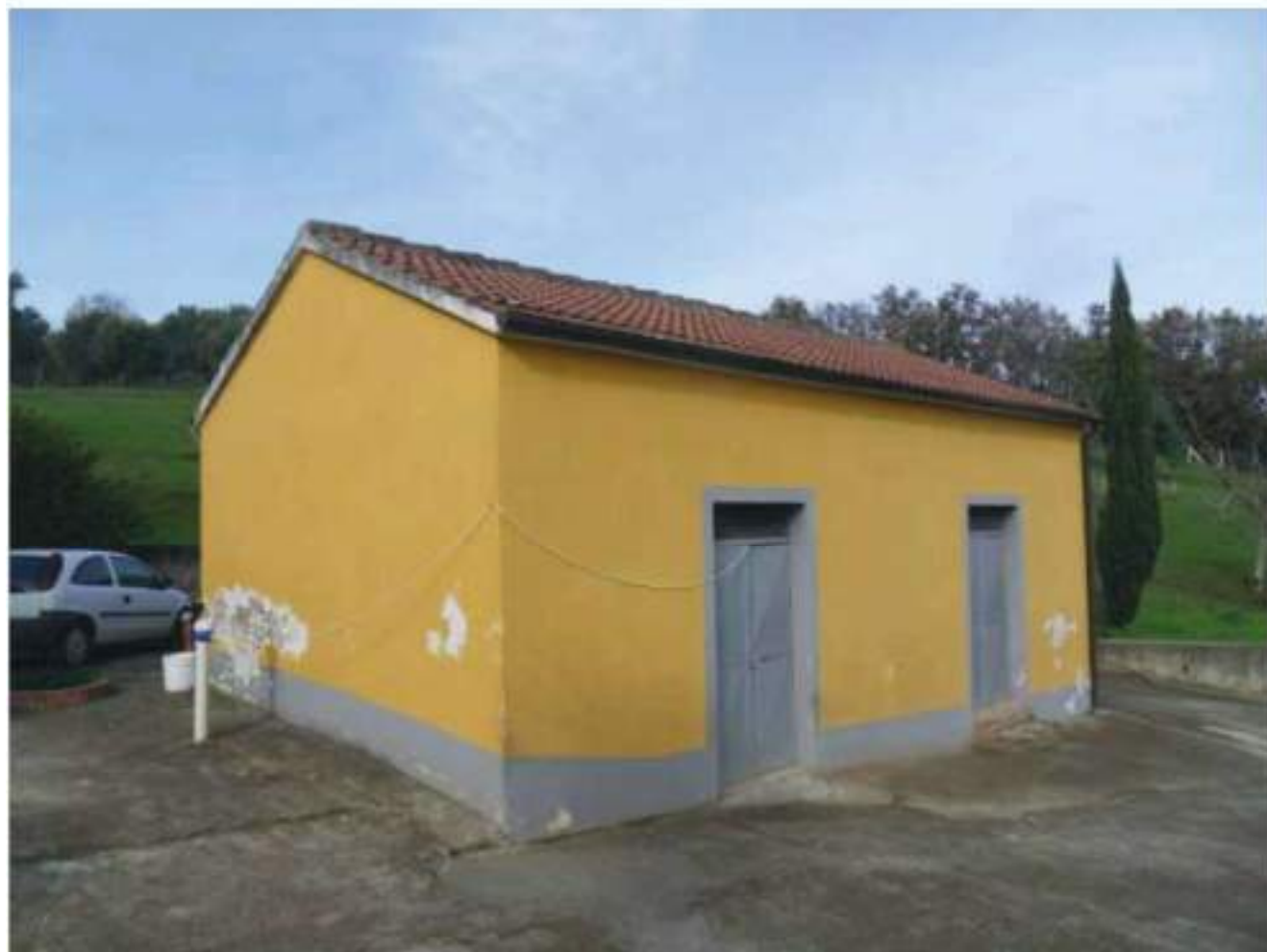
FOTO N. 118: Prospetto SUD - EST Bene N. 2
