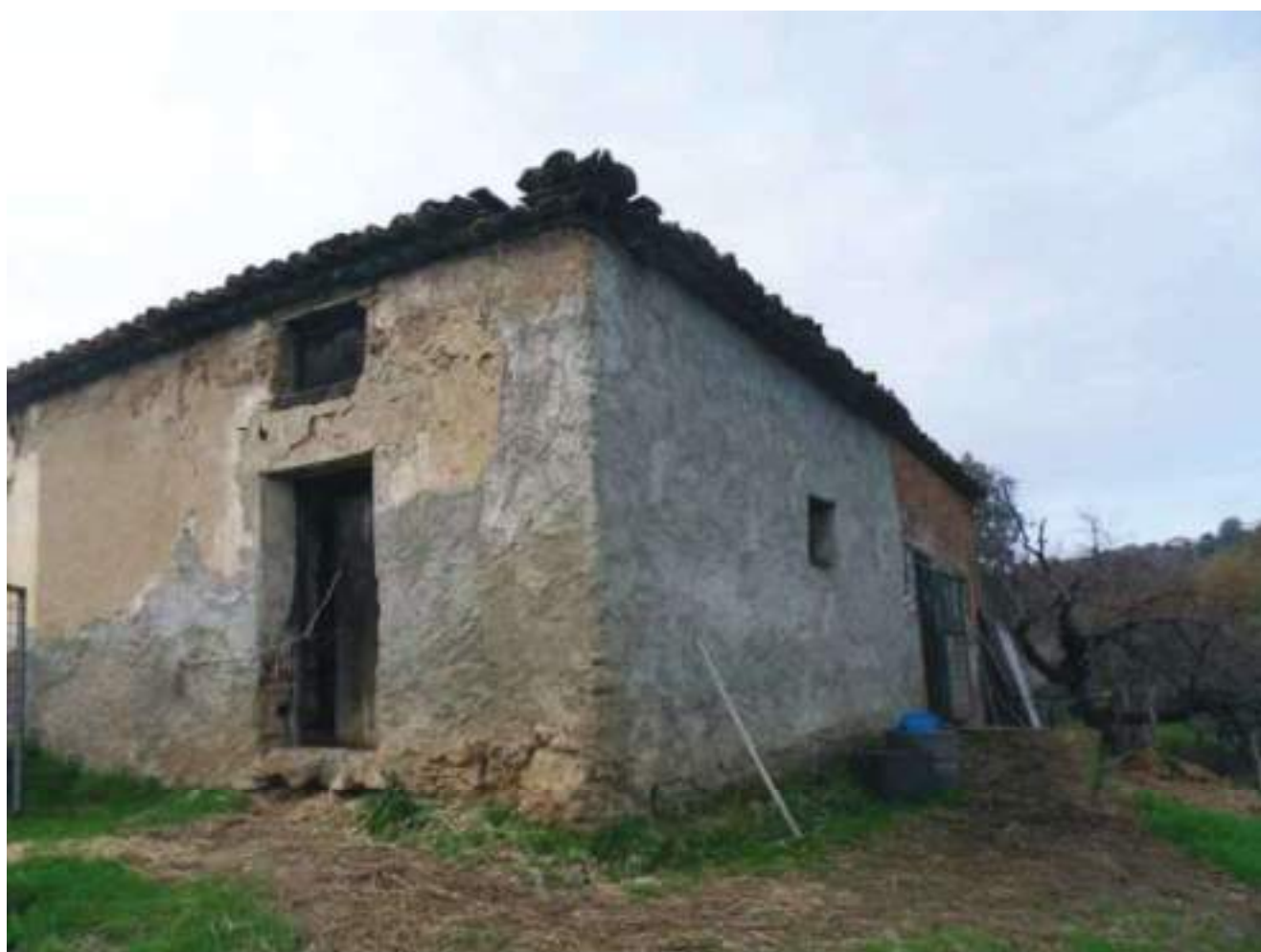
FOTO N. 137: Prospetto SUD – EST Bene N. 3
