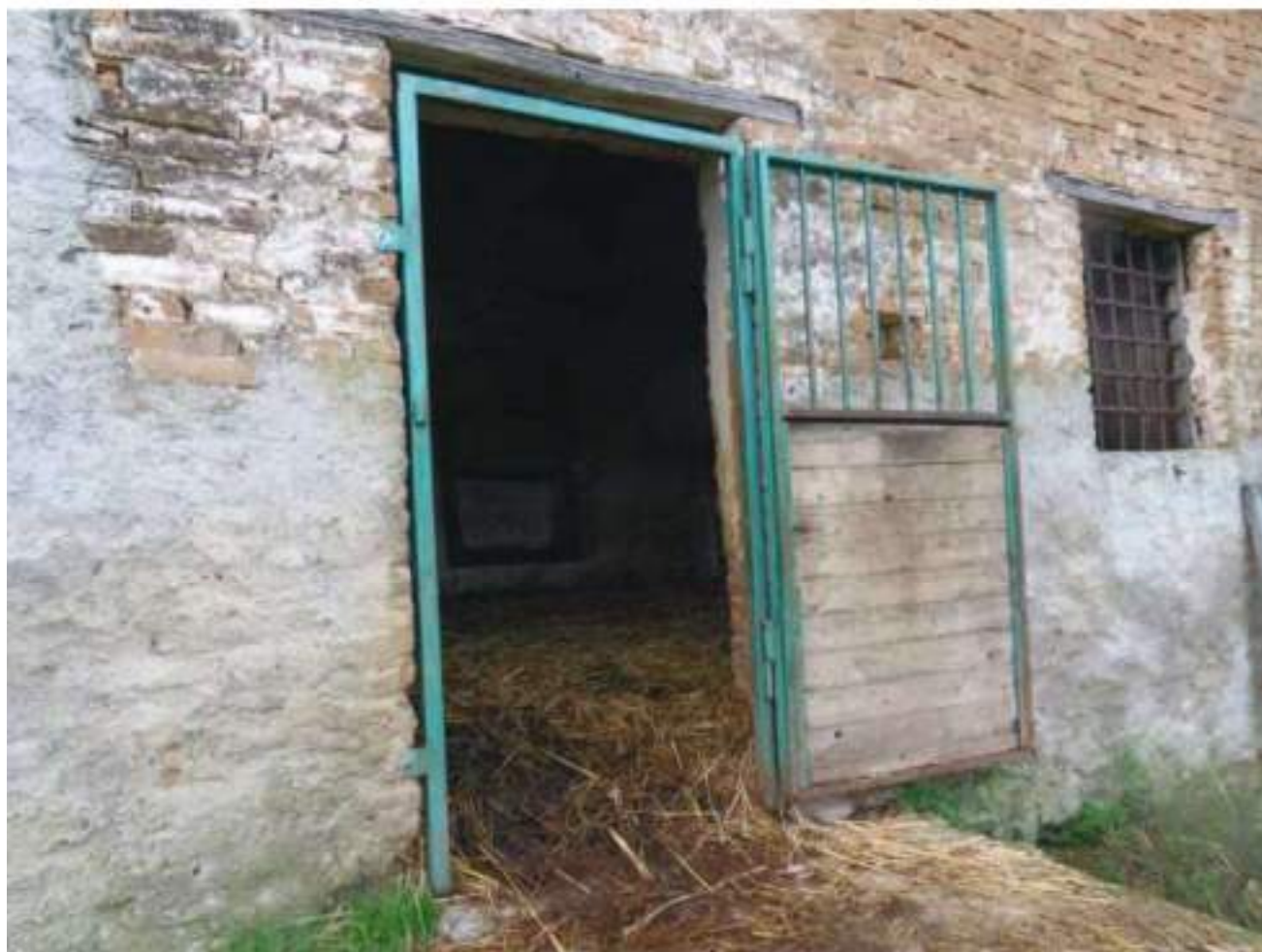
FOTO N. 144: Esterni Bene N. 3
