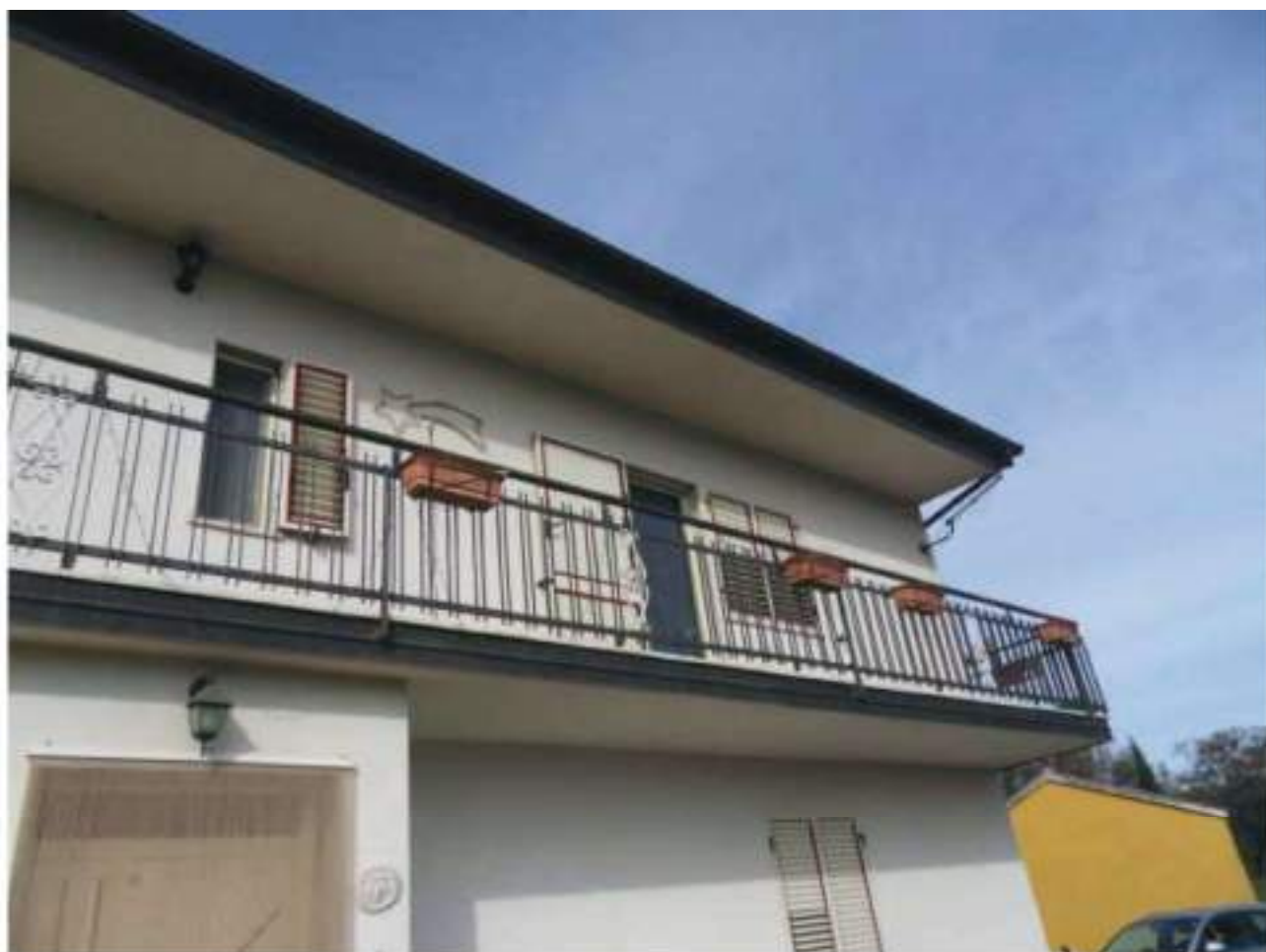
FOTO N. 7: Prospetto SUD - EST Bene N. 1
