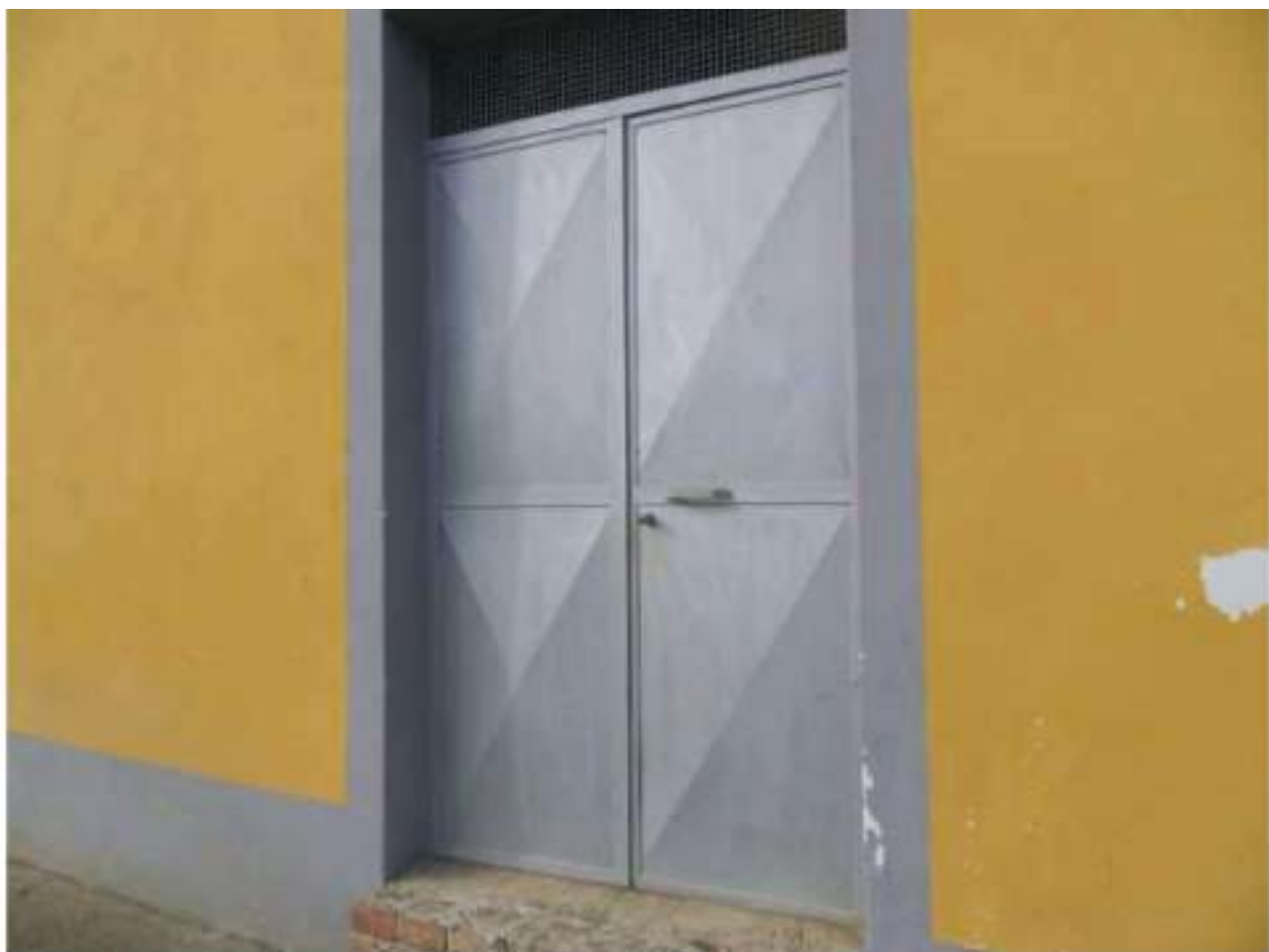
FOTO N. 123: Esterni Bene N. 2
