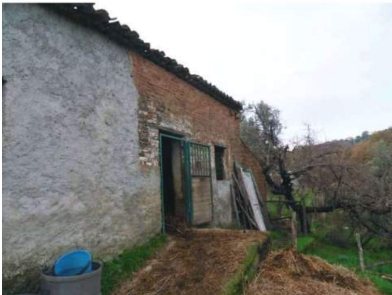
FOTO N. 140: Prospetto NORD – EST Bene N. 3
