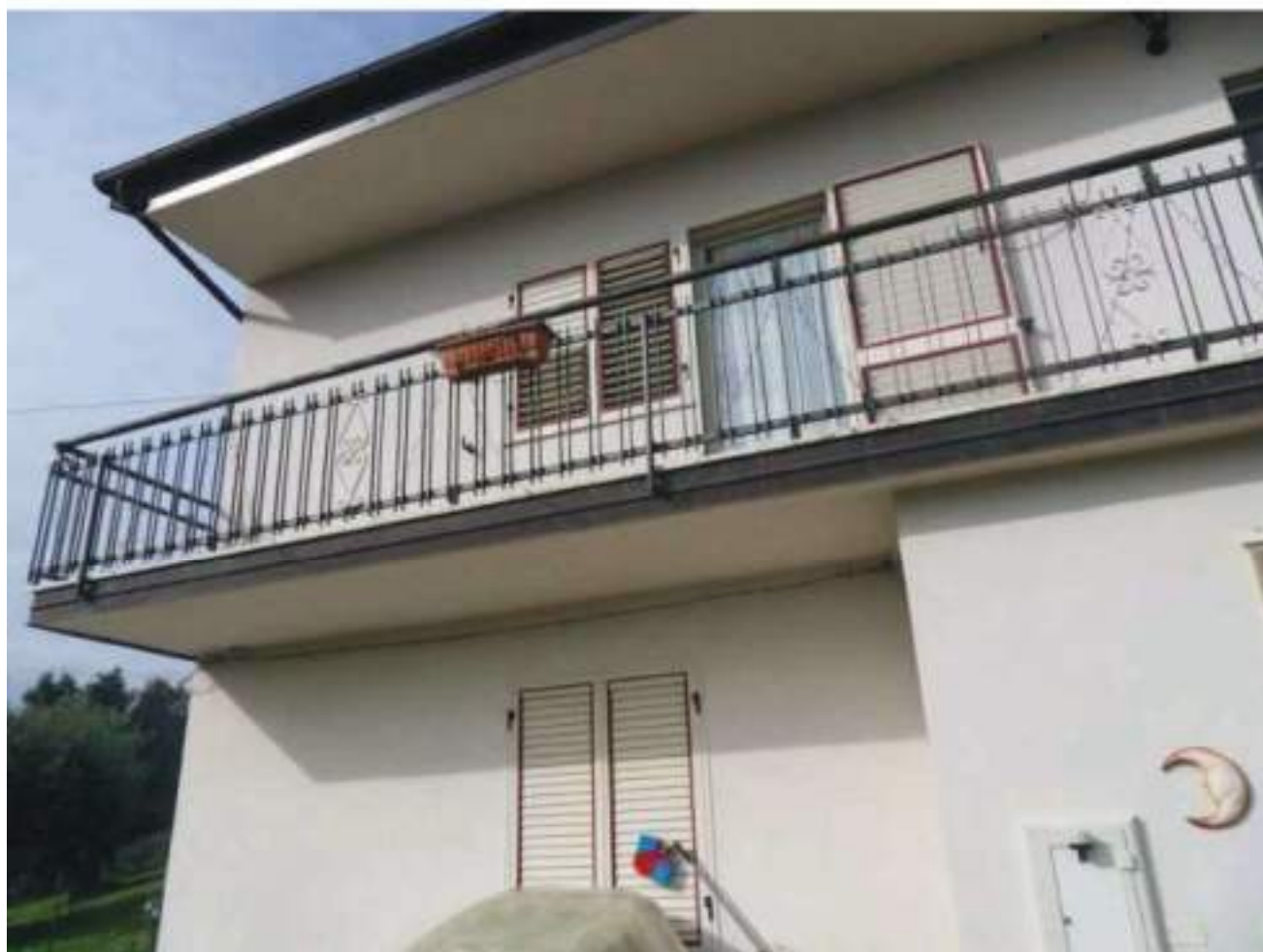
FOTO N. 8: Prospetto SUD - EST Bene N. 1
