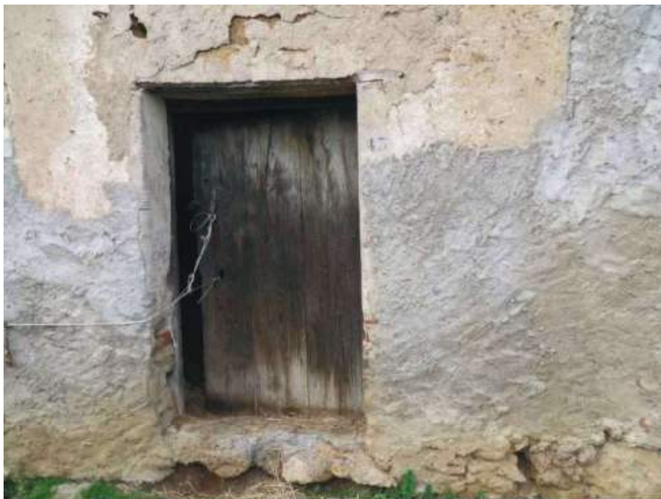
FOTO N. 151: Esterni Bene N. 3
