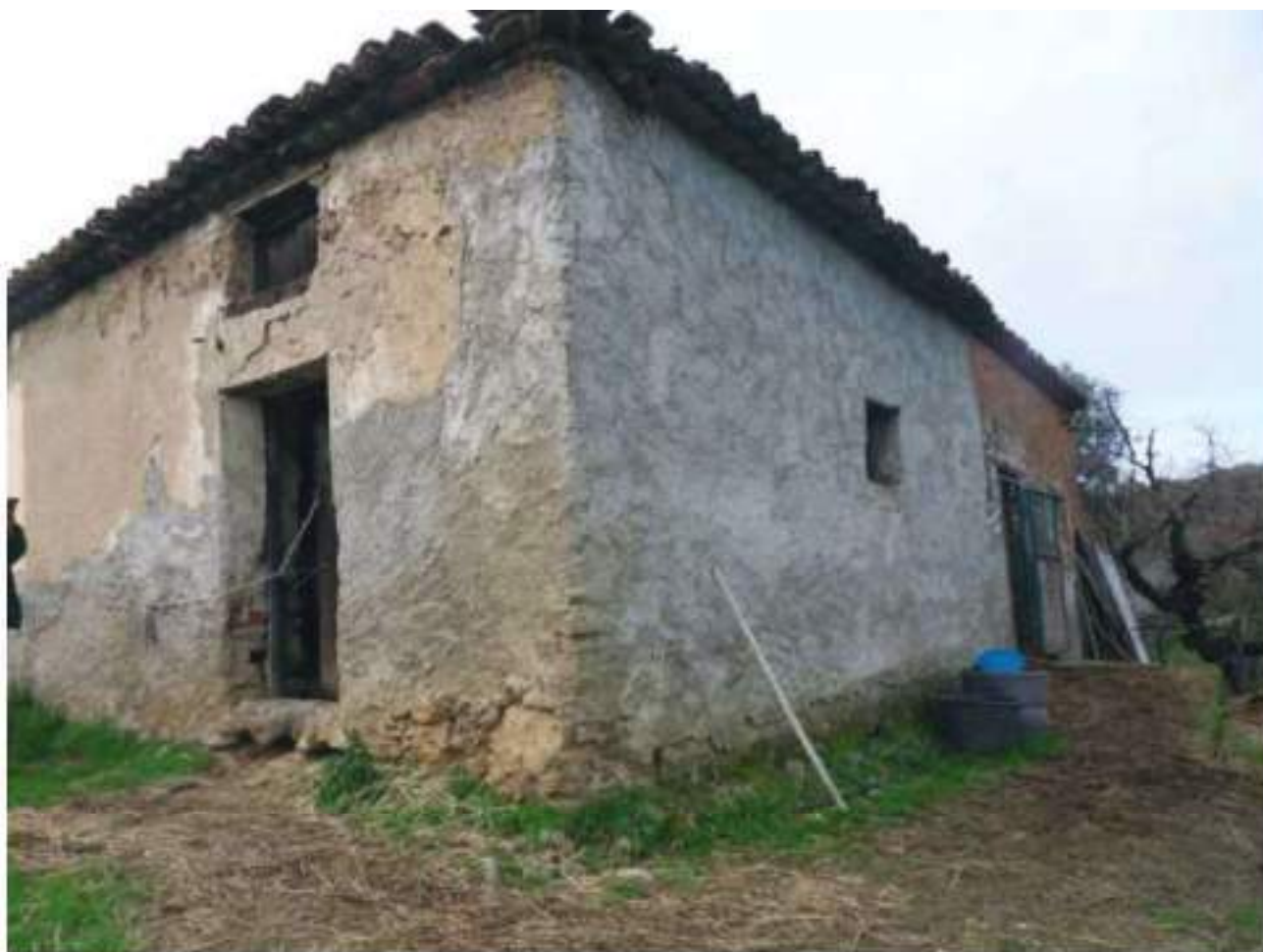
FOTO N. 149: Prospetto SUD – EST Bene N. 3
