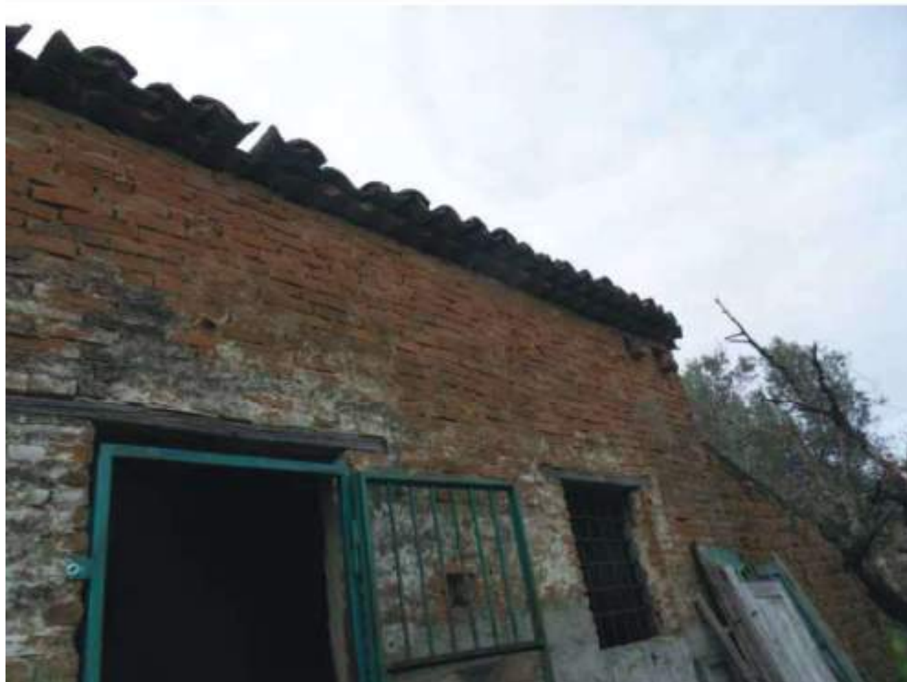
FOTO N. 146: Esterni Bene N. 3
