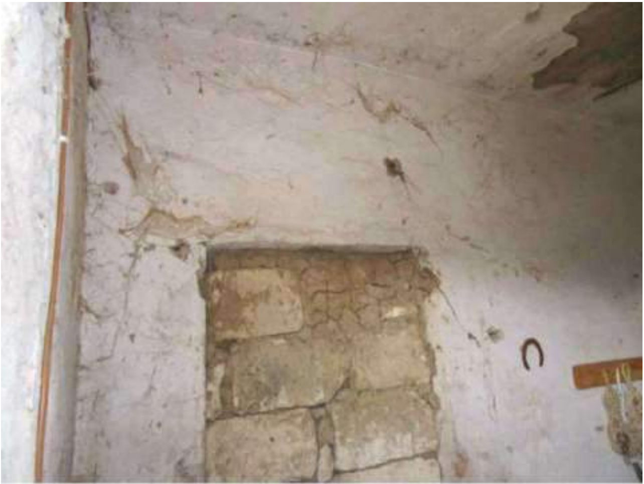
FOTO N. 125: Interni Bene N. 2
