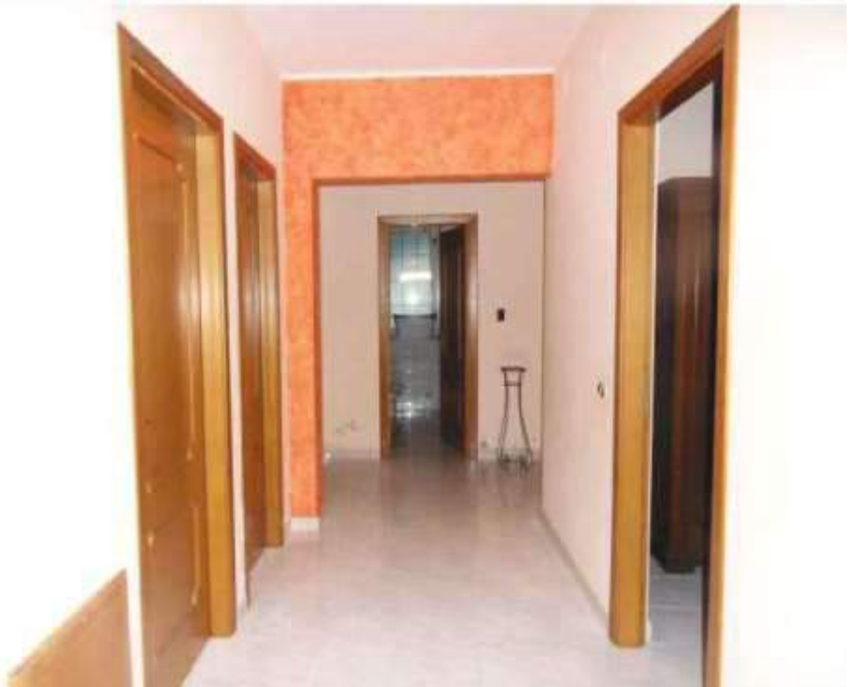
FOTO N. 34: Interni Bene N. 1 (PIANO TERRA)
