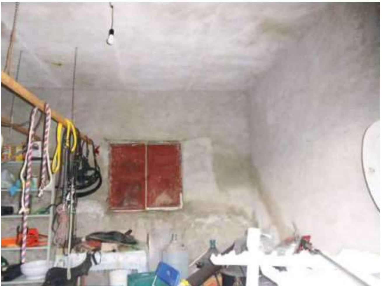
FOTO N. 134: Interni Bene N. 2
