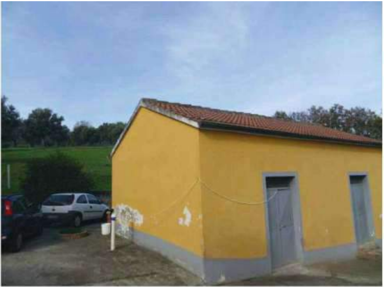
FOTO N. 119: Prospetto SUD - EST Bene N. 2
