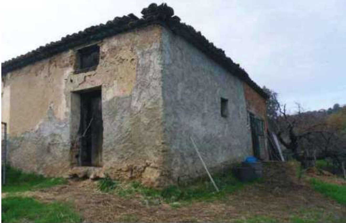
FOTO N. 137: Prospetto SUD – EST Bene N. 3
