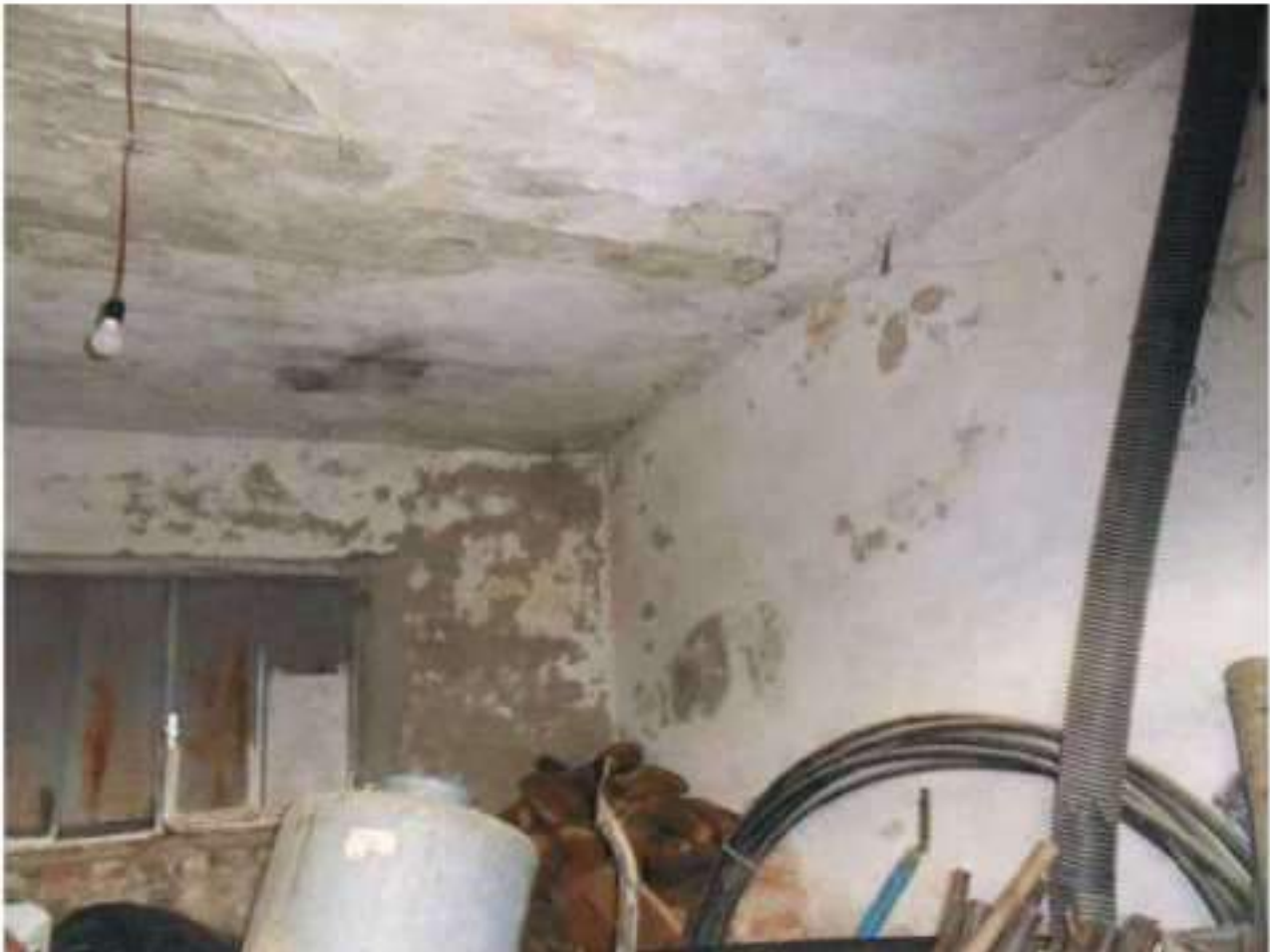
FOTO N. 126: Interni Bene N. 2
