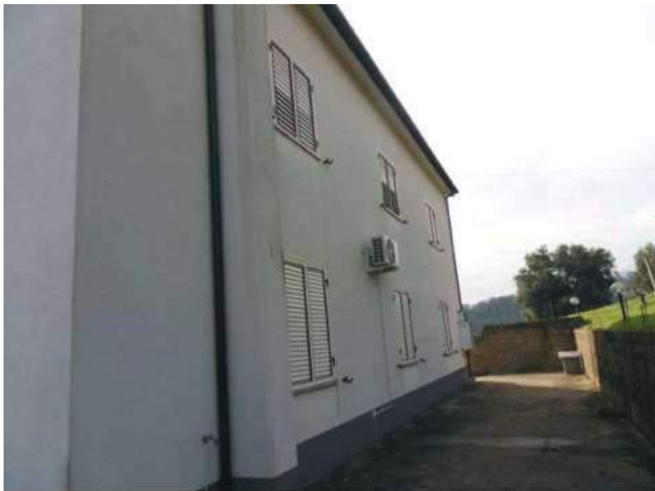
FOTO N. 13: Prospetto NORD - OVEST Bene N. 1
