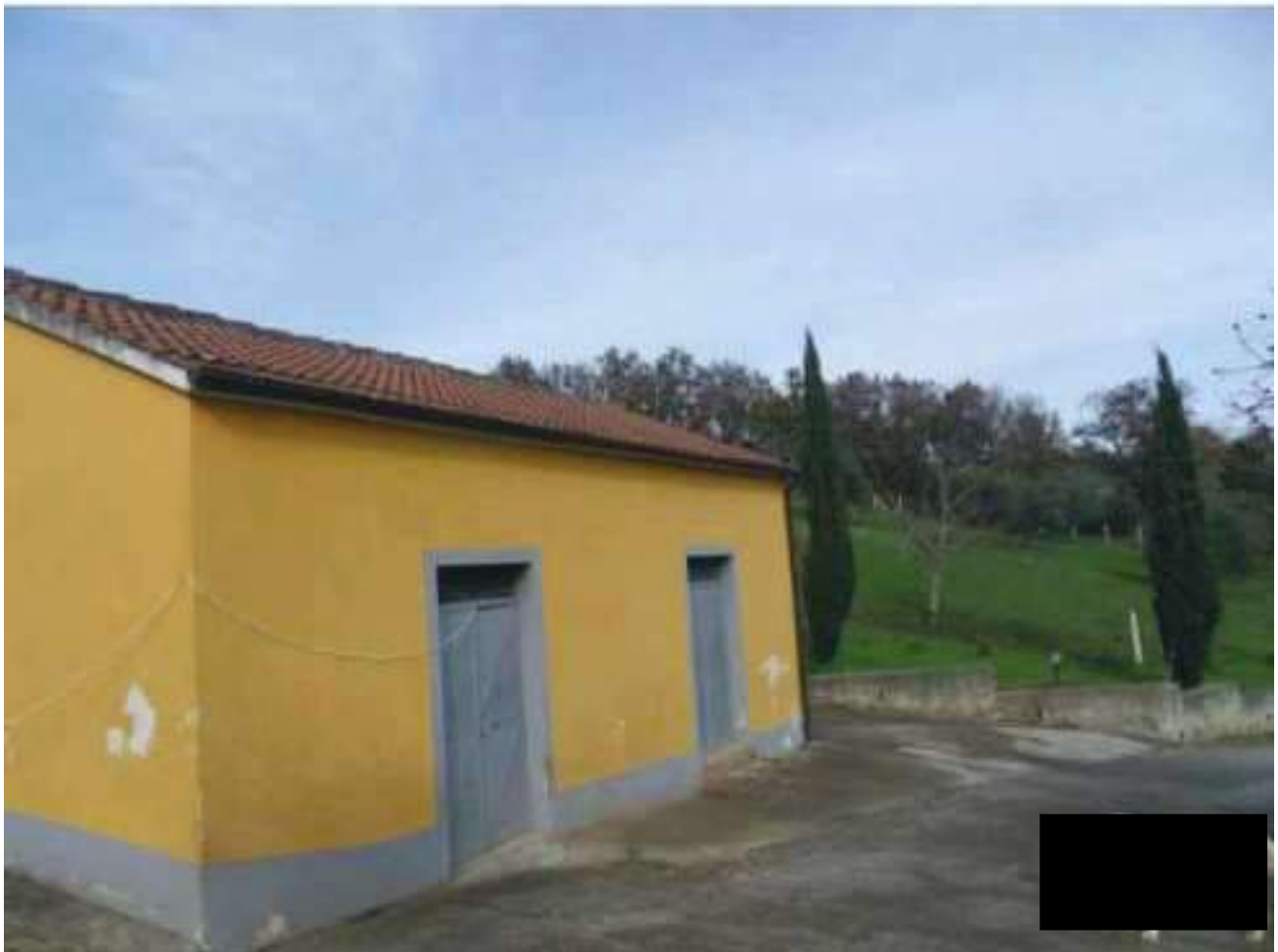
FOTO N. 120: Prospetto EST Bene N. 2
