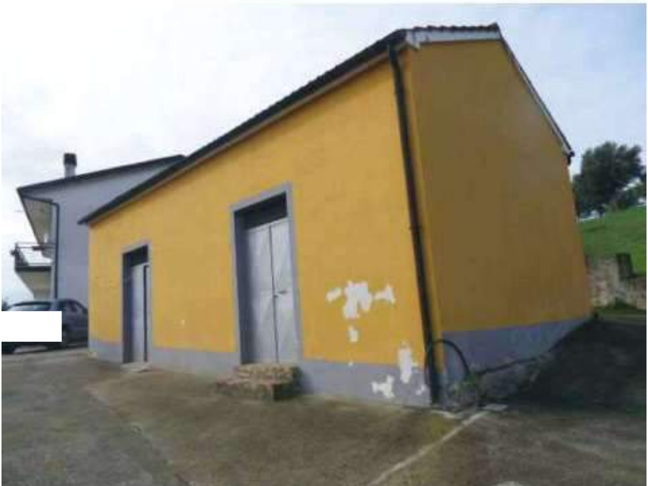
FOTO N. 122: Prospetto EST Bene N. 2
