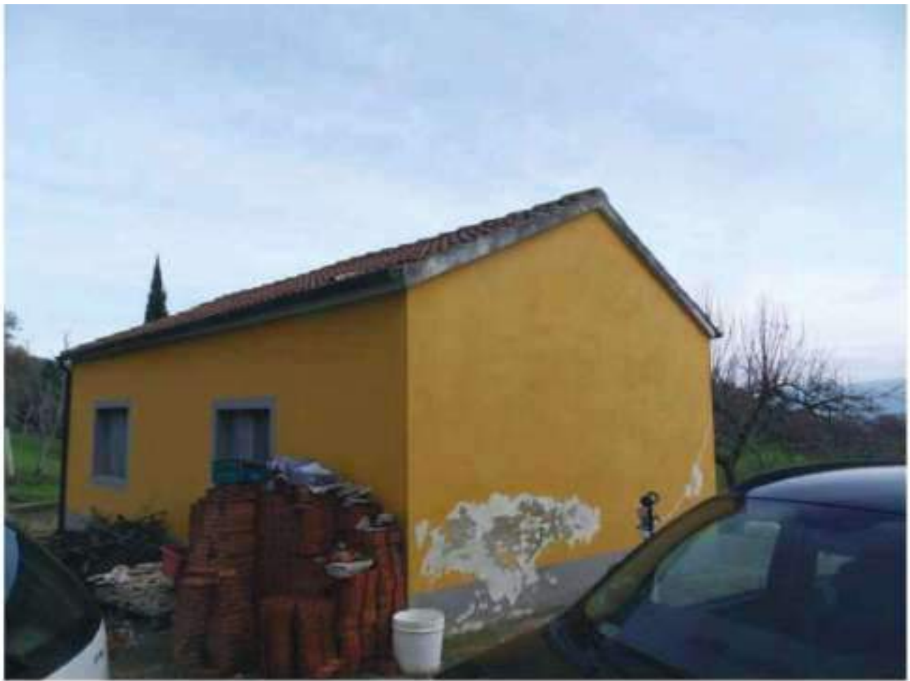
FOTO N. 135: Prospetto NORD – OVEST Bene N. 2
