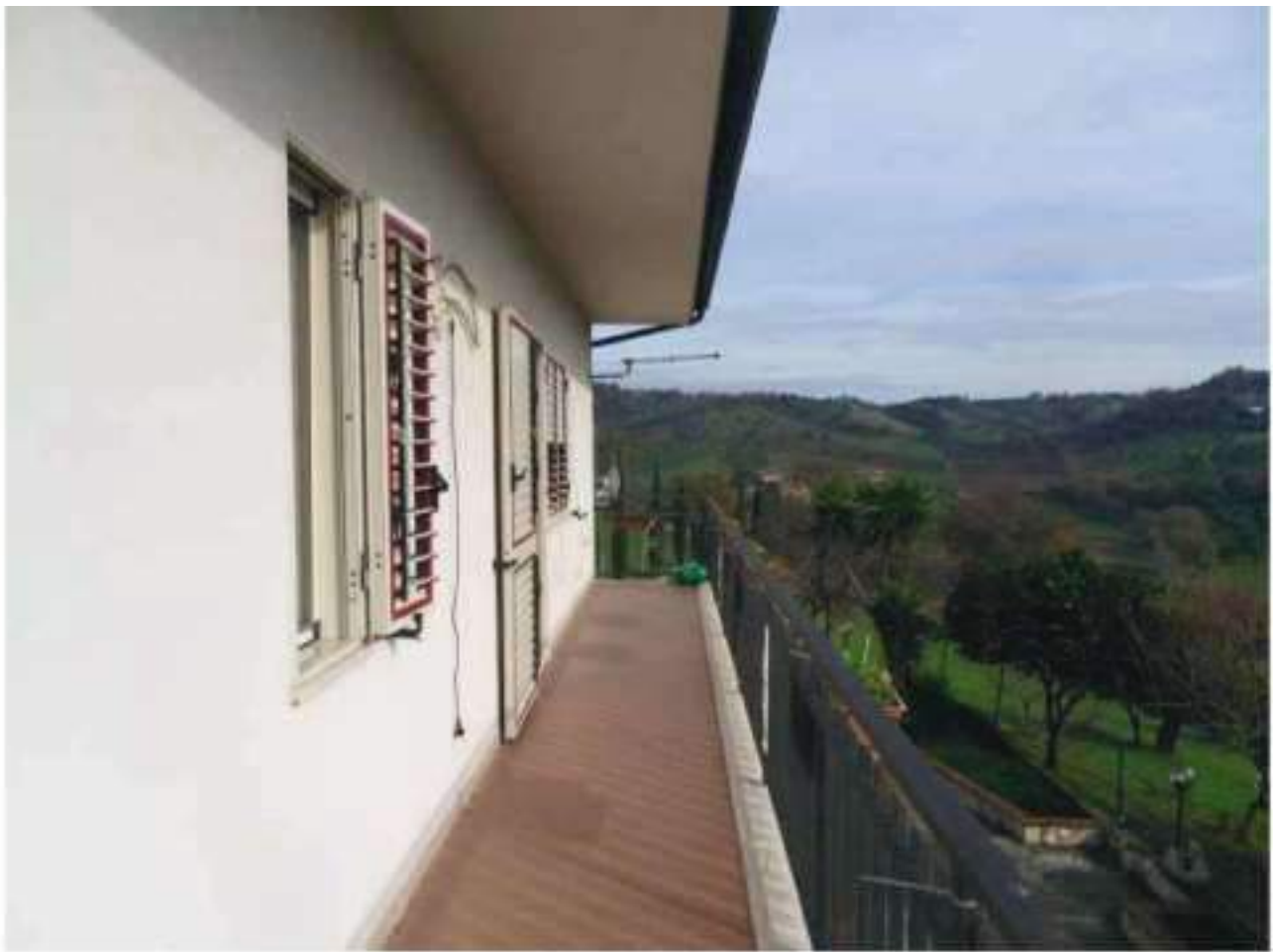
FOTO N. 79: Esterni Bene N. 1 (PIANO PRIMO - Balcone)
