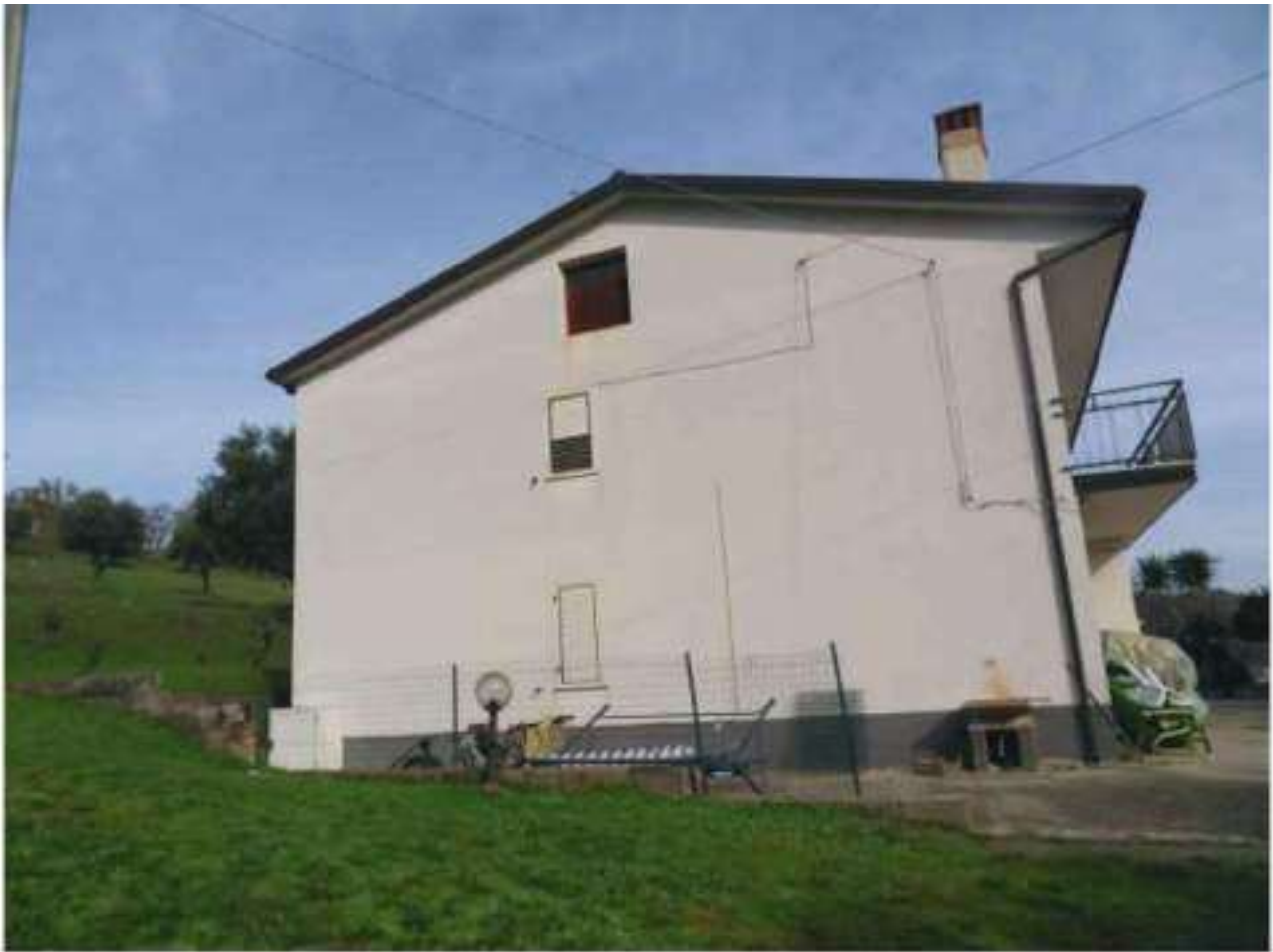
FOTO N. 15: Prospetto SUD - OVEST Bene N. 1
