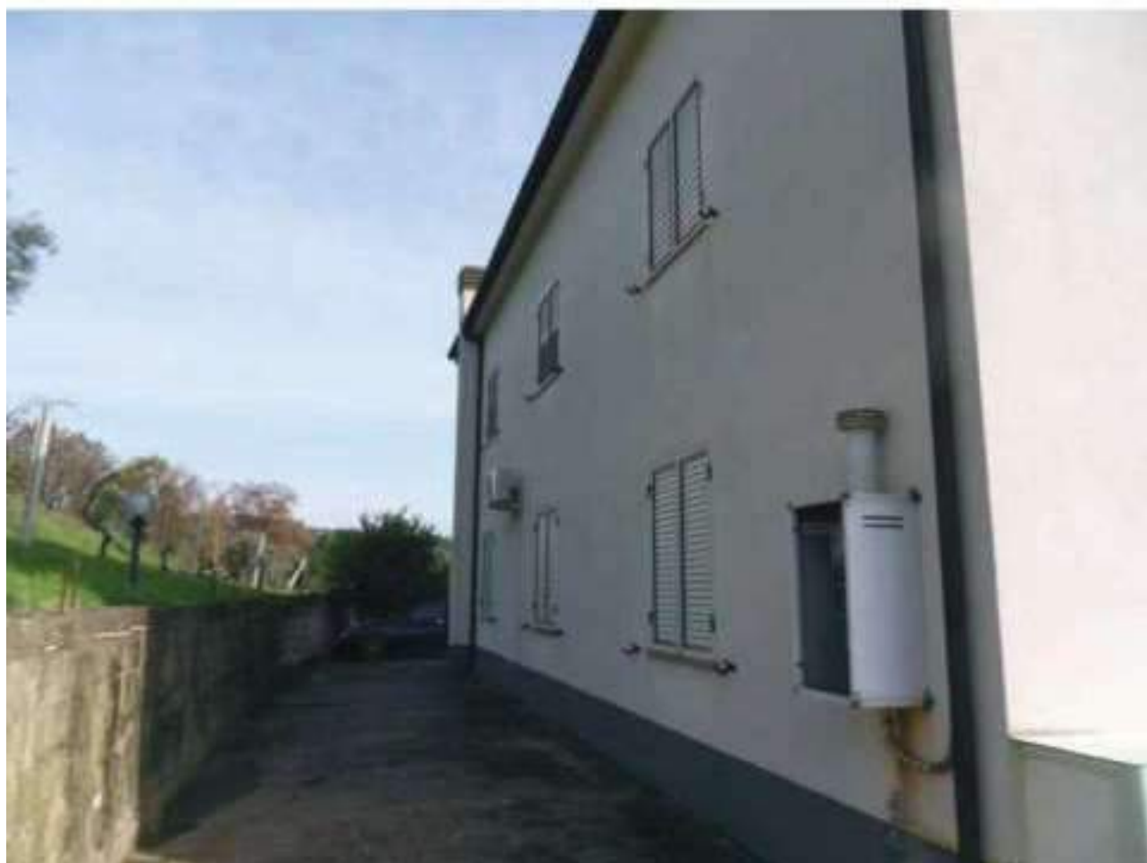
FOTO N. 14: Prospetto NORD - OVEST Bene N. 1
