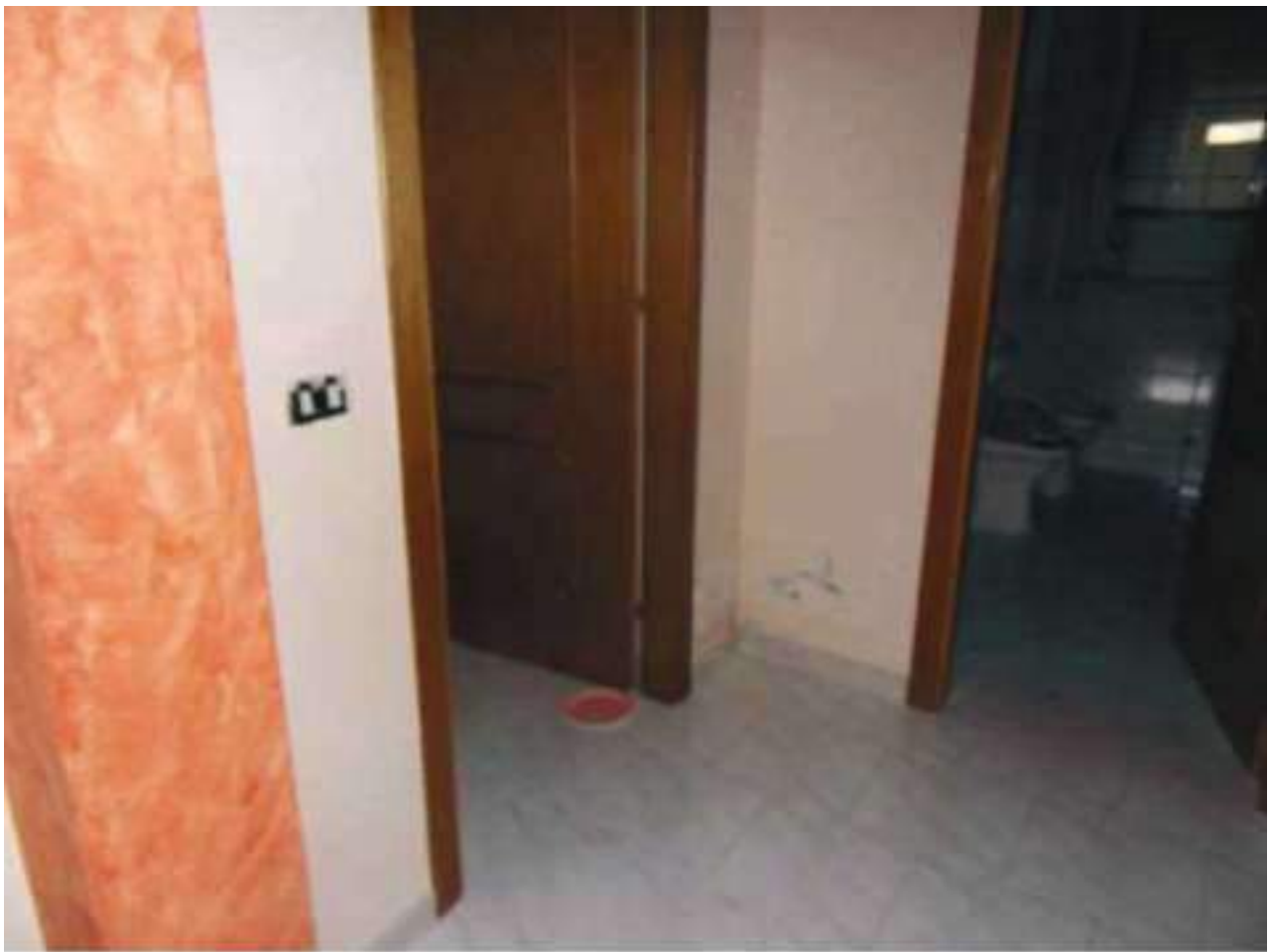
FOTO N. 47: Interni Bene N. 1 (PIANO TERRA)
