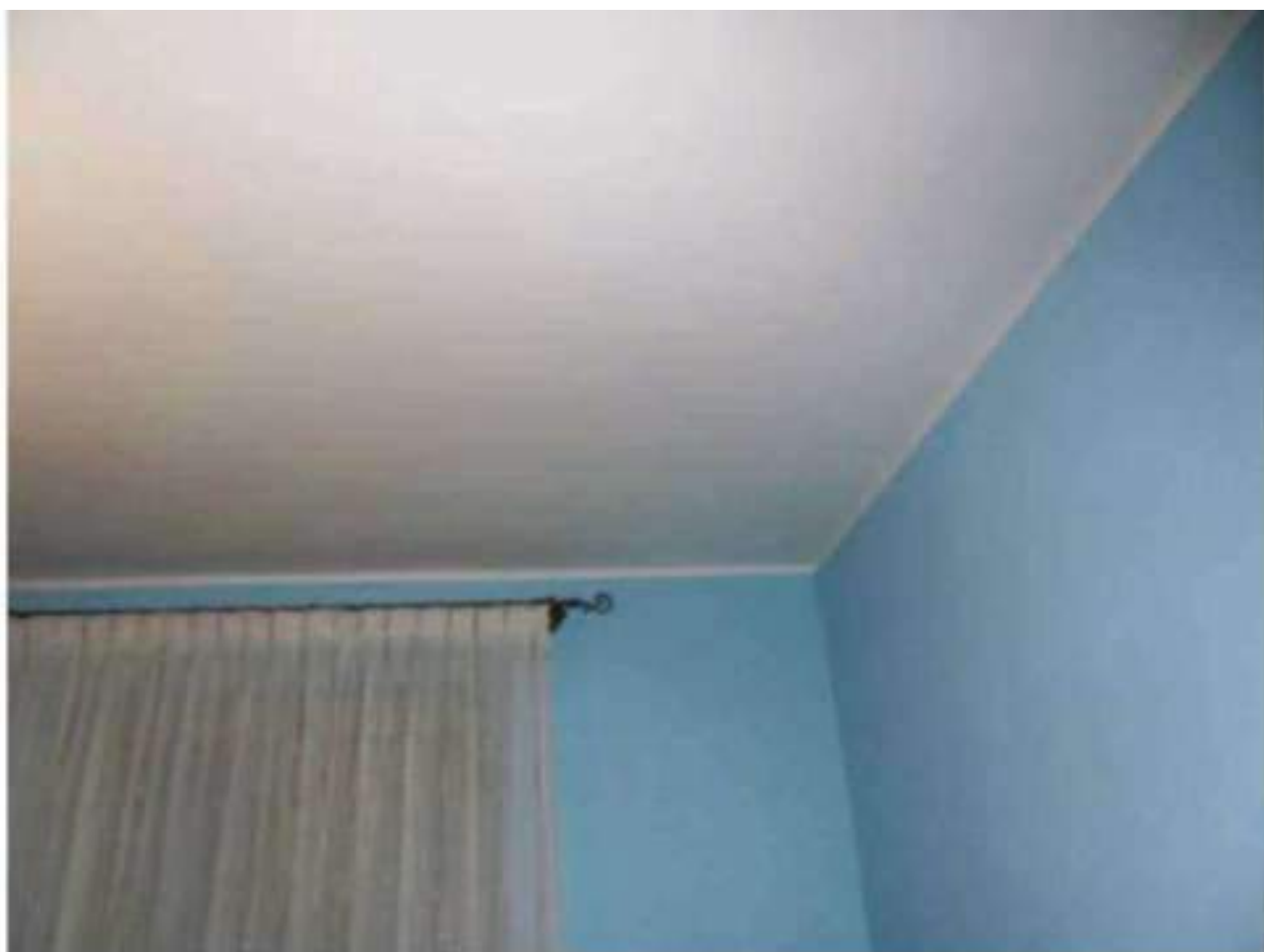
FOTO N. 63: Interni Bene N. 1 (PIANO TERRA)
