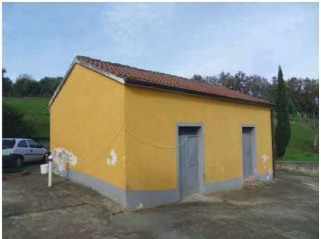
FOTO N. 118: Prospetto SUD - EST Bene N. 2
