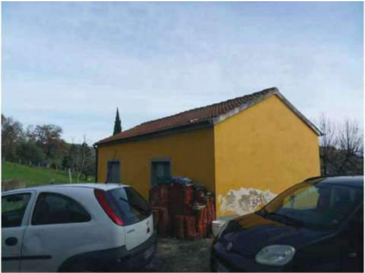
FOTO N. 121: Prospetto NORD – OVEST Bene N. 2
