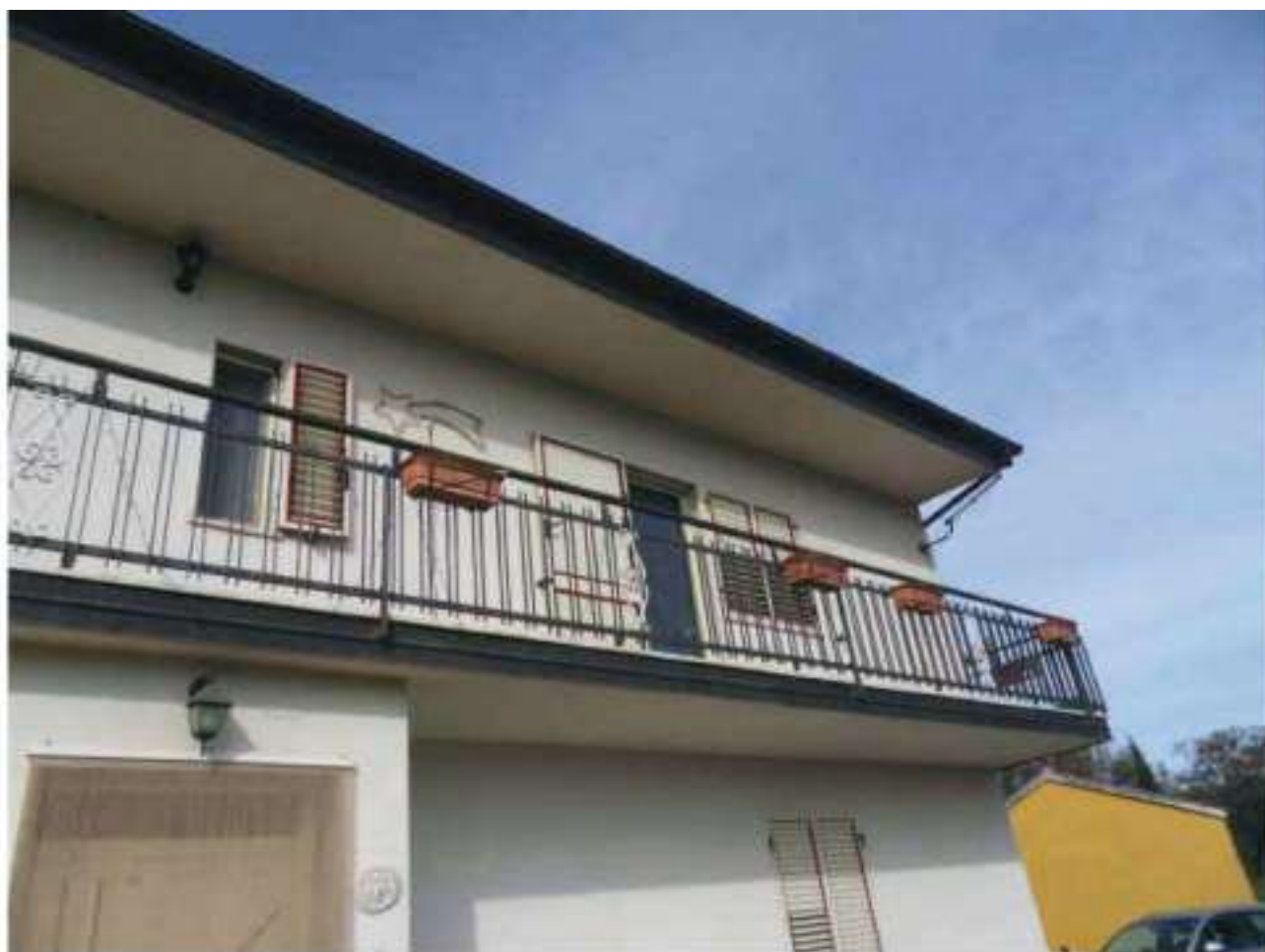
FOTO N. 7: Prospetto SUD - EST Bene N. 1
