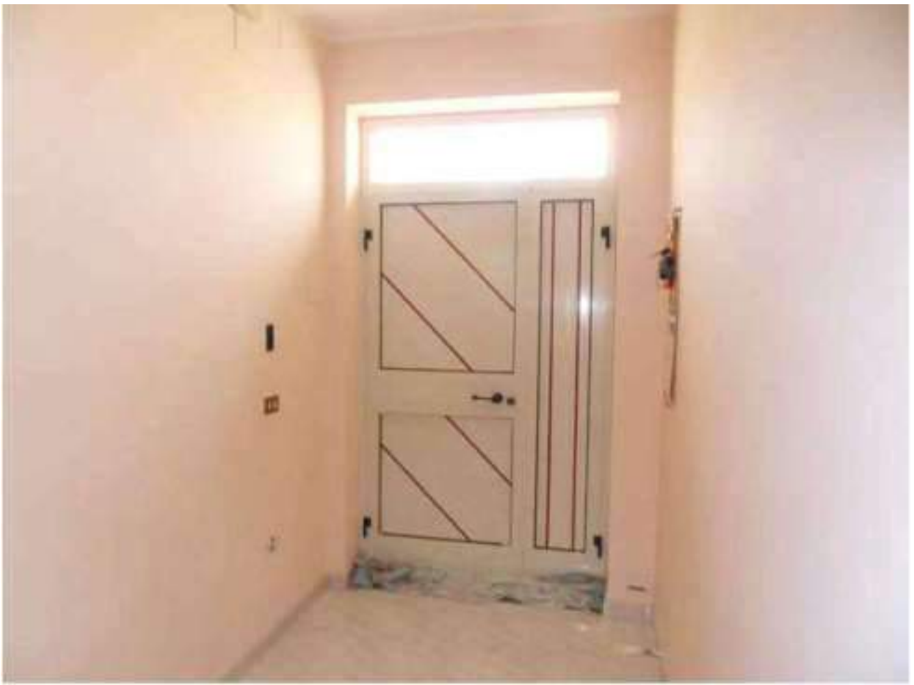
FOTO N. 27: Interni Bene N. 1 (PIANO TERRA)
