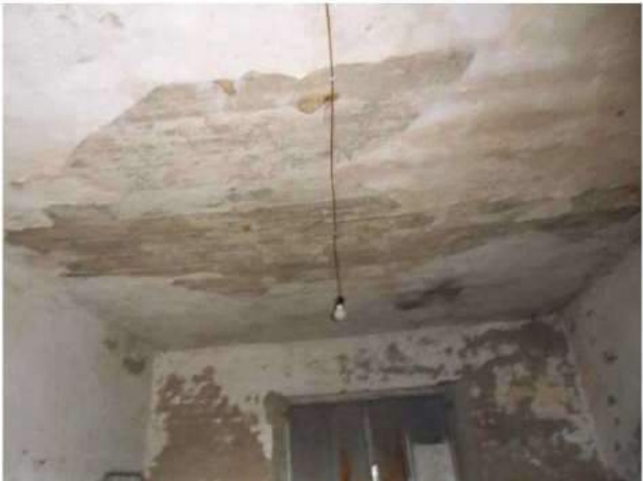
FOTO N. 128: Interni Bene N. 2
