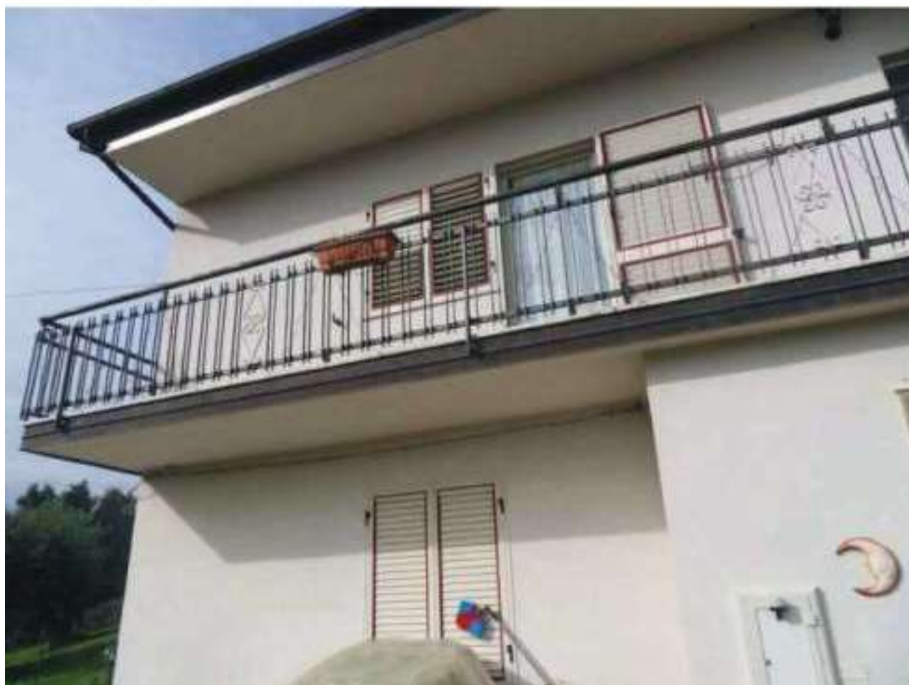
FOTO N. 8: Prospetto SUD - EST Bene N. 1
