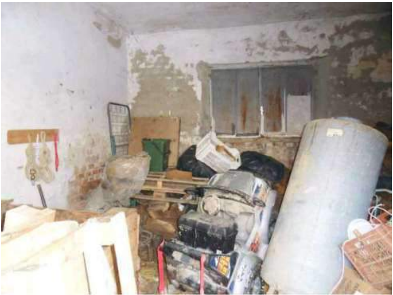
FOTO N. 127: Interni Bene N. 2
