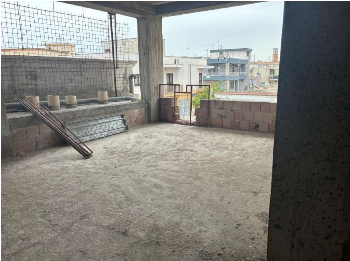
Foto n. 21 - Sub 3, verso Via Salice e confine con il fabbricato adiacente
