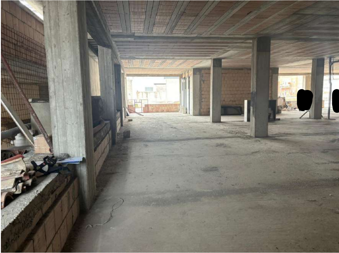
Foto n. 19 – Vista del sub 3 verso Via Salice
