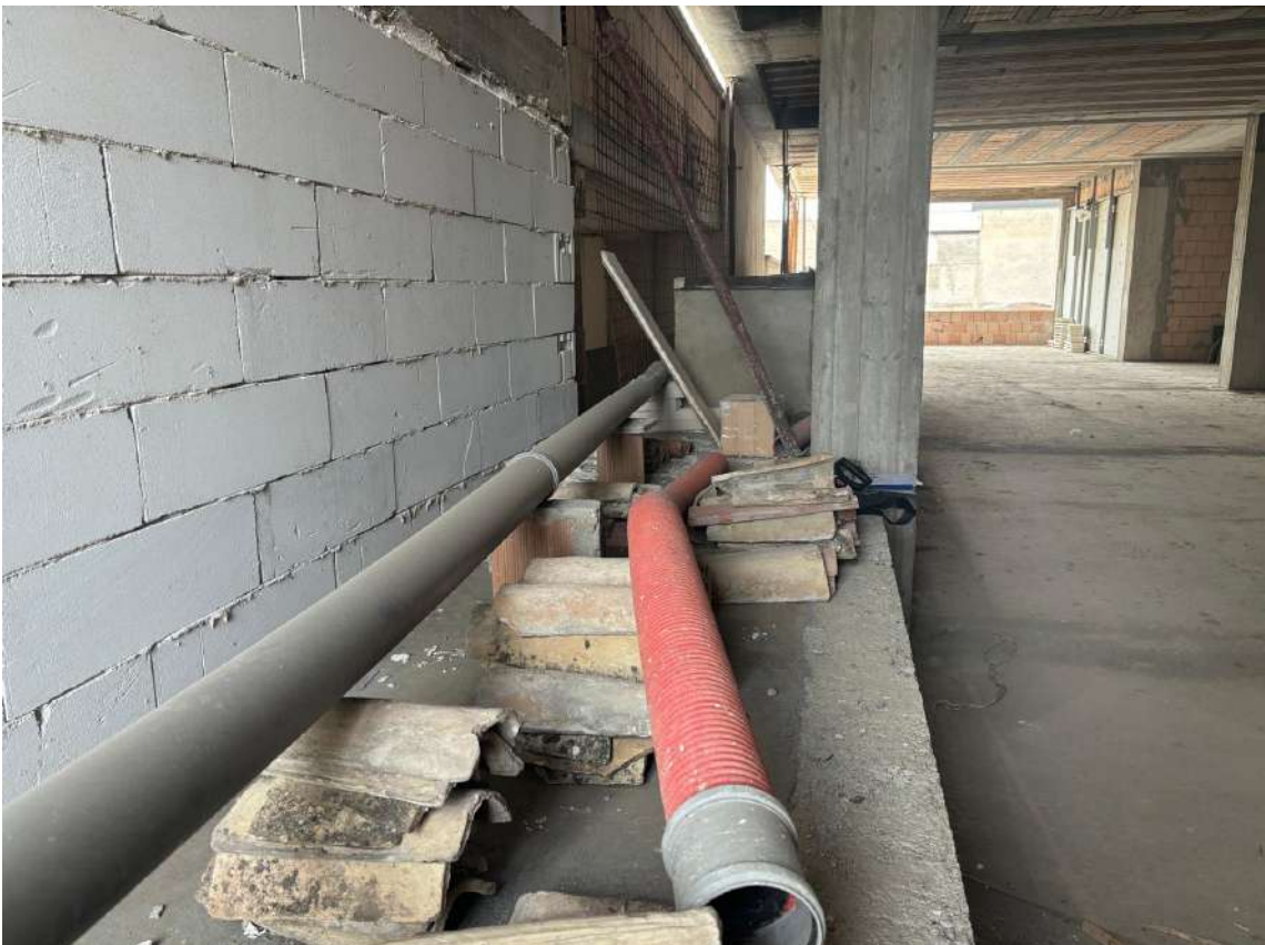
Foto n. 20 - Vista del sub 3 verso Via Salice (particolare del confine del fabbricato)
