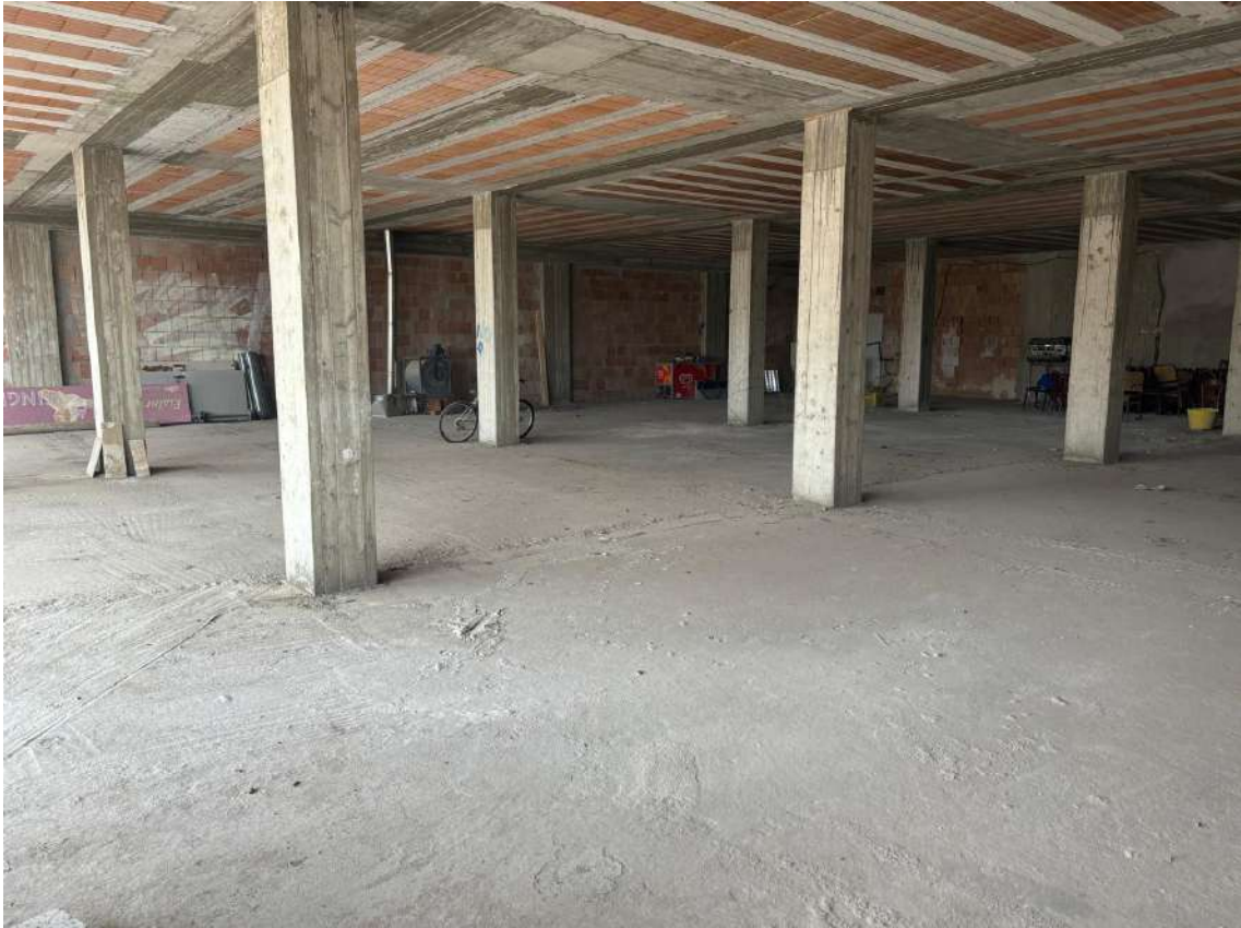
Foto n. 17 – Interno dei locali (corridoio comune e sub 4)
