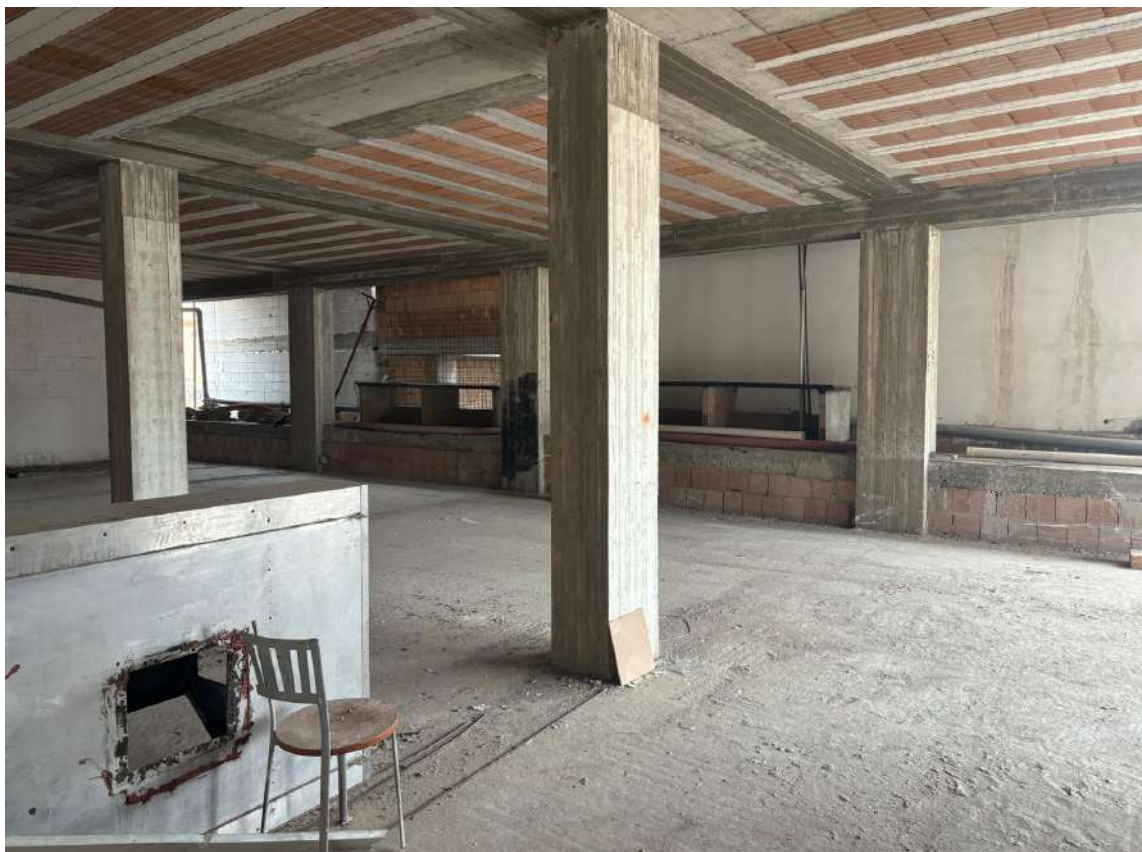
Foto n. 22 - Sub 3, particolare del confine con il fabbricato adiacente
