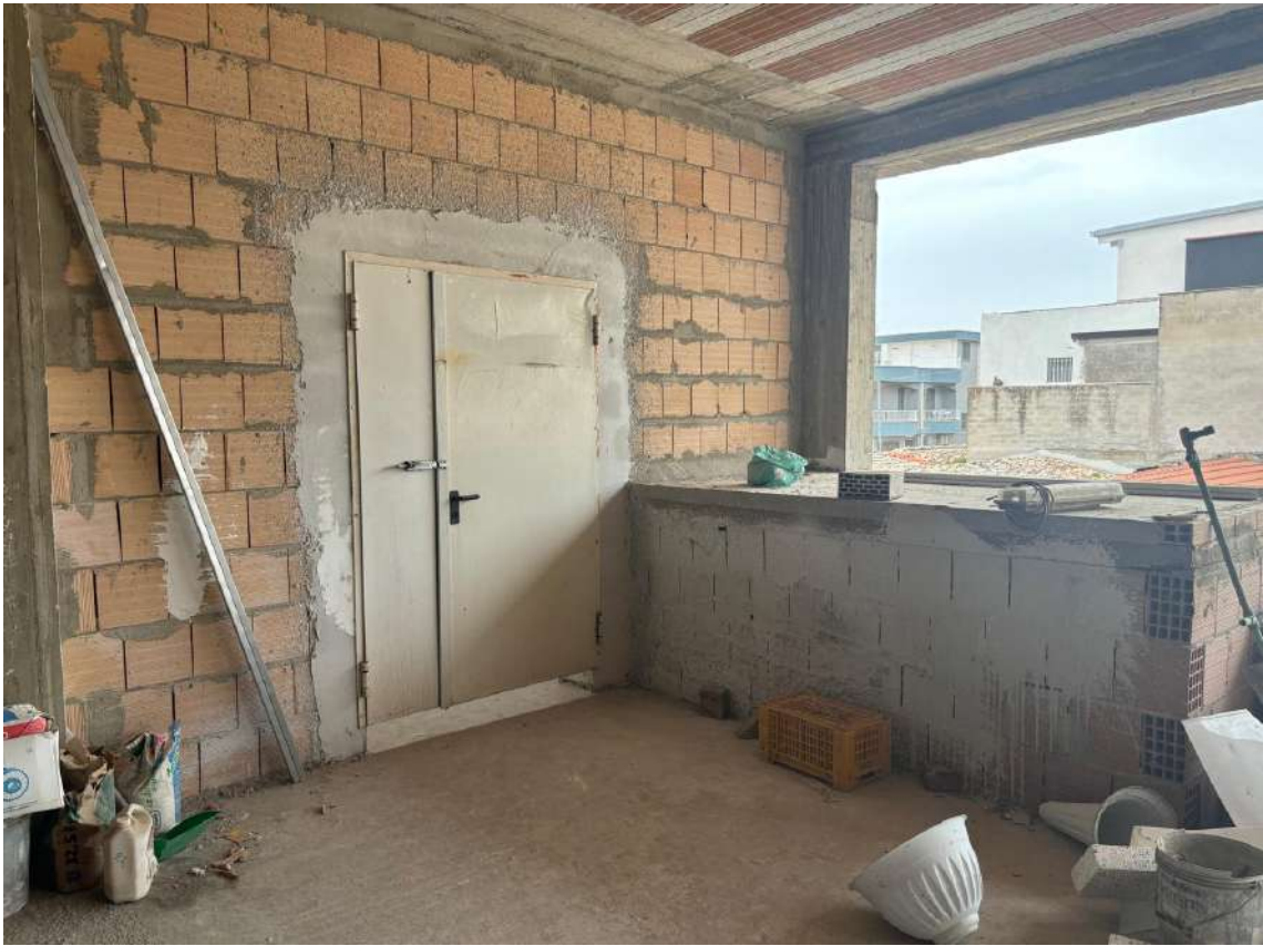
Foto n. 15 – Porta d'accesso dal pianerottolo del primo piano
