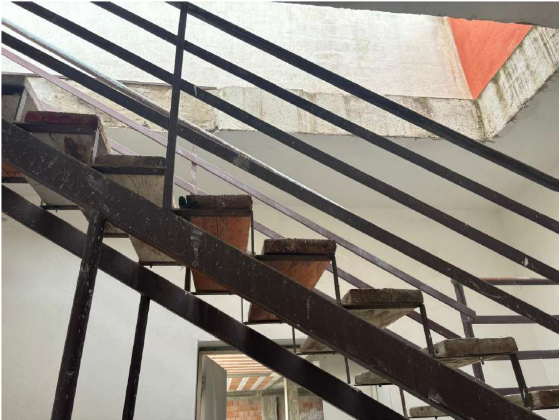
Foto n. 13 – Scala di accesso dal primo piano al lastrico solare dell'edificio
