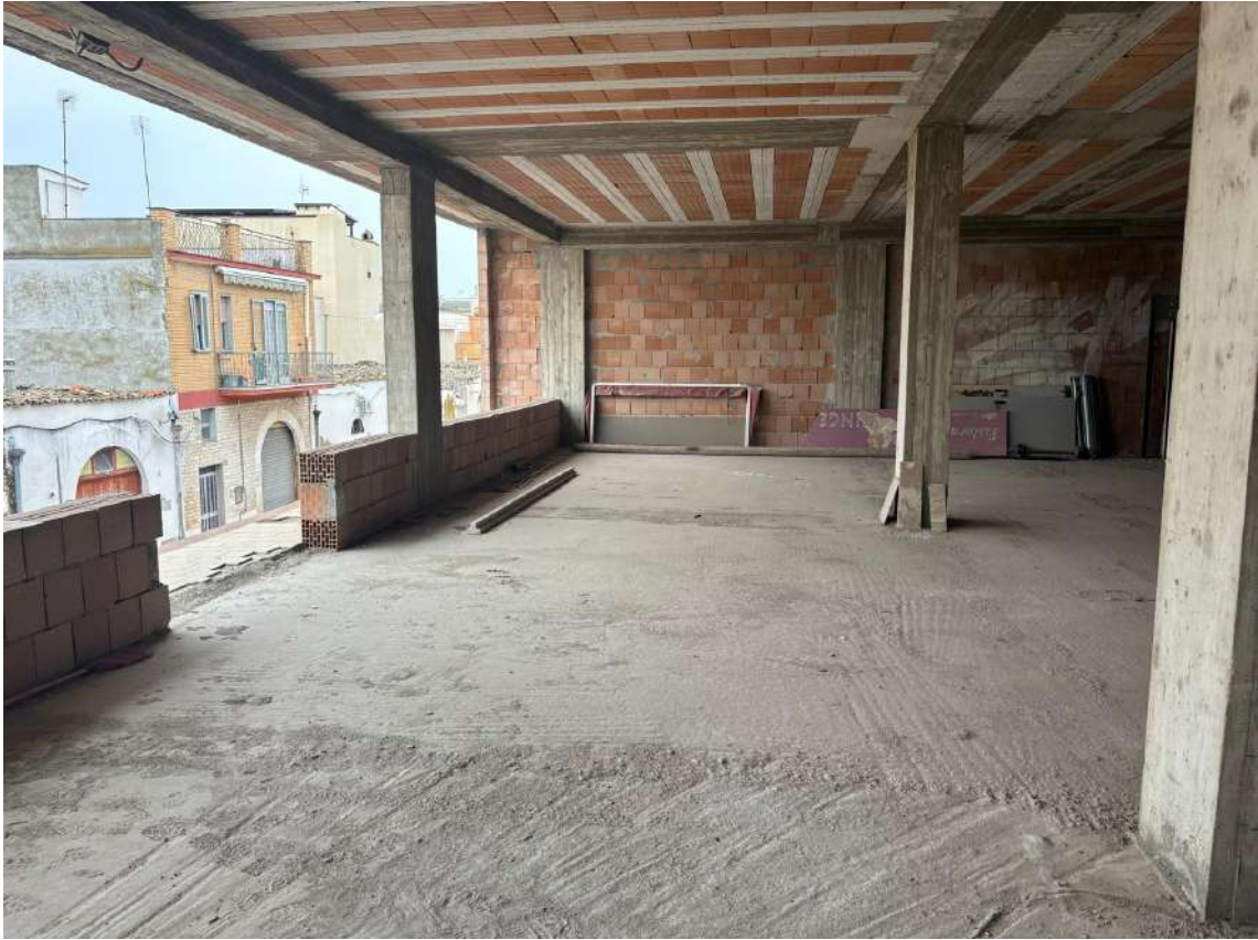
Foto n. 27 - Sub 4, tompagnatura verso il fabbricato adiacente e affaccio su via Salice
