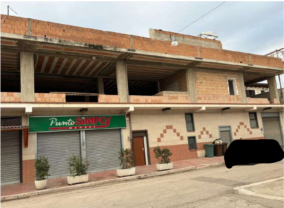
Foto n. 4 - Prospetto di Via Interno Salice n. 61 (primo piano in costruzione)
