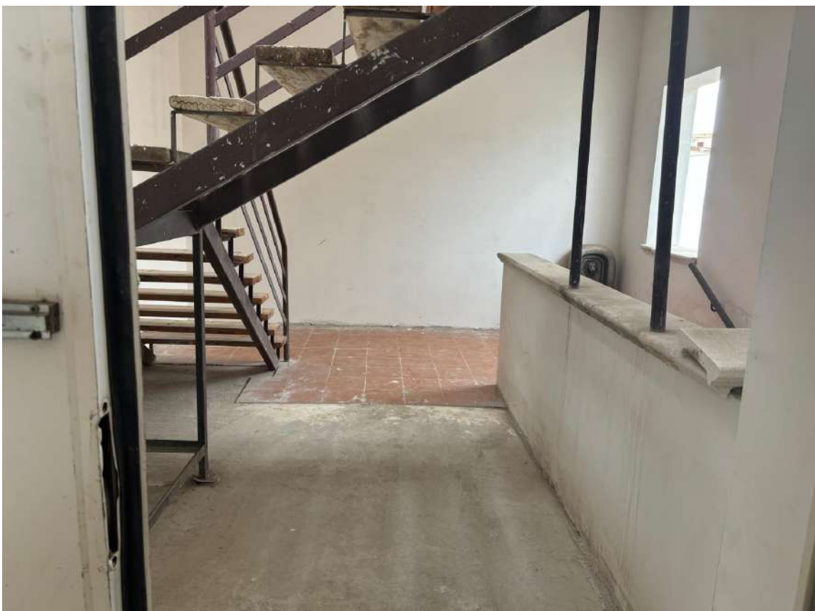
Foto n. 14 – Pianerottolo di accesso al primo piano
