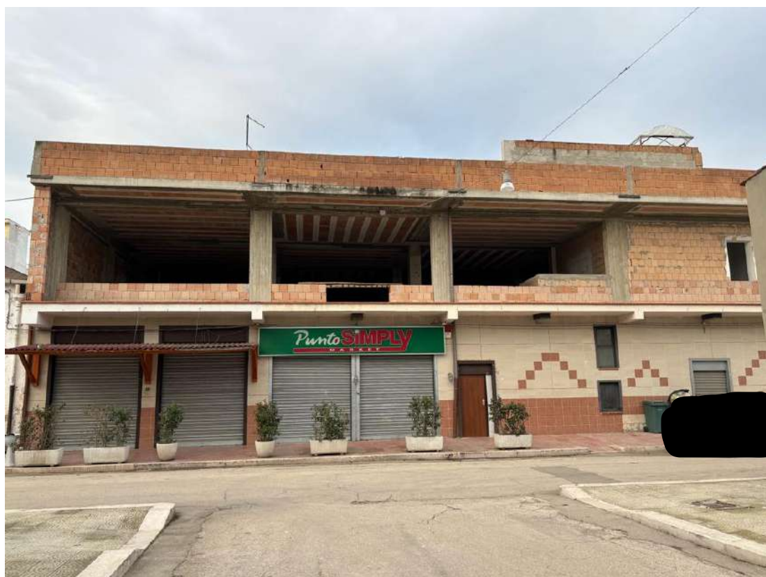
Foto n. 2 - Prospetto di Via Interno Salice n. 61 (primo piano in costruzione)
