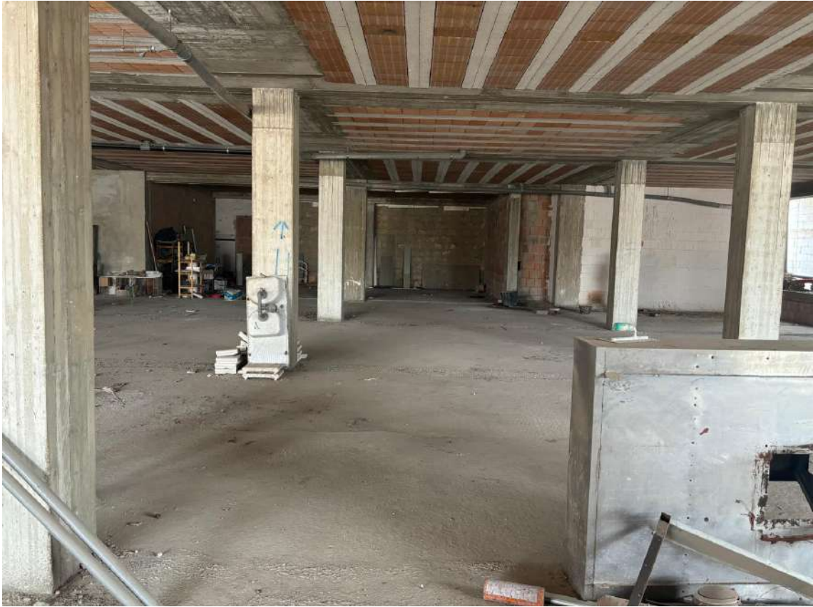
Foto n. 23 – Sub. 3 e corridoio comune (a sinistra)
