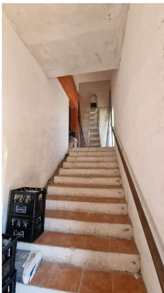
Foto n. 10 – Scala di accesso al primo piano dal civico 61 di Via Salice
