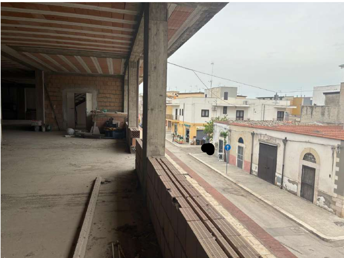
Foto n. 16 – Vista dell'affaccio su Via Salice dal sub 4
