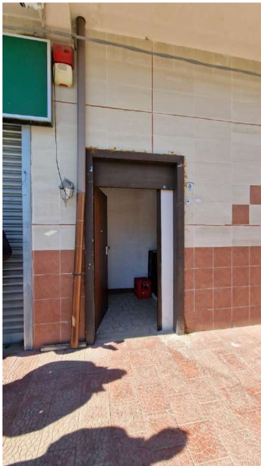
Foto n. 9 – Ingresso dal civico 61 di Via Salice
