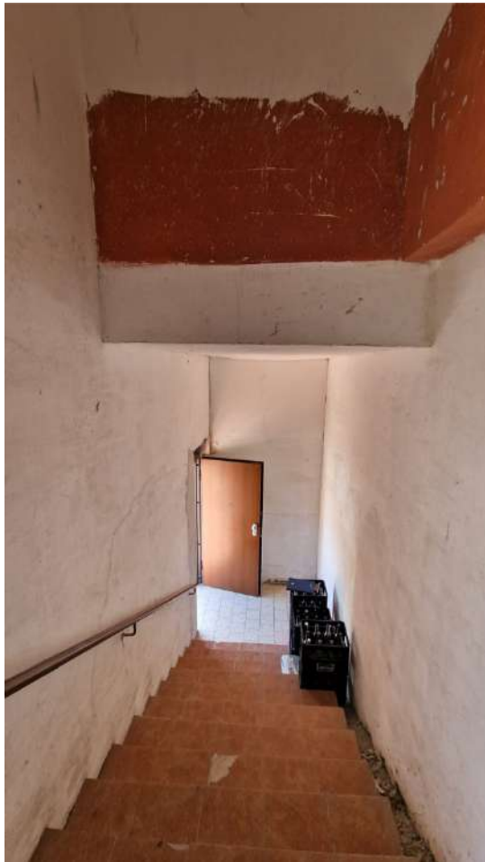
Foto n. 11 – Scala di accesso al primo piano dal civico 61 di Via Salice
