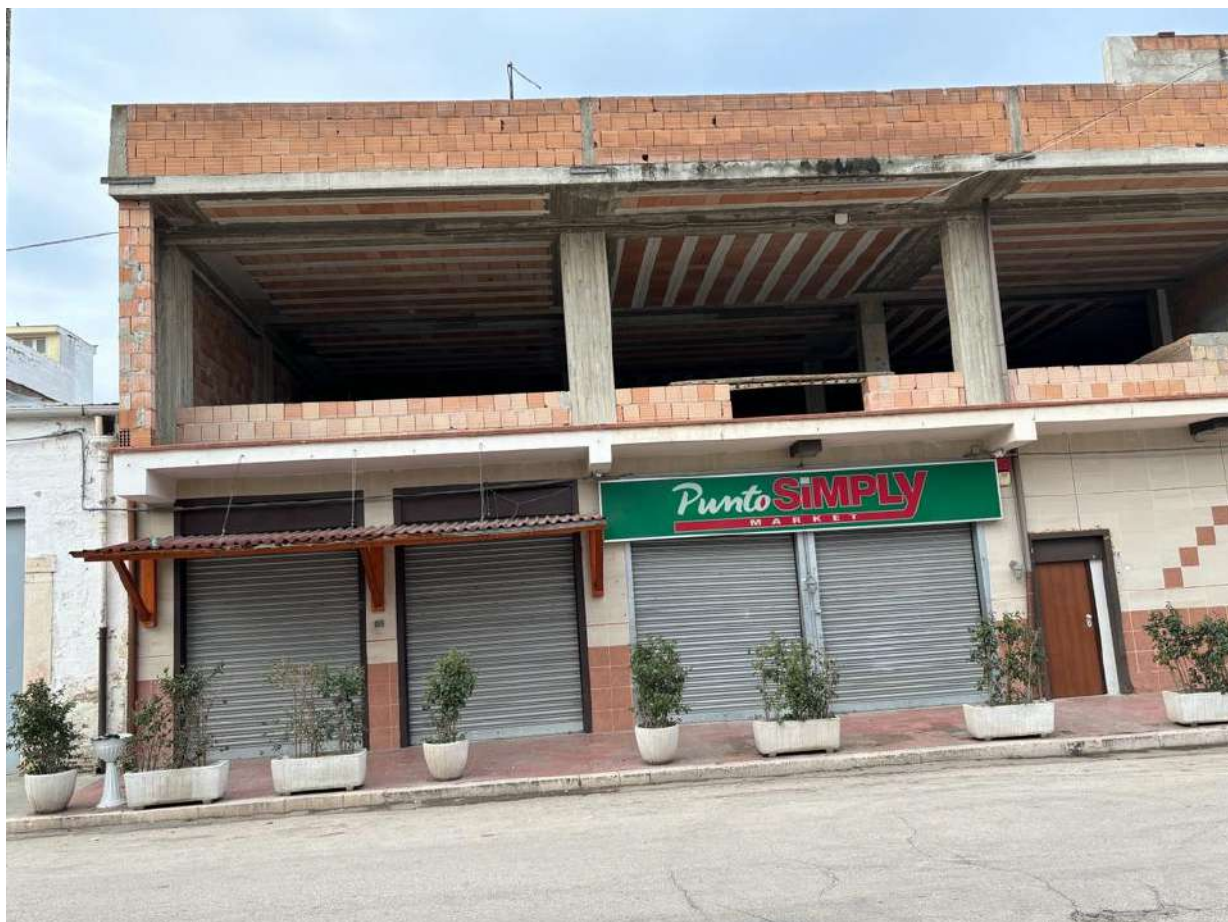
Foto n. 5 - Prospetto di Via Interno Salice n. 61 (primo piano in costruzione)
