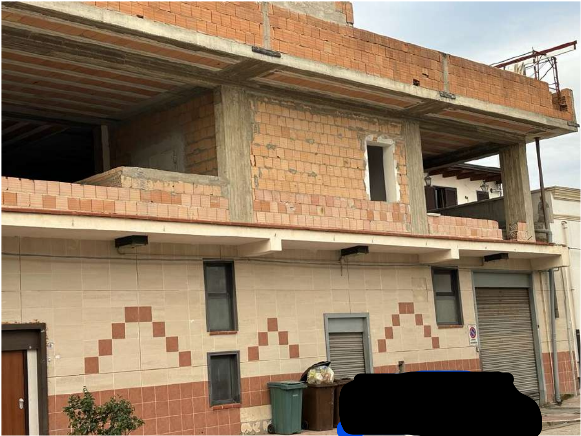
Foto n. 3 – Particolare del prospetto di Via Interno Salice n. 61 (primo piano in costruzione)
