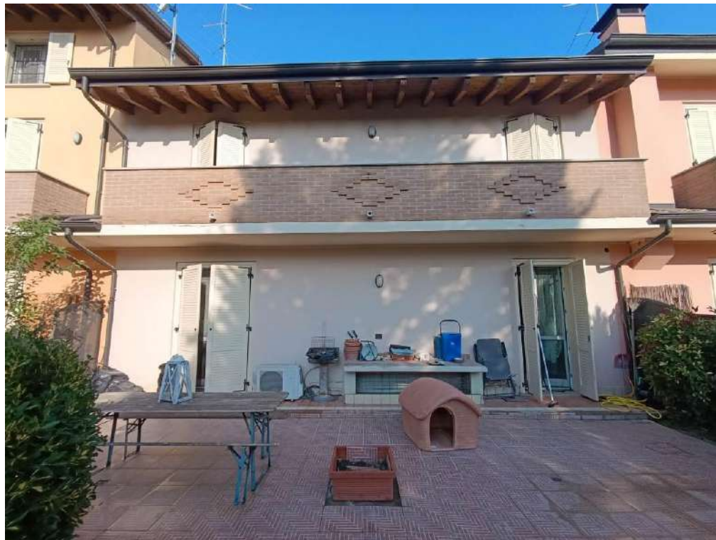
FOTO 3 – ESTERNI RETRO ABITAZIONE
